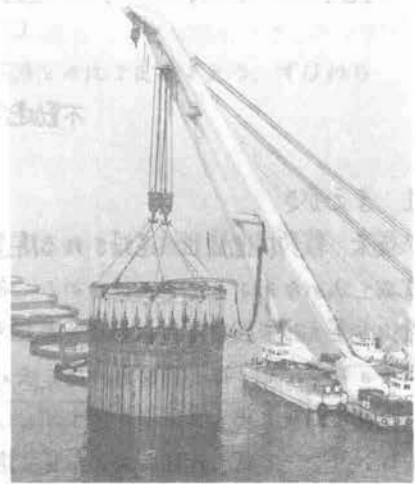
(写真-1) クレーン船による施工状況
