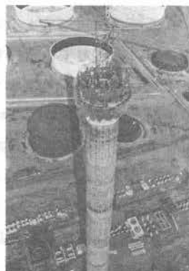
写真-1 施工全景
