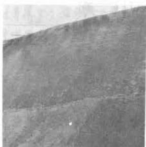
写真-1 仕上り後の法面
