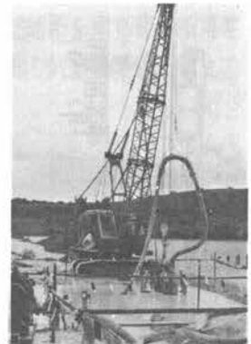
写真-2 テスト現場
