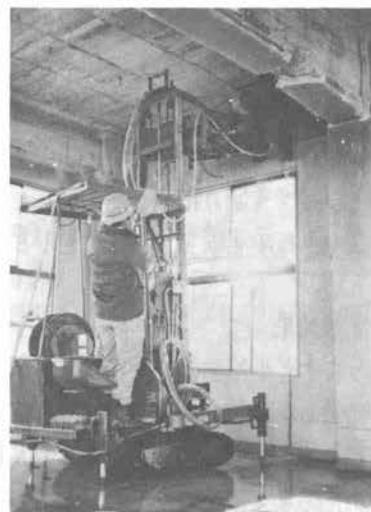
写真 万能機の切断作業
