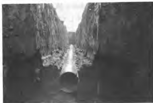
写真-2 埋設状況の確認
