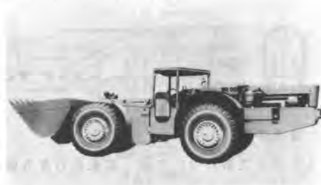
写真-1 ロードホールダンプ(三井アイムコ915H形)
