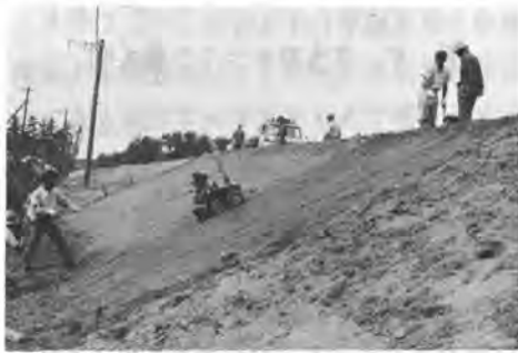
写 2 ウインチ併用テニコンによるノリ面施工 写 3 転圧前の種々散布による植生の速成
