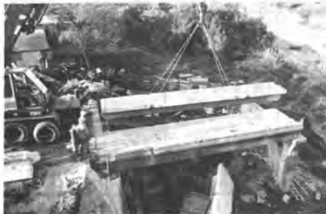
写真-2 カッタによる床版解体状況
