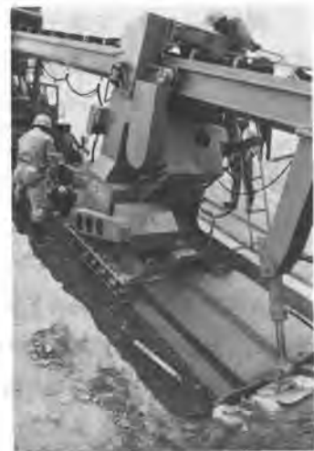
写真-2 スライディングフォームと打設コンクリート版面状況
