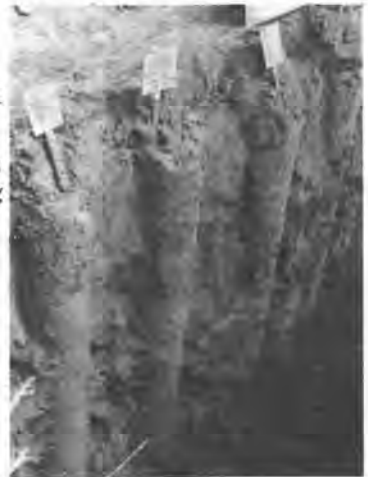
図面-1 東北新幹線 現場試験 W/C=100% 注入率=70%
