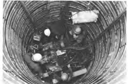
写真-3 掘進作業
