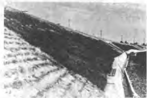
写 2 ウインチ併用テニコンによるノリ面施工 写 3 転圧前の種々散布による植生の速成
