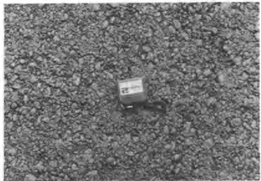
写真-3 舗装仕上り路面
