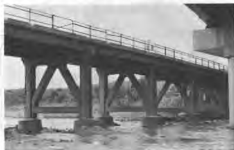
写真-1 旧荒井橋全景（右端新橋）
