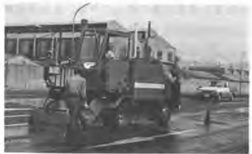
写真—1 粗面の成形作業
