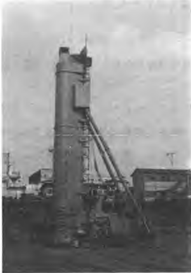
写真-1 防音カバー付杭打機
