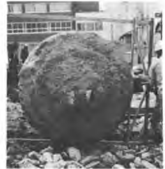
写真-3 拡底部寸法検測
