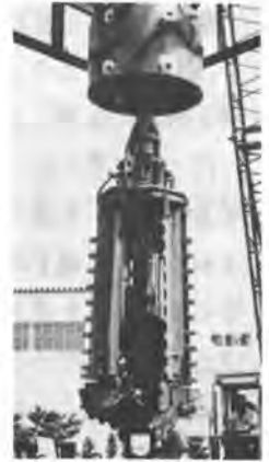
写真-1 シャフト部掘削時
