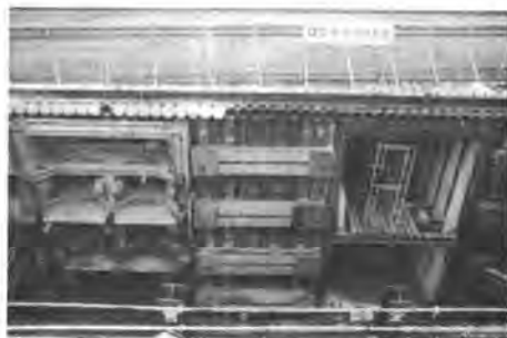
写真-2 OSA機による掘削完了状況
