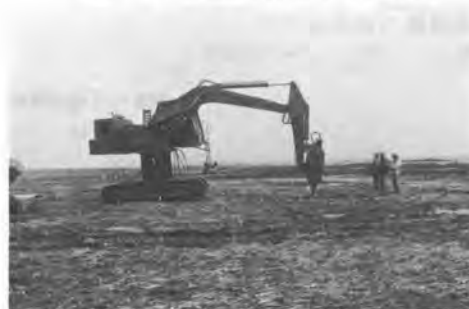
ブレーカーによる砕岩（干出時）
