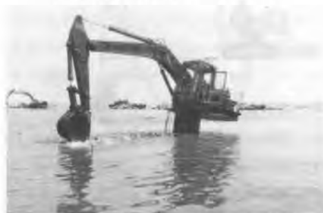
水中掘削中のシャローショベル
