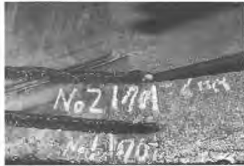
写真-1 モルタル付着部の切断状況
