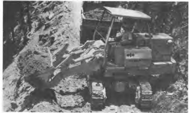
写真1 林道工事中のSH09スイングショベル
