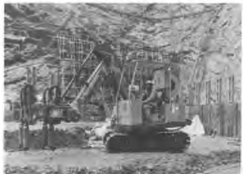
写真-1 油圧バイブロリーチ
