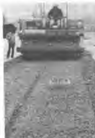
写真-6 2回目転圧後の表面状況
