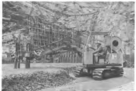
写真-2 コンクリート締固め状況
