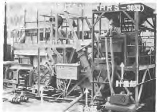
写真-1 連続固結処理プラント（HRS-30型）
