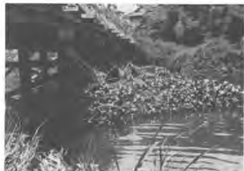
写真-1 橋脚に繁茂したホテイアオイ
