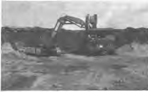
写真-3 道路工事で稼働中のUH30
