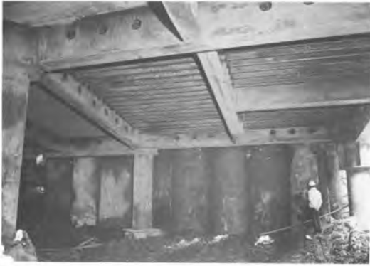
写真-1 完成した柱列杭式土留壁
