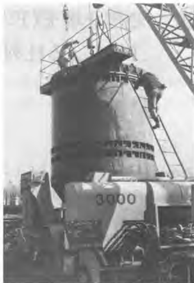
写真-2 コンクリート打設
