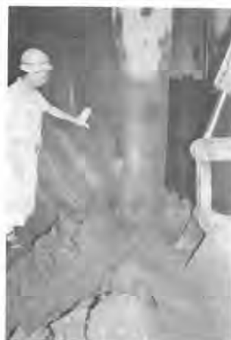
写真-2 埋戻し部の掘削状況
