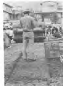
写真-8 7回目転圧後の表面状況
