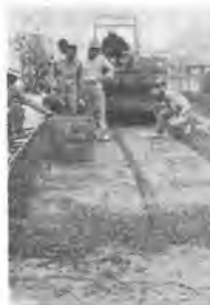
写真-7 6回目転圧後の表面状況
