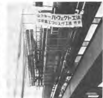
防護工吊り上げ固定状況
