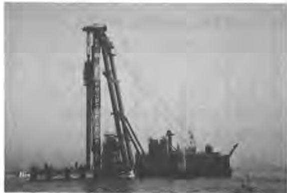
写真-3 DCM深層混合処理機と架装船
