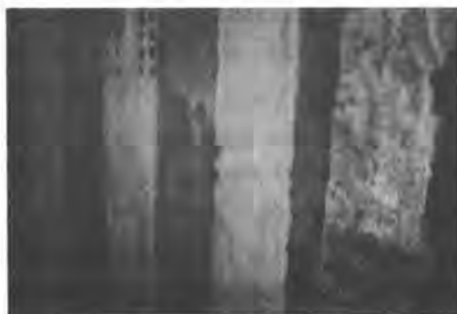
写真-1 掘り中の山留壁
