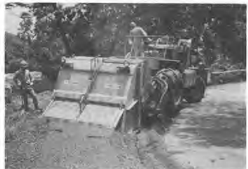
写真-3 施工状況(破砕)
