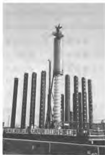
写真-1 施工状況
