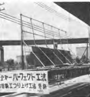
防護工地組状況
