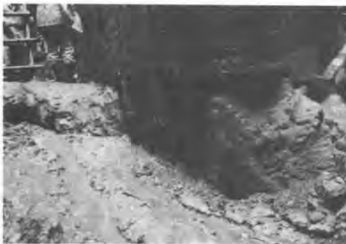
写真-2 壁体先端の掘削状況
