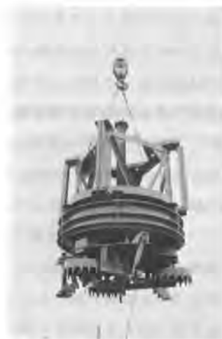
写真-2 刃先下掘削状況
