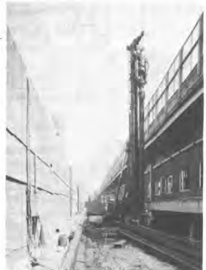
写-2 圧入機取付DHJ
