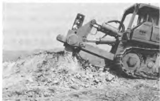
写真-2 同所破碎後のリッピング
