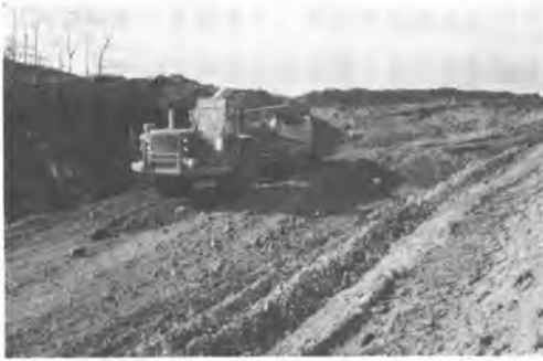
写真-2 厚木ニュータウン工事現場
