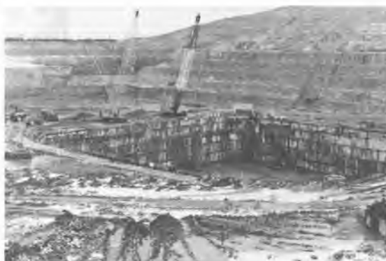
写真-1 二次掘削工事の状況
