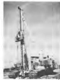
写真-1 噴射注入実用実験機
