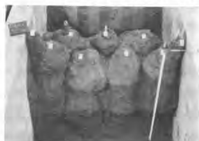
写真-4 ダブルバッカー工法
