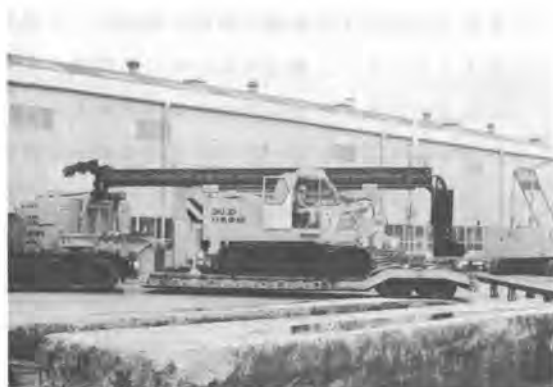
写-1 トレーラ輸送状態
