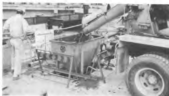
写-3 鉄橋上に設置
