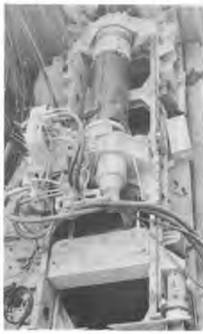
写真-2 施工状況
