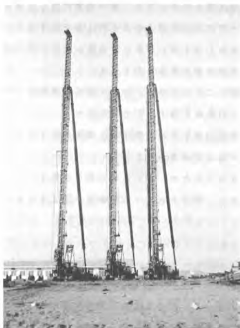
写真-1 打設機全景
