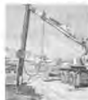
垂直縫地施工状況
