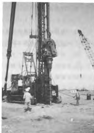
写真-2 現場打設状況
