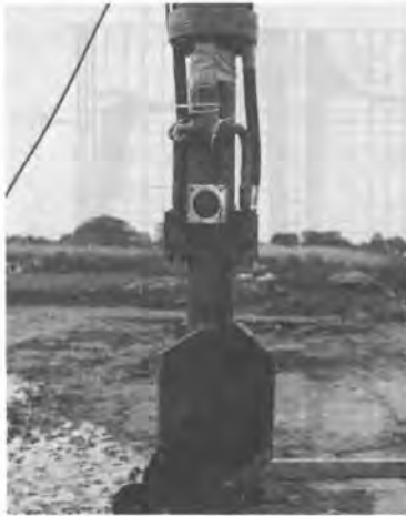
図-2 高圧水噴射ノズル
