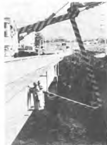
写真-1 一般に行なわれている橋梁点検車による点検
