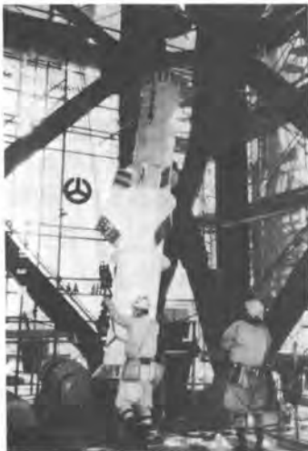
写真-4 柱吊込み
