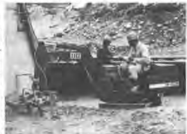
写真-1 機械施工の場合
