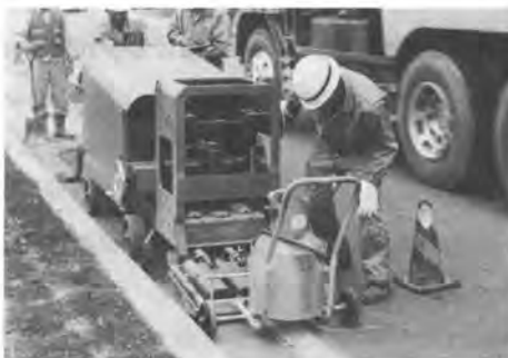
写真-3 加熱方式による切削状況
