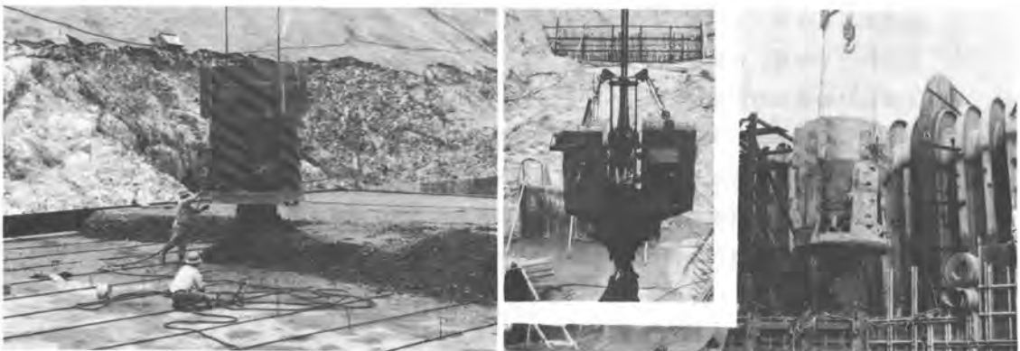
写真-1 従来のコンクリート打設状況
