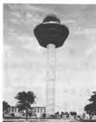
写真-3 リフトアップ後
