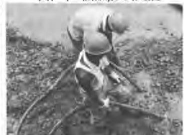
写真-2 人力施工の場合
