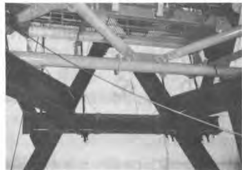
写真-5 鉄塔受け架台
