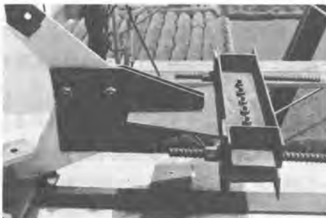
写真2 トラス引点部
