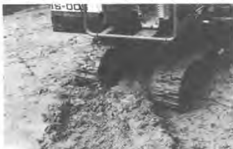
写真-3 走行状況
