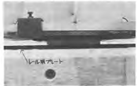
写真1 スライド支承部
