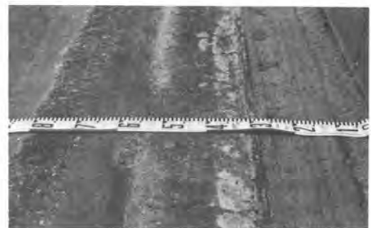
写真-4 切削後の路面状況
