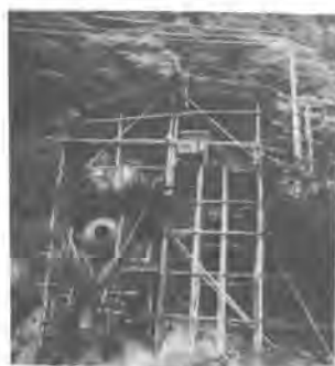
写真-1 現状プラント
