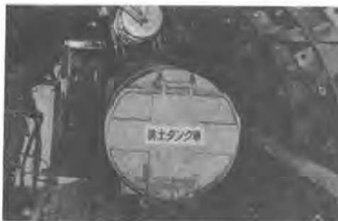
写真-1 掘進状況
