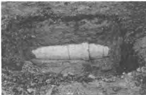
写真 3 PSS工法 ヒューム管の囲りと固化後削削
