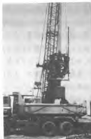
写真2 自動排土装置使用状況
