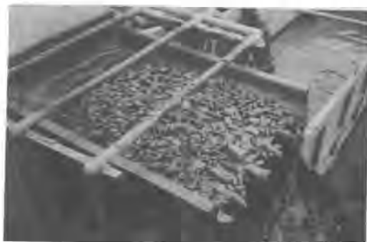
図-3 振動フルイによるシルト混り粘濁層の掘削土砂分離状況
