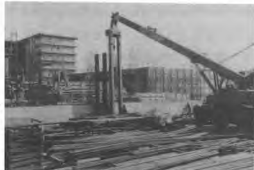
写真-3 引抜き状況
