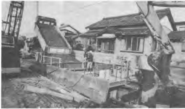
埋設後の埋戻し作業
