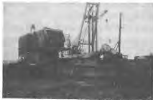
図-6 泥水処理システム設置状況
