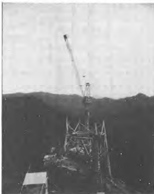
写真-1 CT45クライミングクレーン
