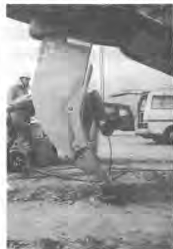
写真1 掘削力の計測
