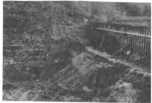
写真-2 GL-9.0 m 付近の掘削状況
