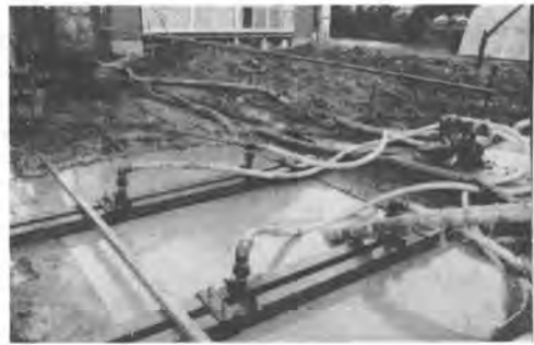
写真-2 吐出管等の配置例（PSS工法）
