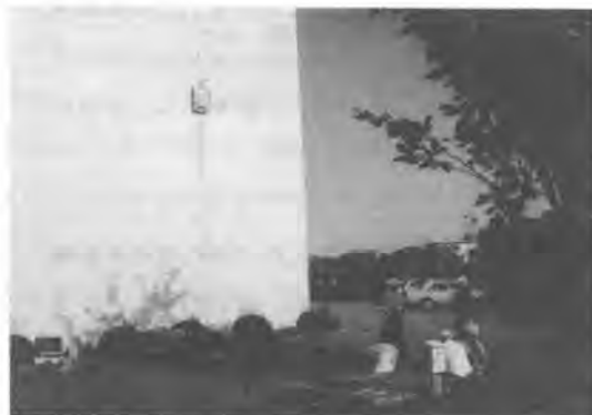
（壁面を調査中の走行機）
