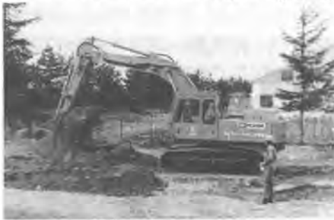
写真1 バケット作業
