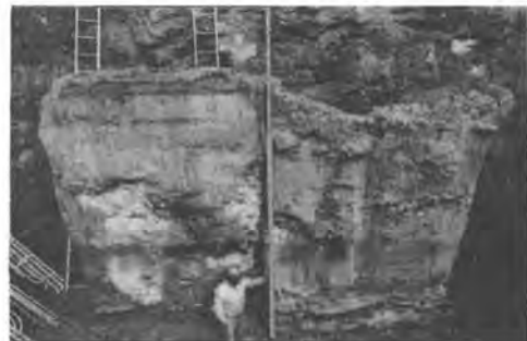
写真 4 泥水固化壁
