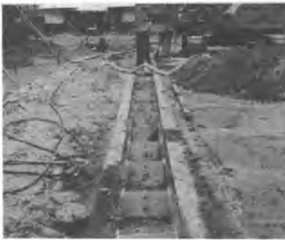
写真-2 埋設状況
