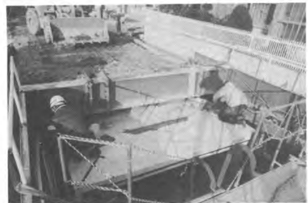
↑ボックス・カルバートを定位置に吊り降した状況
