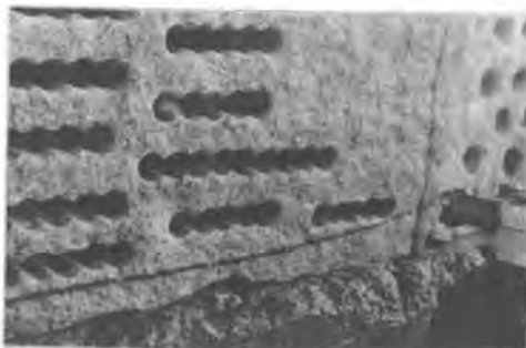
写真-2 スロット
