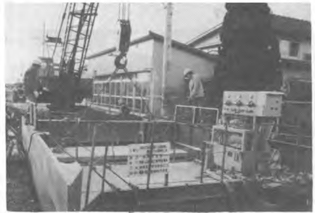
↑ボックス・カルバートの目地作業
