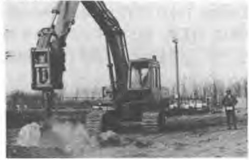
写真2 ブレーカ作業
