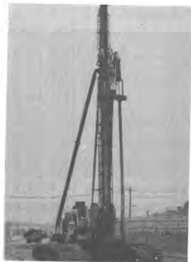
写-1 従来の振動貫入式打設機
