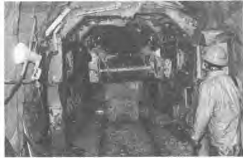
写真2 ロッカーショベル通過時
