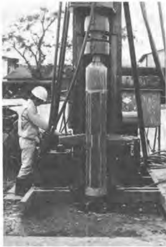
写真-1 拡幅装置(φ1000)
