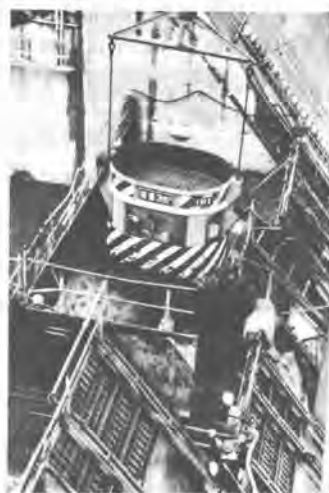
写真-1 コンクリート打設状況
