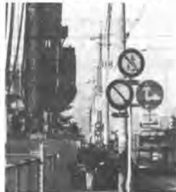
(写真-4) 隣接工事の例
