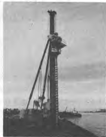
写真-1 砕石ドレーン施工機の全景
