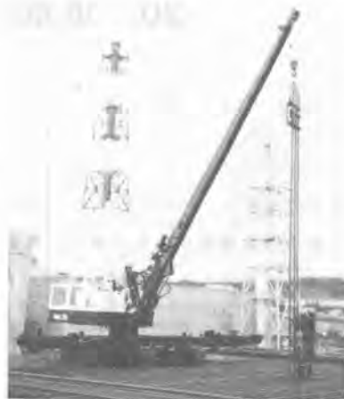
写真-2 クレーンアタッチメント交換による垂直配筋作業状況
