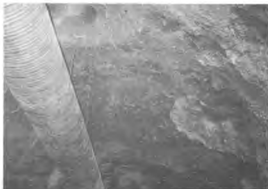
写真-2 湧水箇所での施工(従来工法)
