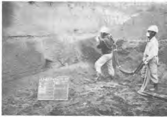
写真-1 吹付けコンクリート施工
