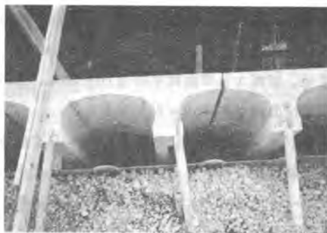
写真-3 据付られたπ型ブロック
