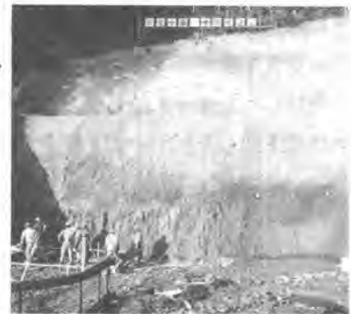
写真3. トンネル坑口斜面施工状況
