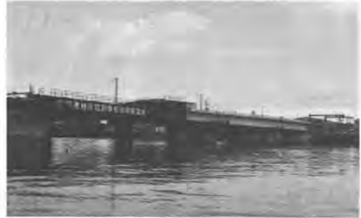
写真-1. 押し出し施工全景
