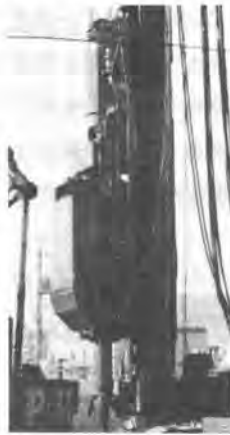
(写真-2) 小松中掘機
