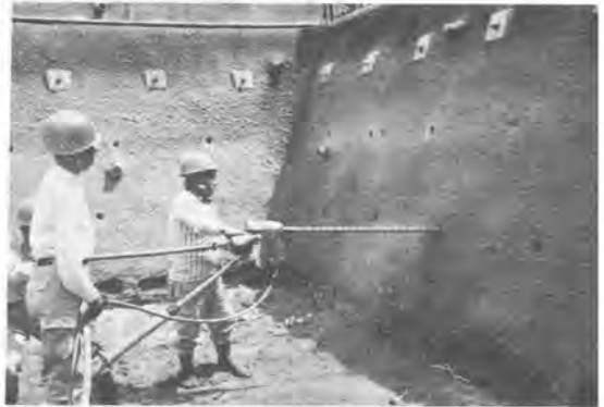
写真-2 レッグハンマーによる穿孔
