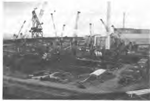
写真-1. タワークレーン稼働状況
