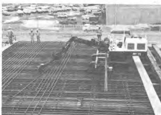
写真-4 配筋装置ビームの水平首振り状況
