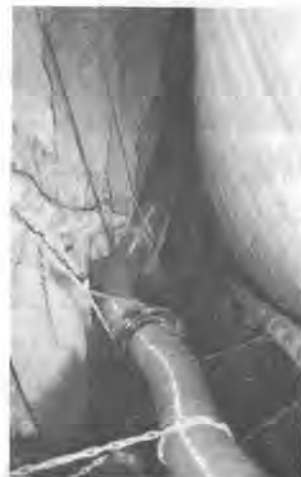
写真3 フレキシブルホースによる コンクリート打設状況
