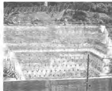
写真4. 根切り掘削施工状況
