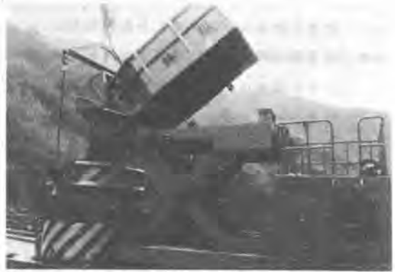
写真-2 コンクリート受入状況
