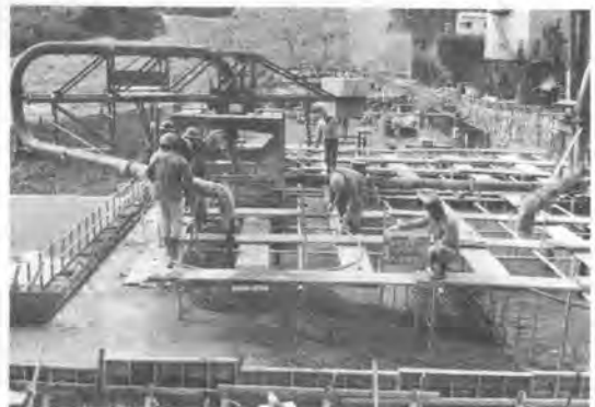
写真-3 ディストリビュータによる打設
