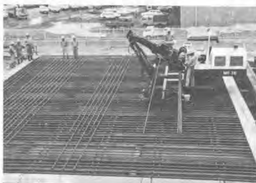
写真-3 配筋テスト状況
