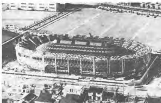
写真-3.1 プッシュアップ前の現場状況
