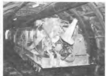
写真-8. 2号機トンネル掘削中の様子
