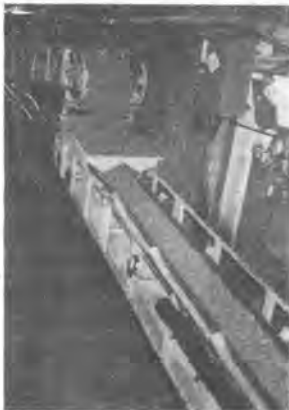
写真1 ベルトコンベヤーによる コンクリート輸送状況
