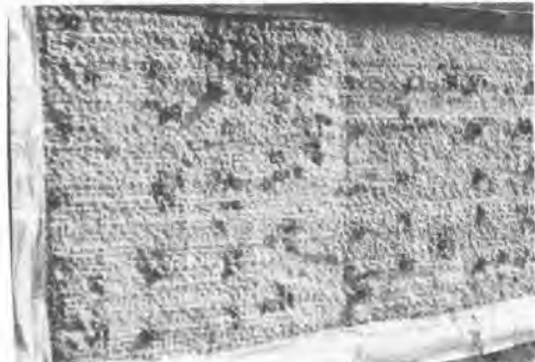
写真-2 目荒し処理後の壁面状態
