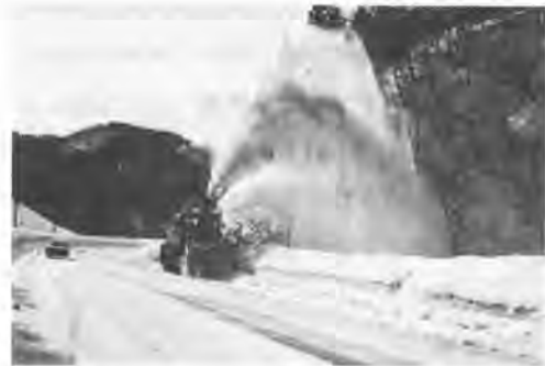
写真-1 ロータリ除雪車拡幅作業
