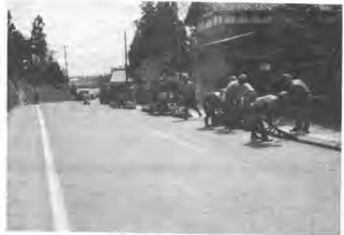
写真-3 施工状況
