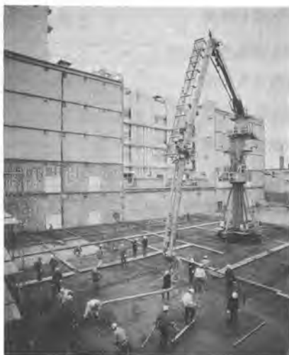
写真-1 コンクリート打設作業全景
