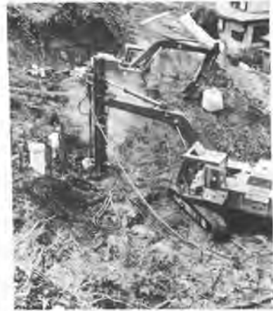
写真-1 混合機全景
