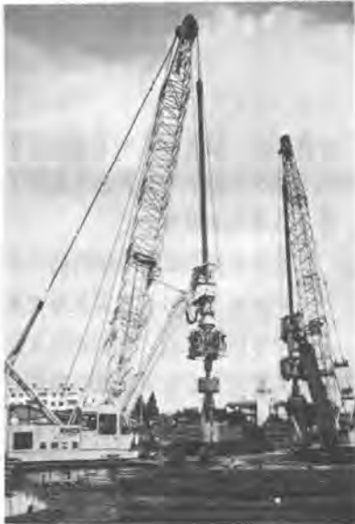
写真 施工状況
