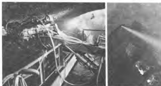
写真-4 NATMサイロット壁の切断
