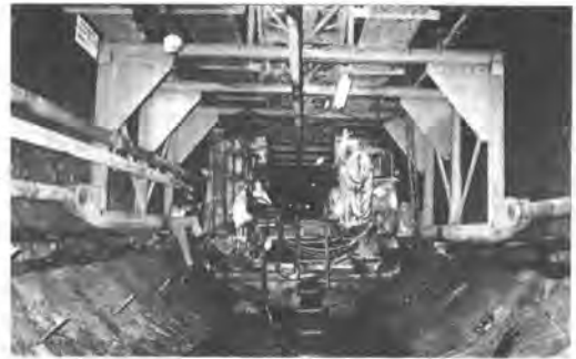
写真-2 インバートセトルとトレンコンベヤー
