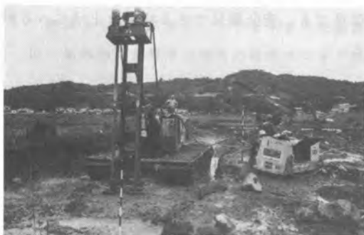
写真-7 MSH-10. KMY-05-2型 (超軟弱地用5m級2軸)
