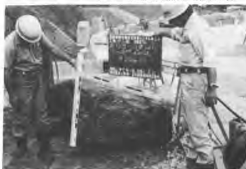
写真-2 掘り出された岩盤(チャート)
