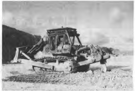
写真3 リッピング作業状況
