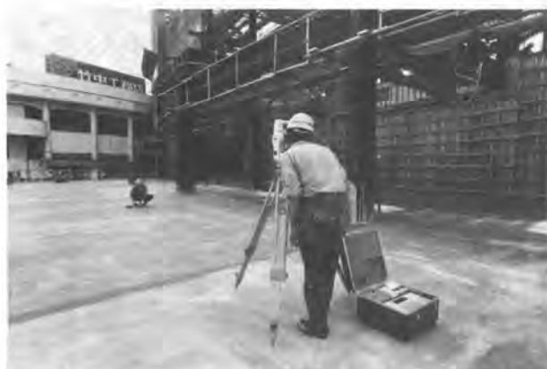
写真-1 システム構成機器と設定作業
