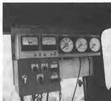
写真-3 運転室内の監視装置
