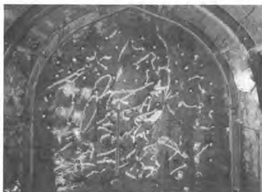
写真-1 スリット切削後の切羽状況
