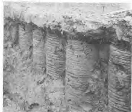
写真-1 改良土柱の状態
