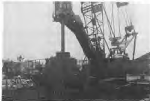
写真-1 掘削状況 (アースドリルの中掘り作業)
