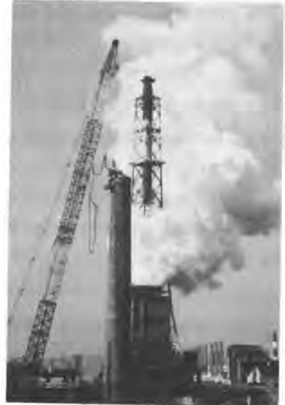
(写真-1) 施工状況
