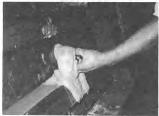
写真1 注入材の充填状況
