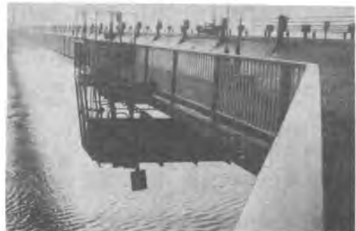
図-6 常備用検査車（英国、ハンバー橋）
