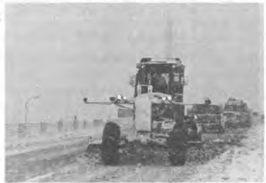
写真-6 一車線ワンパス除雪作業
