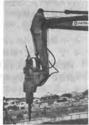
写真-1 防振ブラケット取付状況
