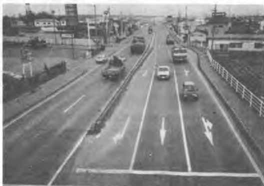
写真-1 多車線道路状況
