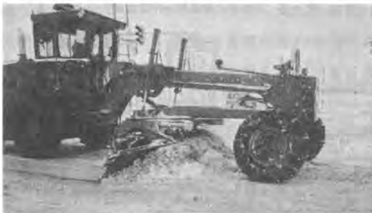
写真-7 作業幅員6mで交差点内の除雪作業
