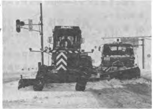
写真-5 除雪作業状況
