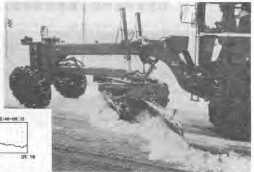
写真-8 ブレード負荷状況と雪の流れ
