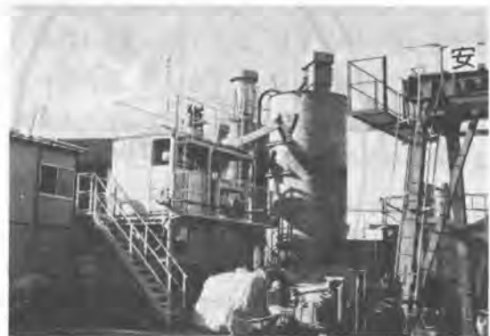
写真2 プラント全景
