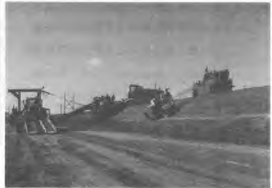
写真-1 施工状況
