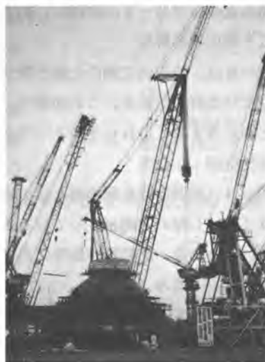
写真-1 タワークレーン設置状況
