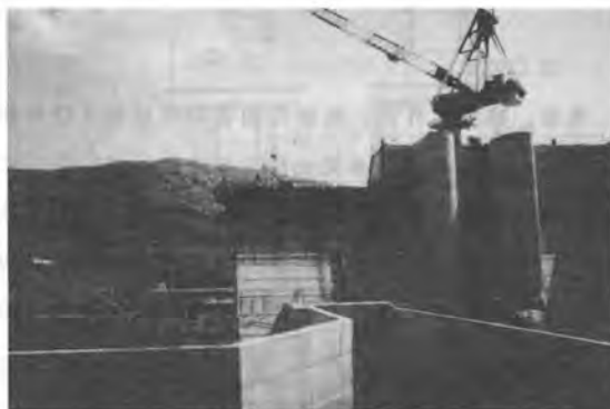
順調に稼働中の3基の自動式型枠(写真-3)
