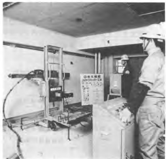
写真-1. 仙台宮城野団地壁切断
