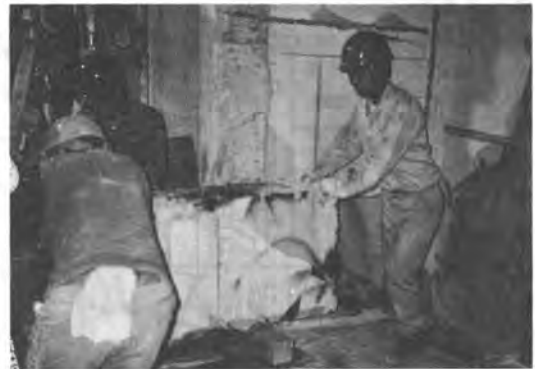
写真4 ブロック搬出状況
