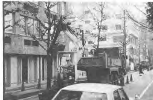
写真1. 配電線地中化工事
