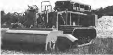
写真-8 草刈装置を装置した状況
