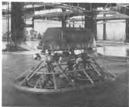
写真-3 コンクリート直仕上げ機 "サーフロボ"
