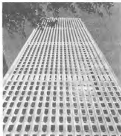
写真-1 対象ビル外壁
