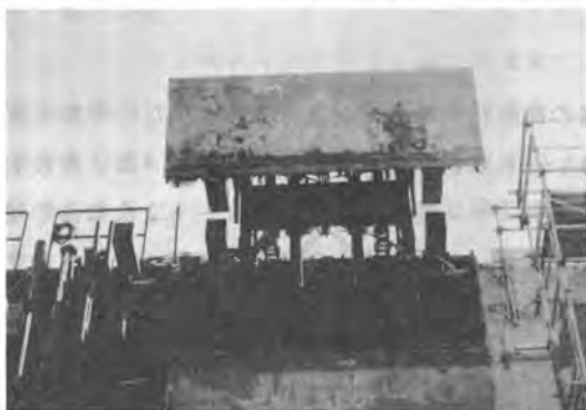
回転上昇中の自動式型枠(写真-2)
