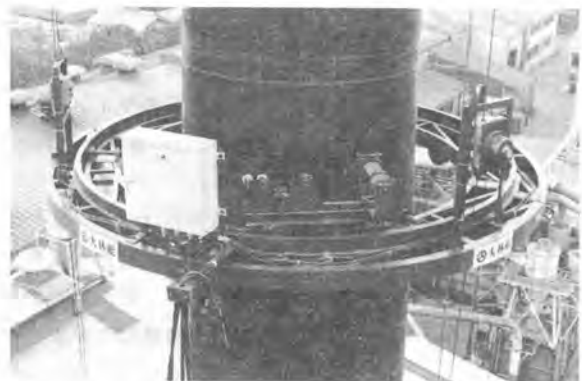
写真-3 煙突にCFストランドを巻付中
