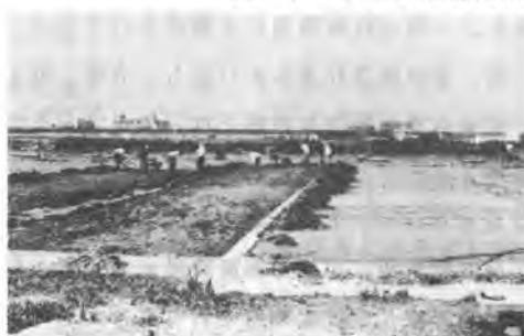
写真-3 メカ施工による処理作業
