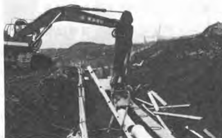
写真-4. ヒュム管敷設状況
