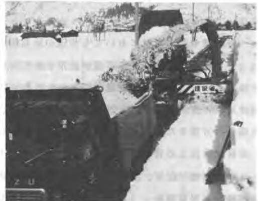
写真-4 ダンプトラック積込み状況
