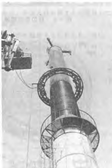
写真-2 煙突にCFストランドを巻付中 (左手に見えるのは高所作業車)
