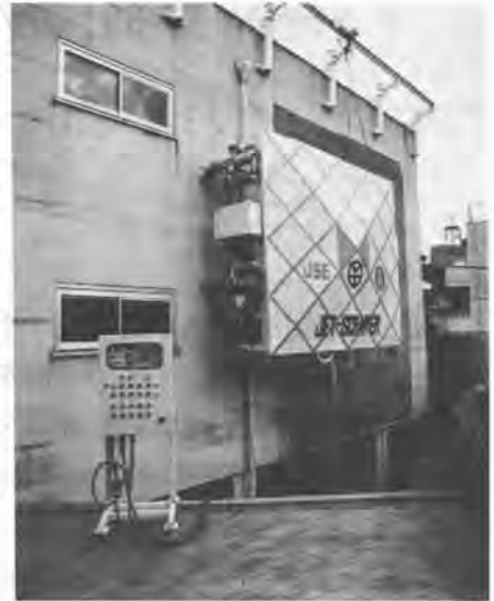
写真-6 外壁塗膜剝離ロボット "ジェットスクレーバ"
