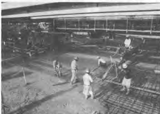
写真-1 コンクリート水平ディストリビュータ
