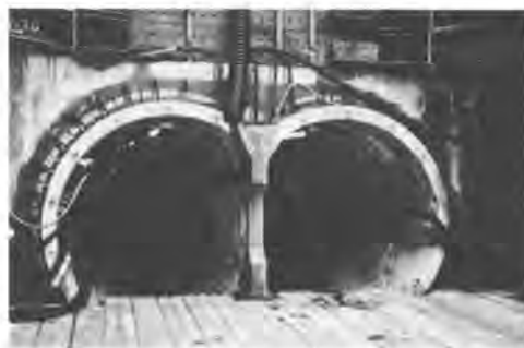
写真-2 施工完了全景
