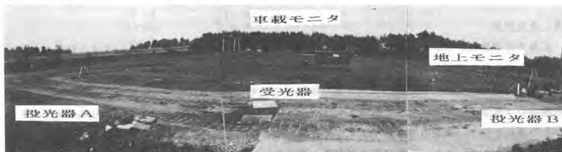
写真-1 作業現場におけるシステムの設置状況
