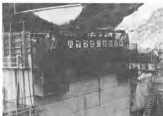
写真-1 施工状況（鉛直面用）
