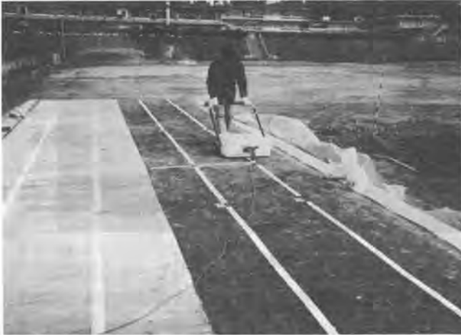
写真-2 探查試験中の地中レーダ
