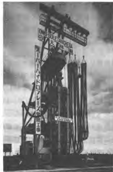
写真-1 スーパーハイドロフレイズ掘削機
