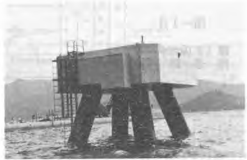
写真-1. 完成した海上アンカー
