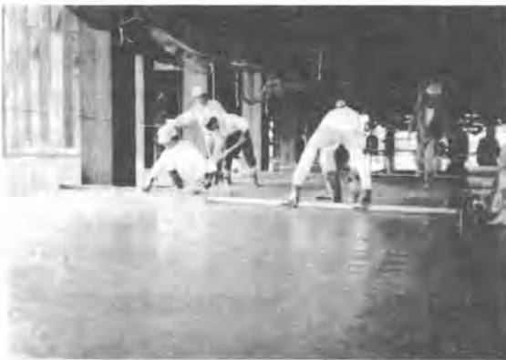
図-1 定規ずり作業
