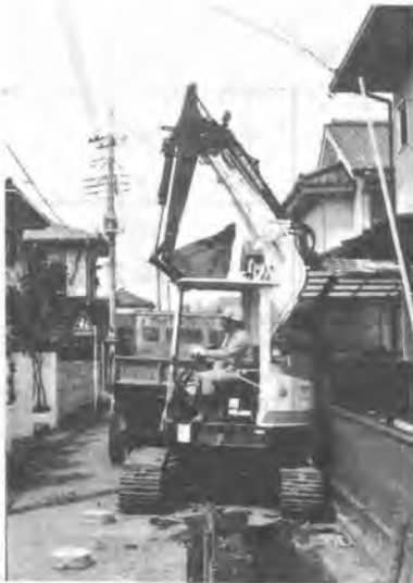
写真2. 住宅地での下水管理設工事
