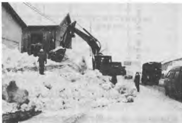
写真-1 バックホウによる高雪堤処理
