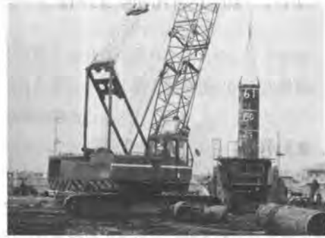
写真-3 八戸市立東中学校新築工事
