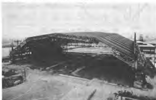
写真-1 リフトアップ後のHANGAR
