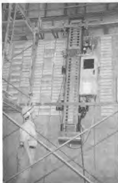
写真-1 タイル張りロボット実用機
