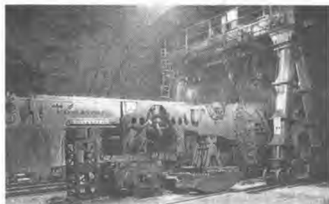
写真-2 坑内組立
