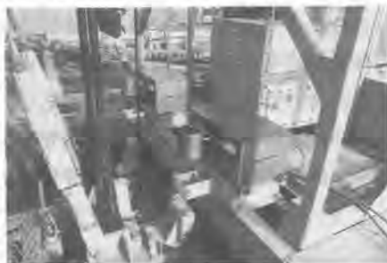
写真-1 差動トランス方式の検出状況
