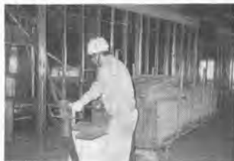
写真-4 取り卸し階での牽引
