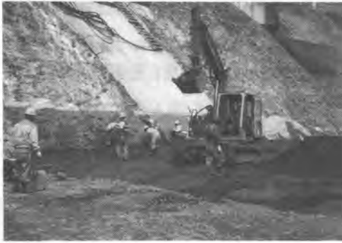
写真-1 人力作業状況
