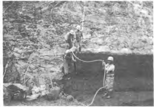
写真-2 人力転圧状況
