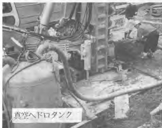
写真-2 オーガ削孔残土の泥土搬送
