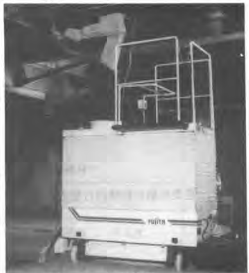
写真-1 施工状況
