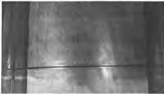
写真2. 水中切断後の鋼管矢板
