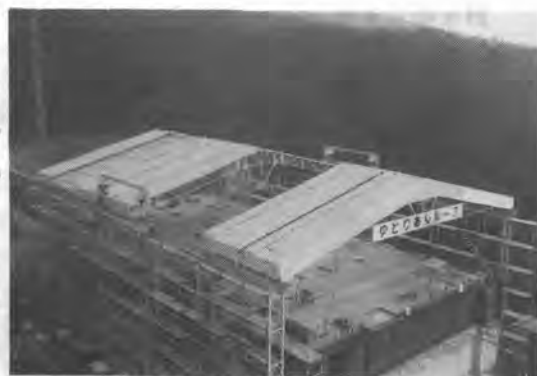
写真2. 通常施工時(屋根一部開)
