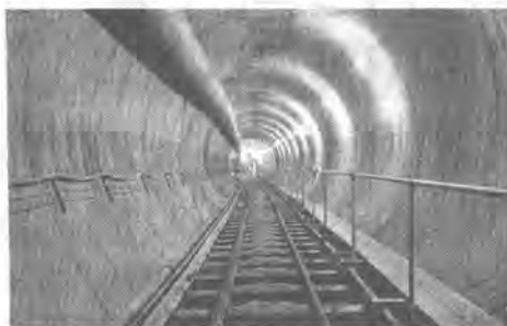
写真-4 支保工のない区間
