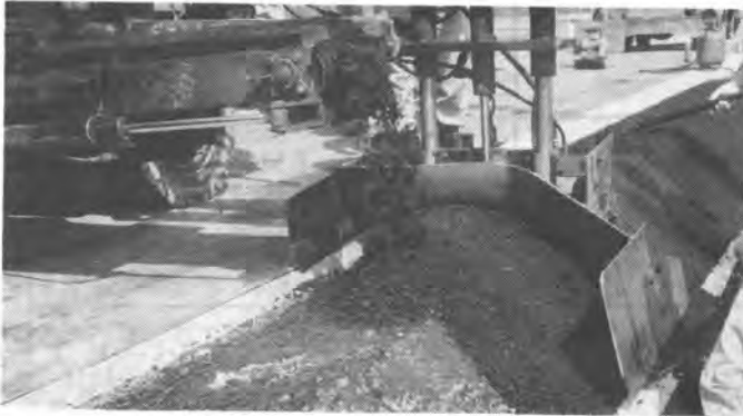
路肩舗装に（ベルトコンベアタイプ）
