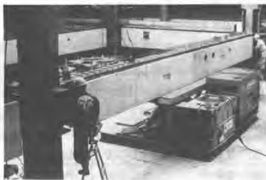
ATBによるPC梁取付作業状況
