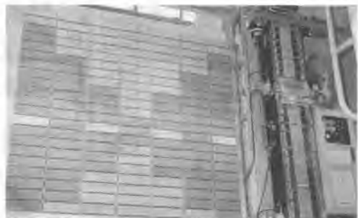
写真-2 タイル施工仕上げ面
