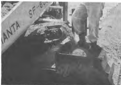
路肩盛土に（ベルトコンベアタイプ）
