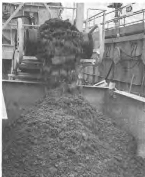
写真-3 ケーキの排出状況
