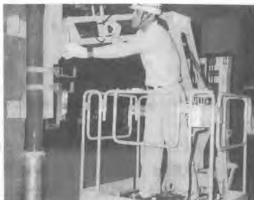
写真-7 縦パイプの施工
