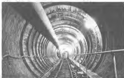
写真-5 支保工区間
