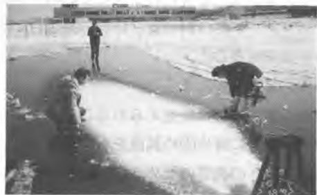
写真-3 新雪の排出状況
