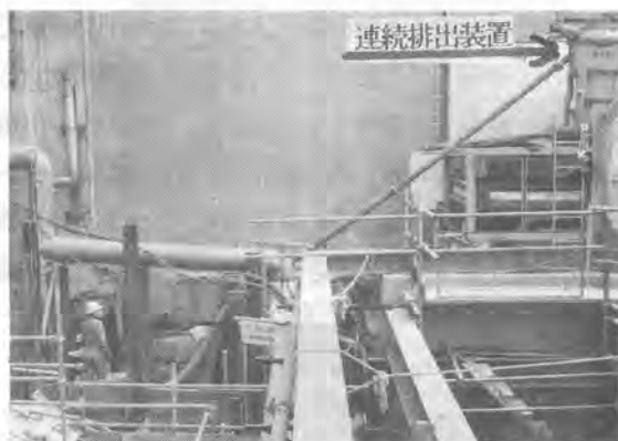
写真-3 エレベータビット掘削工事のズリ搬送
