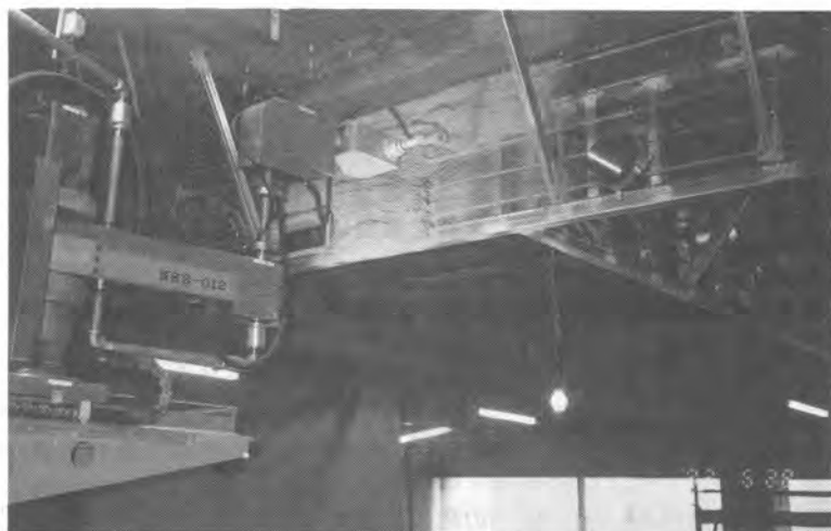
写真3 垂れ壁への吹付け状況
