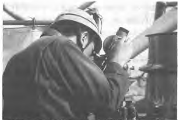
写真-2 従来法による鉄骨建て入れ位置決め作業
