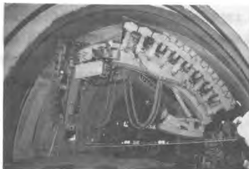
写真-2 K-N T L 工法機施工状況
