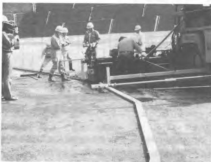
写真-2 電磁誘導方式による自動操向施工状況
