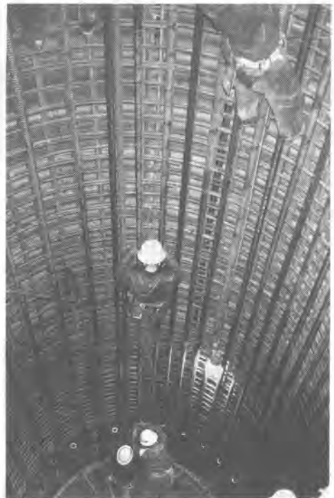
写真-4 D51組立状況
