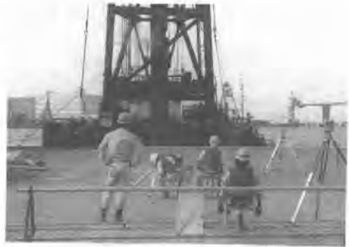
写真-3 レベル計測状況
