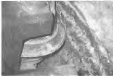
写真-3. 破碎状況
