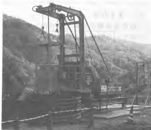
写真 5 深礎工用 Gondola 全体状況
