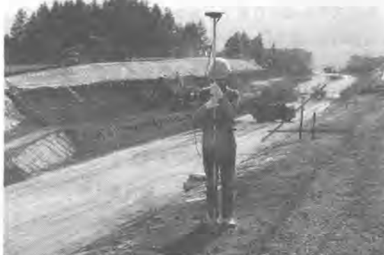
写真-1 GPSによる出来形測量状況
