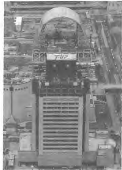
写真-1 T-UP工法の施工状況
