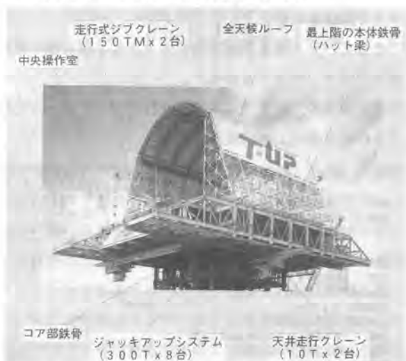
写真-2 最上階部の構成
