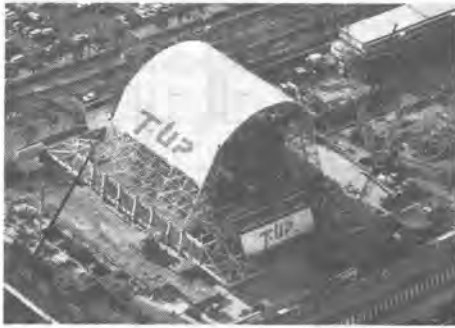
写真-3 最上階部の地組状況
