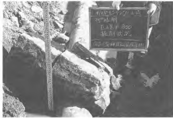
写真-3 巨礫貫通状況
