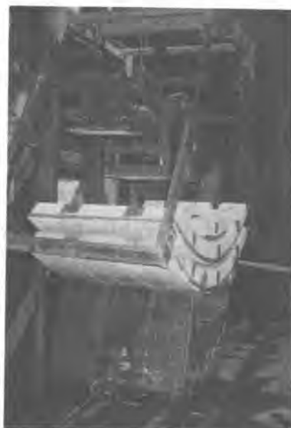
写真-5 立坑下での搭載状況図
