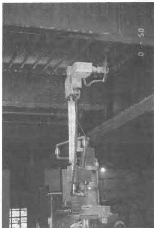
写真4 梁下への吹付け状況
