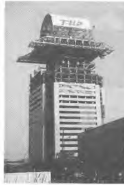
写真-4 基準階建方作業
