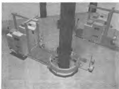
写真-2 柱用溶接ロボット
