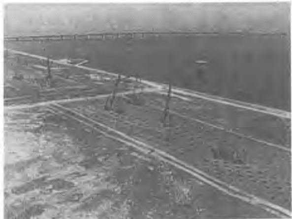
写真-1 関西国際空港施工状況 (滑走路部分)
