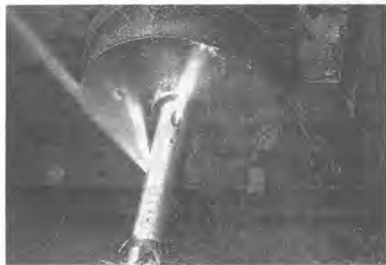
写真-4 面板洗浄システム
