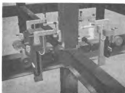
写真-3 梁用溶接ロボット
