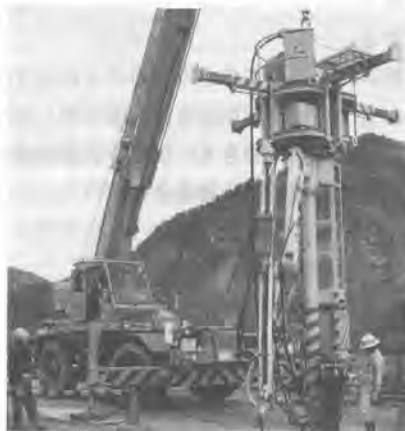
写真-1 削孔機全体状況（サポート張出）
