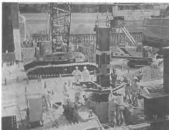
写真2 構真柱の建入れ
