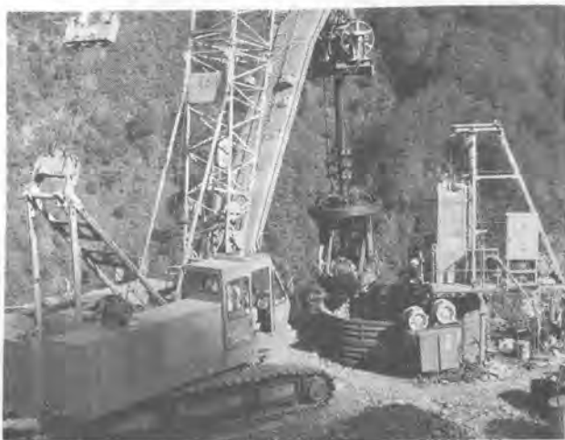
写真-3 HSED機による掘削状況
