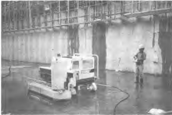
写真-1 水ジェットタイプ施工状況
