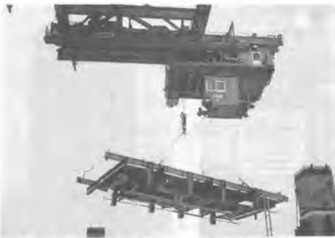
写真-7 天井走行クレーンによる建方作業
