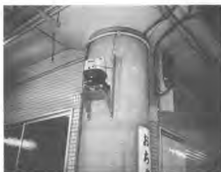
写真-1. スタッフ・レベル取付状態
