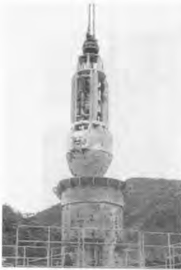
写真2 ハンマグラブ施工状況
