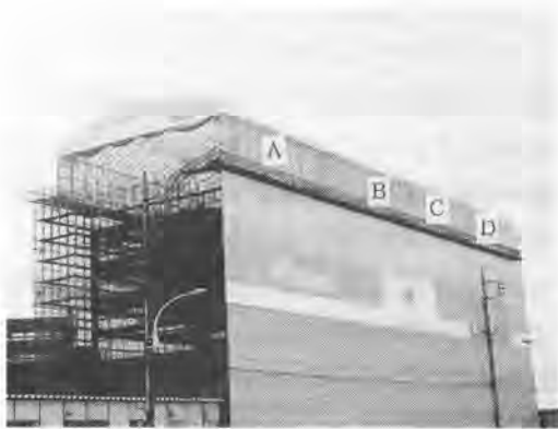
写真1 仮設屋根全景
