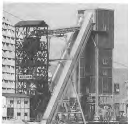
写真-1 小玉ダム骨材真空冷却設備
