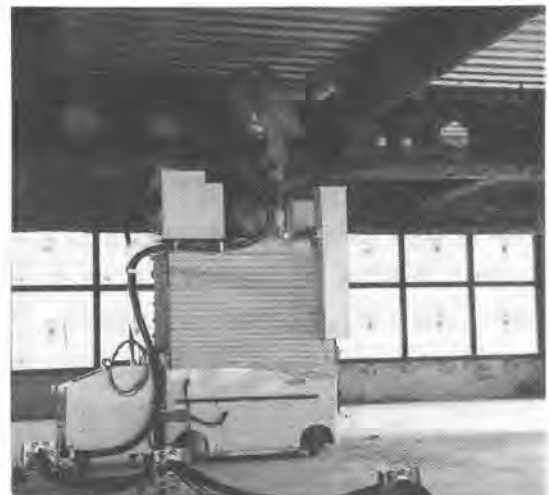
写真-1 作業状況
