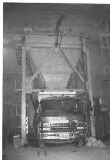
写真-3 現場設置状況
