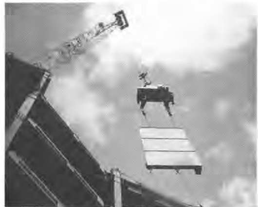
写真-2 施工状況
