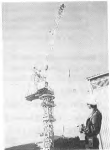
写真-1 工場内実機実験
