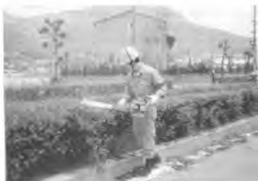
写真-1 人力施工状況
