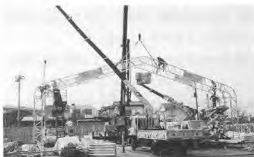
写真2 フレームの組立て
