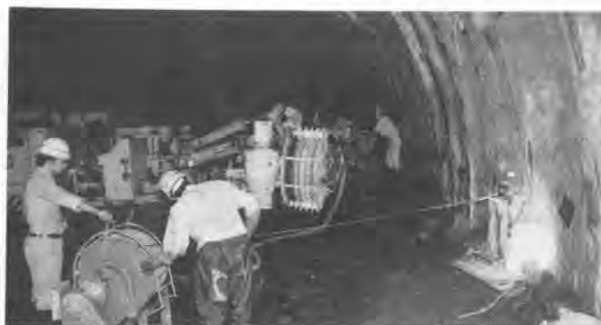
写真5 トンネル先進調査ボーリング現場における試験掘削
