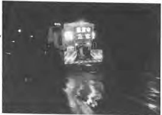
写真-3 作業時の状況
