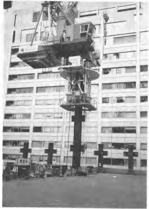
写真2 マスト・コラム工法にて施工中
