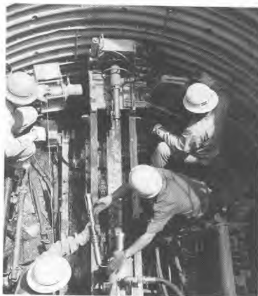
写真4 3.5mライナプレート内での 集水・調査ボーリング インナチューブが回収されてきたところ 中央下で手渡しているのがオーバ・ショット
