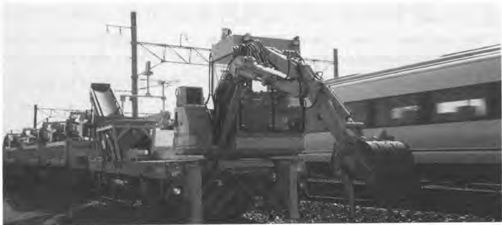
写真-1 道床交換システム
