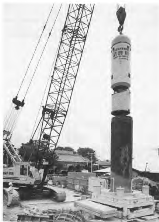
写真1 K-SCAD工法施工状況
