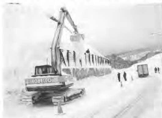
写真-3 防護擁壁開発機械処理状況
