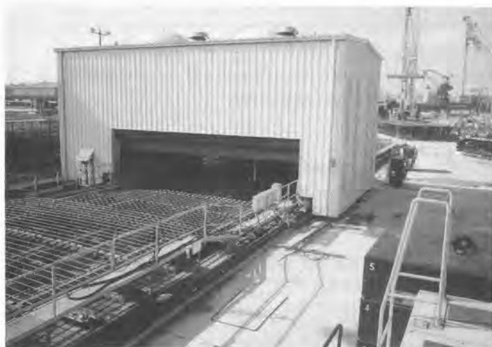
写真－2 「鉄筋籠自動溶接ロボットシステム」 全 景
