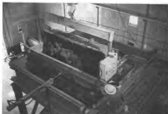
写真-4 掘削残土投入状況
