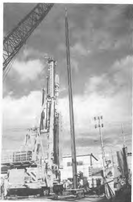
写真-1 芯材挿入および掘削中の低重心三軸機 従来機よりやや時間がかかっている。しかしながら、その後のJ1、J3立坑では、作業に習熟したこともあって、従来機とほぼ同等の能率を得ている。
