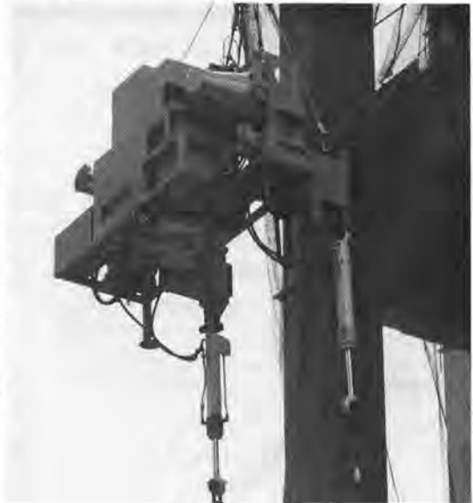
写真-1 施工状況
