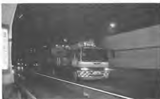
写真-1 トンネル清掃車施工状況
