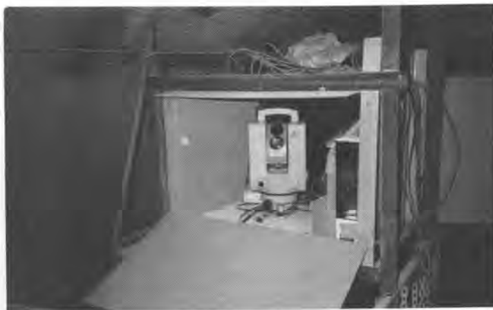
写真-2 測量システム設置状況
