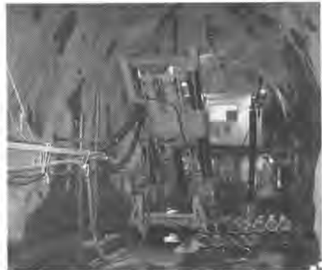
写真-1 機械設置状況
