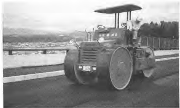
写真-3. 締固め状況
