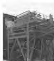
写真-3 実証実験プラント全景
