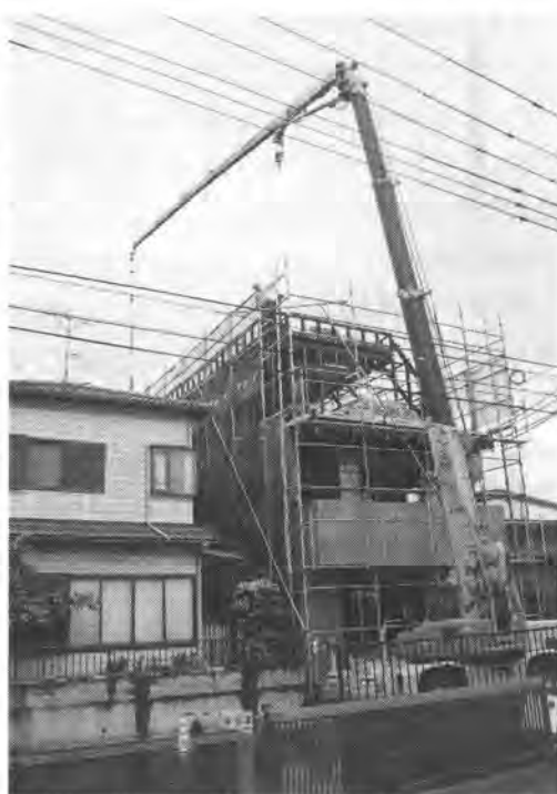
写真-1 ピタゴラスの施工状況
