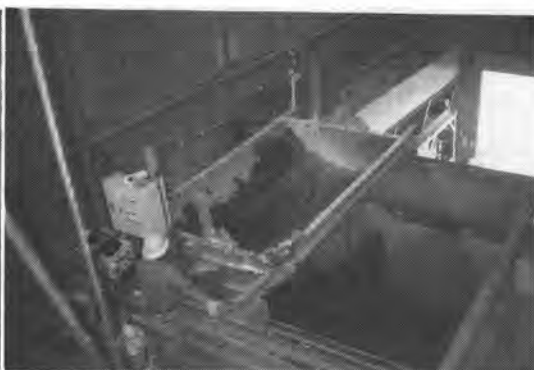
写真-5 攪拌改良状況
