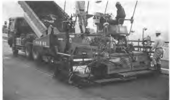
写真-2. 施工状況
