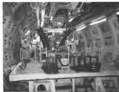
写真-2 供給コンベアーの作業床
