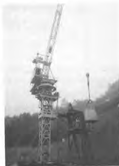
写真-2 ズリ出し作業
