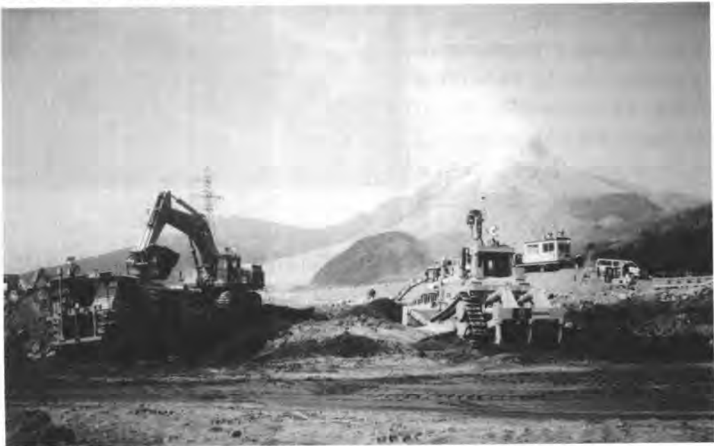
写真-1. 遠隔操作による土工機械の施工状況
