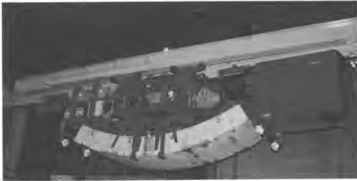
写真1 セグメント移送状況
