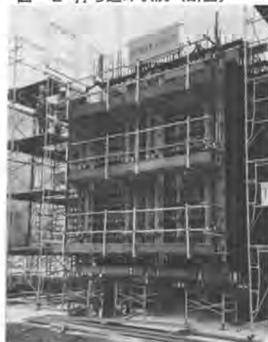
写真-2 モックアップテスト供試体
