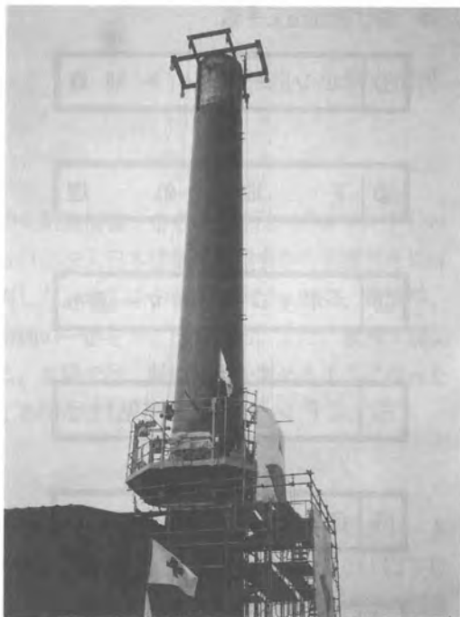
写真2 同CFシート縦方向貼付け
