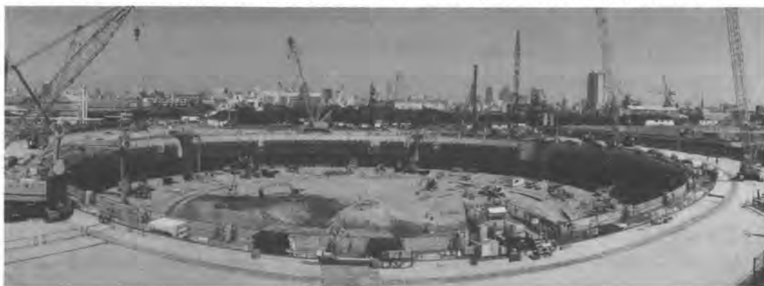
写真-1 現場全景
