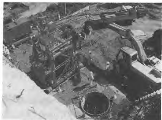
写真一2 施工ヤード内作業状況
