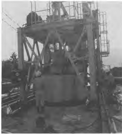
写真-3 型枠設備の全景
