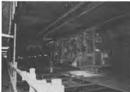
写真-1 坑内運転状況
