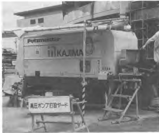
写真-3 高圧コンクリートポンプ
