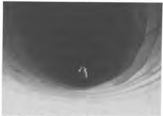
写真-5 吹き付け土留め状態
