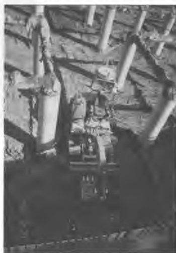
写真-3 作業状況
