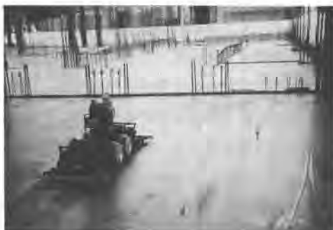
写真－6 現場施工状況
