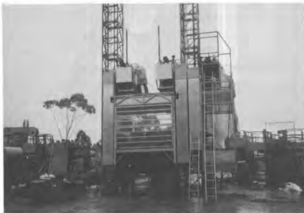
写真-2 4 tエレベータ荷重試験状況 （右側は調整中の2 tエレベータ）
