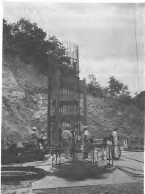
写真-6 鉄筋組立・建て込み装置
