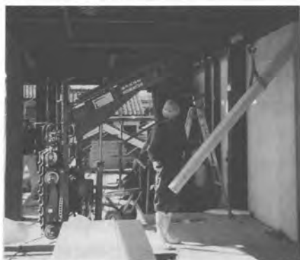
小物件施工：4×10m
