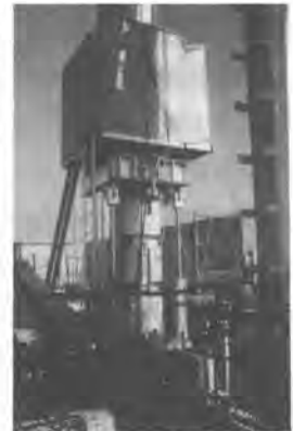
写真-2 装置設置状況
