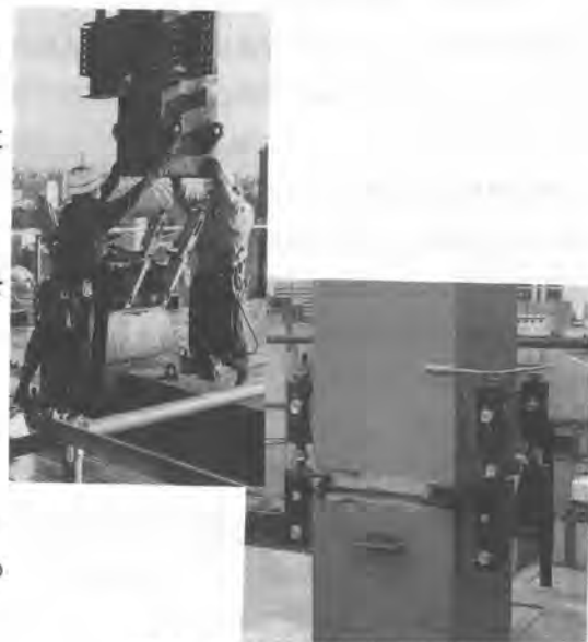
写真-6、7 取付と建入れ状況
