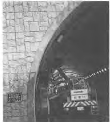
写真-1 トンネル清掃車 施工状況(現状)
