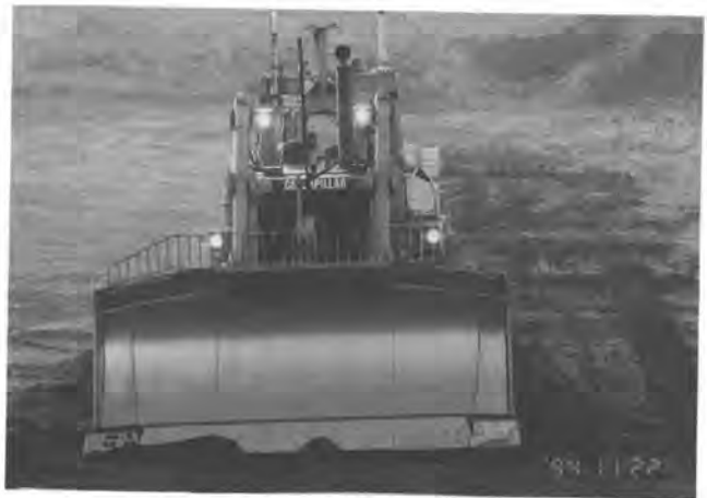
写真一3 施工状況写真
