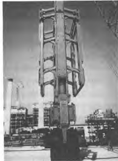
写真2 変断面对応型掘削機
