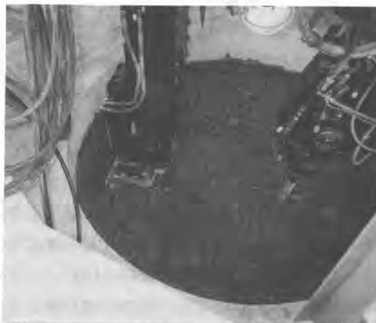
写真-2 掘削機械による掘削状況
