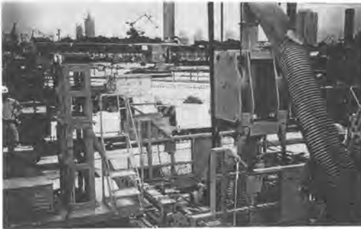
写真1 計測装置の設置状況
