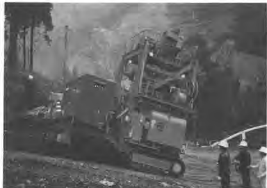
写真一1 急勾配工事用道路よりの進入
