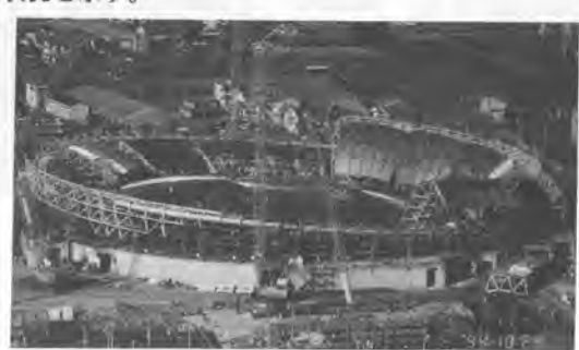
写-4 トラス建方(2)
