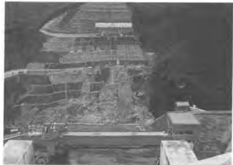
ケーブルクレーン全景
