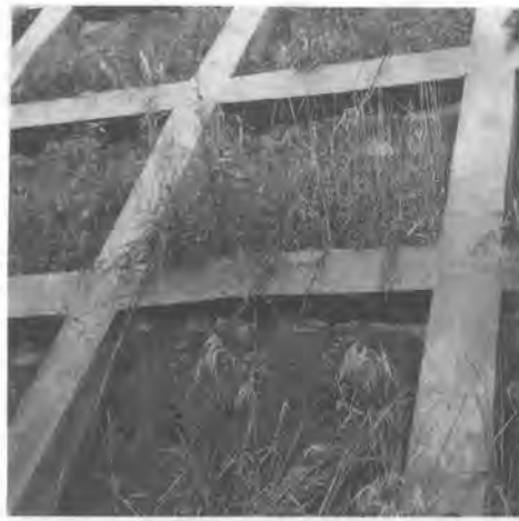
写真3 従来の吹付け施工による緑化
