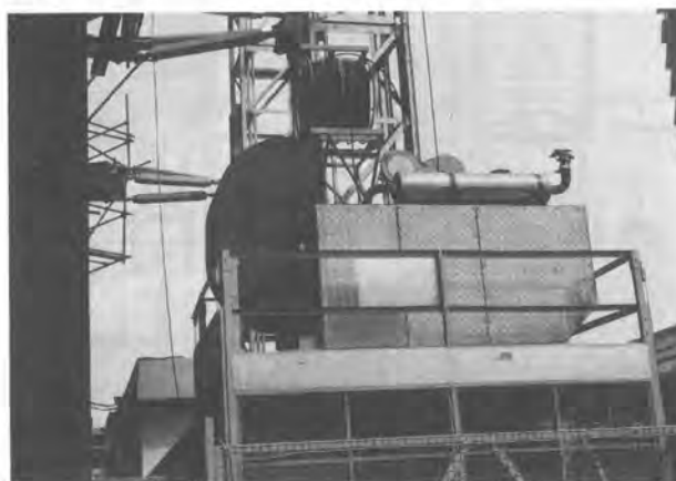
写真-4 駆動用エンジン部（2 tエレベータ）
