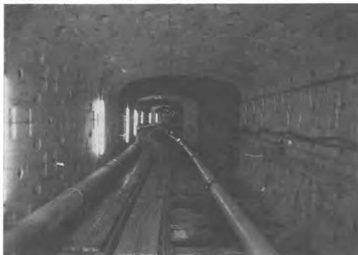
写真-3 坑内状況
