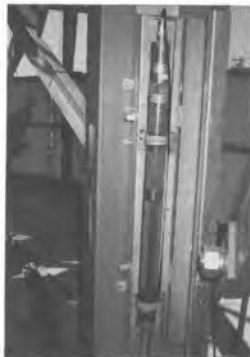
③ 磁歪式レベル計を利用したレベルセンサー
