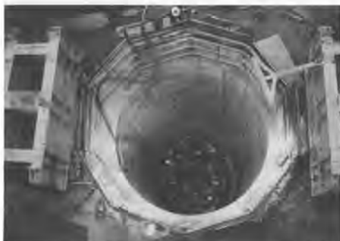
写真-3 施工完了状況
