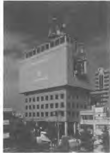
写真-1 施工時外観
