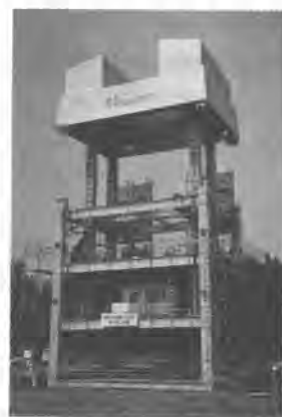
写真-1 リフトアップ状況
