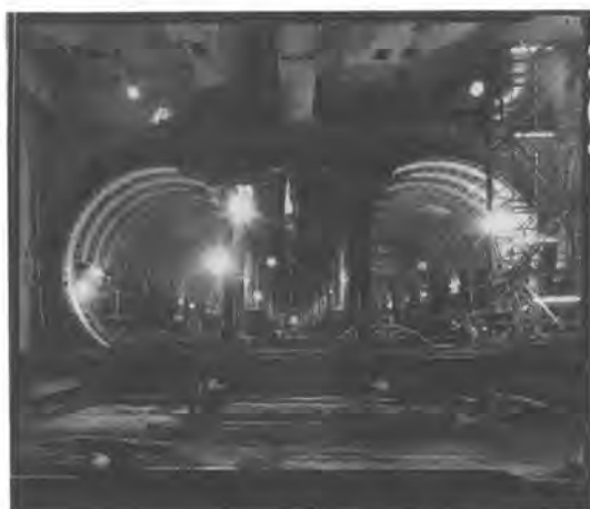
写真-1 シールドトンネル全景
