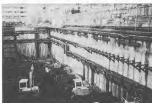
写真-2 横浜/Y現場
