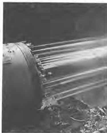
写真-1 Water・Jet噴射状況
