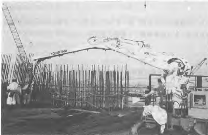
図-6 実施工状況写真
