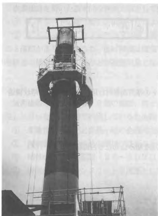
写真3 同CFストランド横方向巻付け
