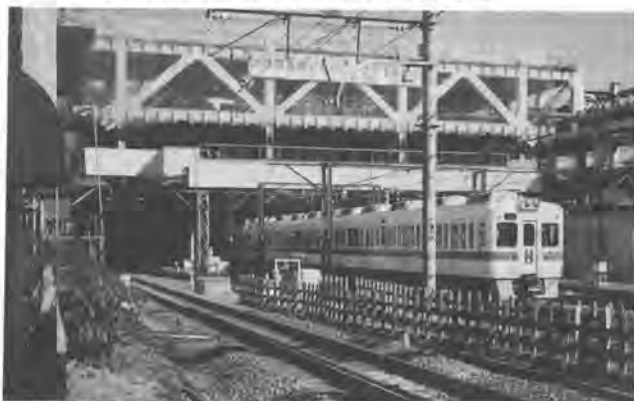
写真-1 トラベリング全景
