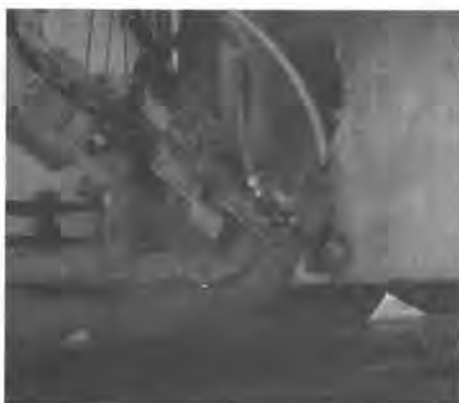
写真-1 研り状況 (側部ロボット)
