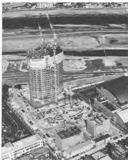
写真-1 ザ・シーン城北工事全景
