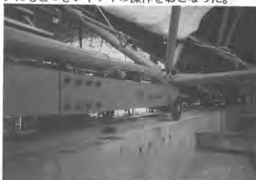
図-10 トラベリングジャッキ
