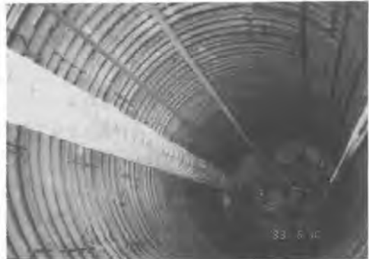
写真-4 坑内降下したゴンドラによる作業状況
