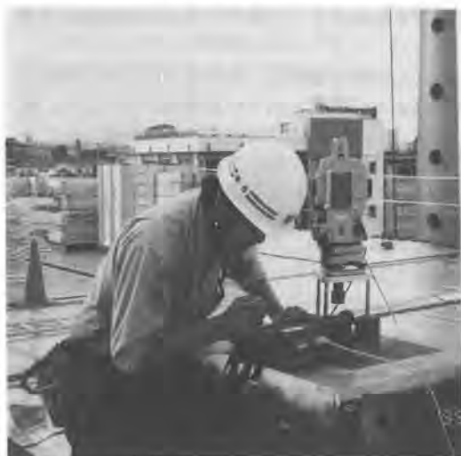
写真-8 現場導入状況
