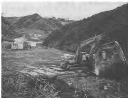
写真-1 施工状況(全景)
