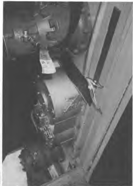
写真一六 2連式ガバナ(落下防止装置)
