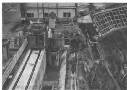
コンクリートバケット ・トランスファー
