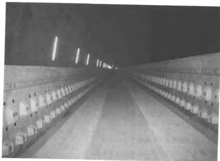
写真-4 出来形状況
