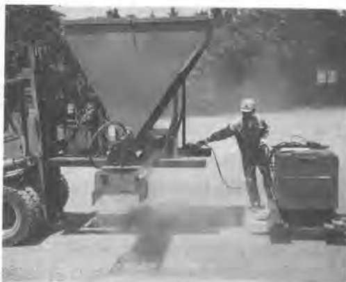
写真-3 計量、散布実験装置
