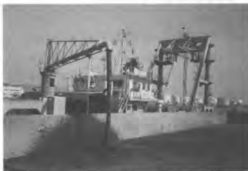
写真-3 バージ積込み状況
