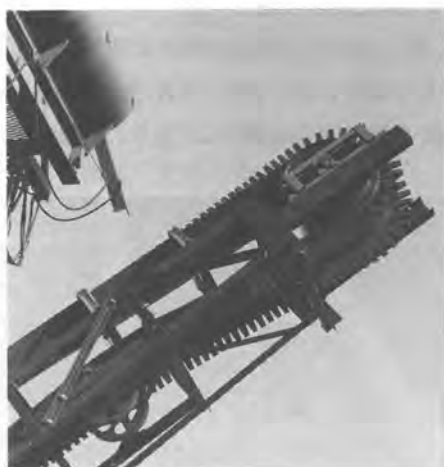
写真4-1 急傾斜ベルトコンベアの先端部
