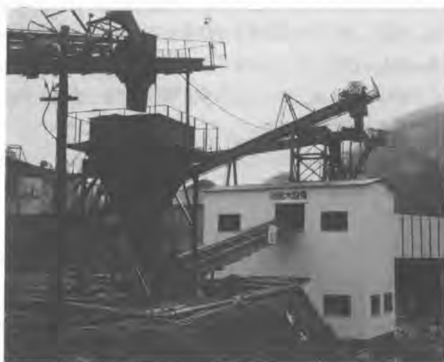
写-1. 砂処理設備の外観
