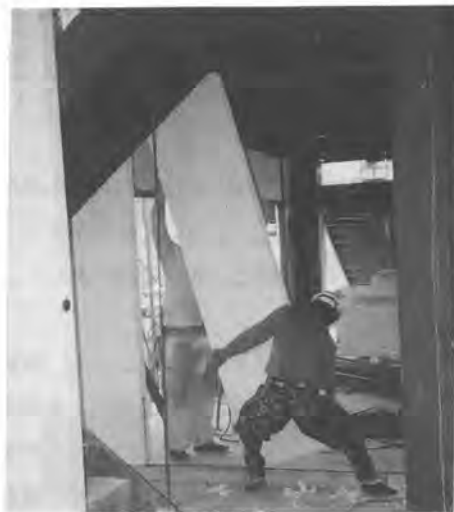
現状現場施工例
