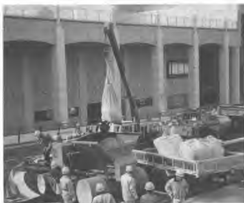
写真-2 ユニックによる材料供給
