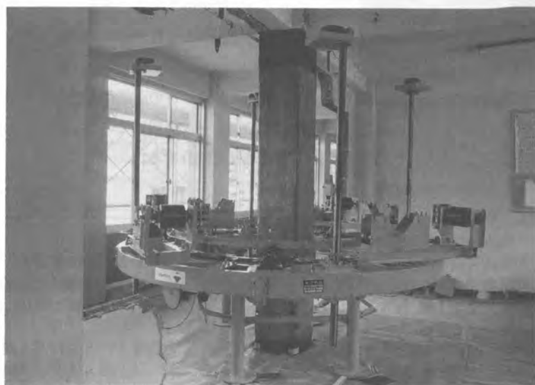
写真6 同CFストランド横方向巻付け
