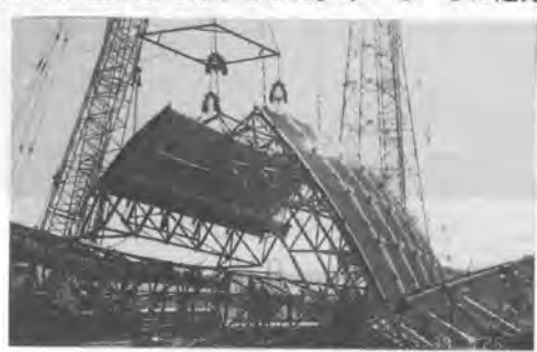
写-3 トラス建方(1)
