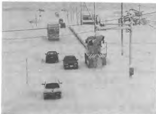
写真-1 除雪作業状況
