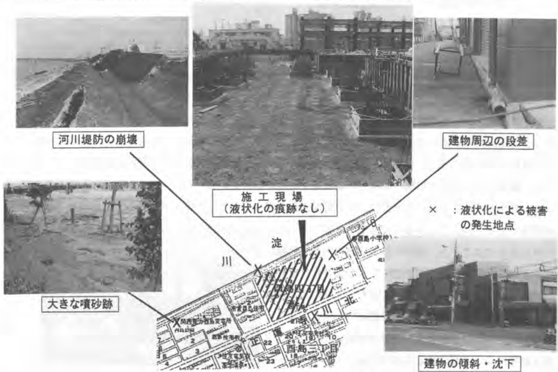
図-12 兵庫県南部地震における施工現場周辺の状況
