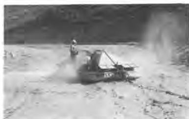
写真-3 巨大ドライヤー施工状況
