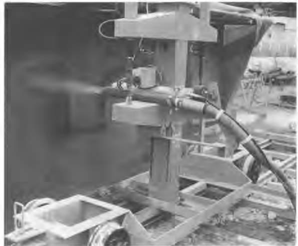
写真-1 基礎実験状況
