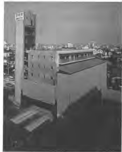
写真-1 施工状況
