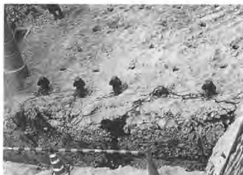
写真-3 割岩試験状況
