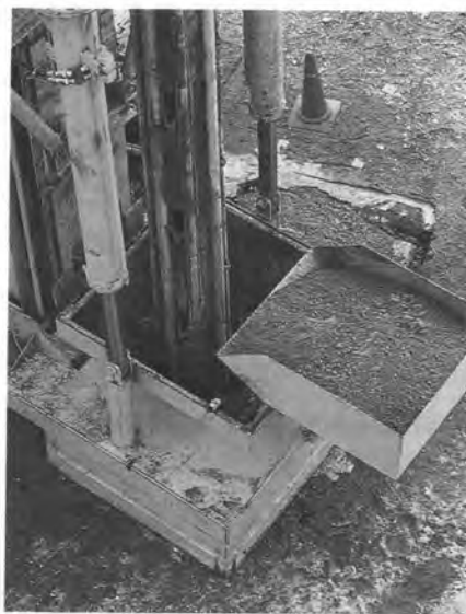
写真-2.2 振動兼用固定式土砂ホッパー
