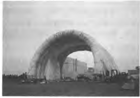
写真-5 設置完了
