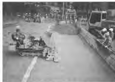
写真-3 モルタル敷き均し装置
