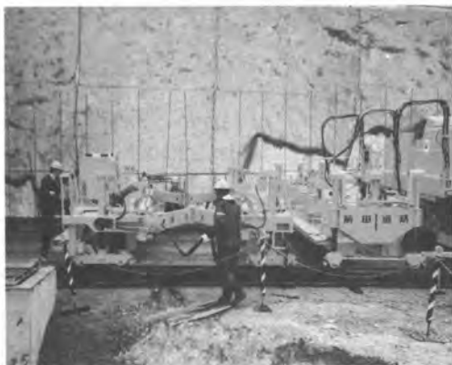
写真-7 コンクリートレベラ組み付け
