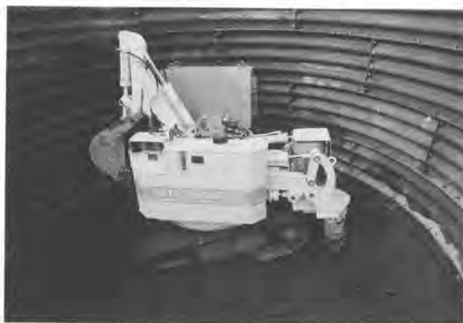
写真-1 深礎工事ロボット
