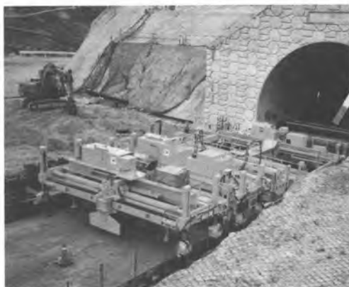
写真-8 コンクリート舗装機械搬入完了状況
