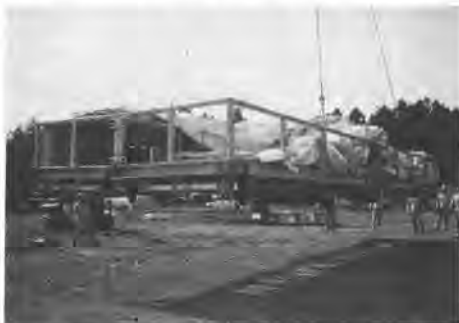
写真-2 連結した4台車の吊り上げ
