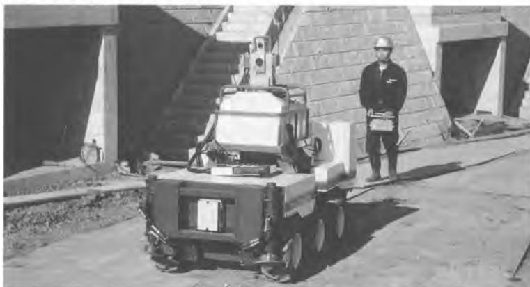
写真-4 測量ロボットの移動状況
