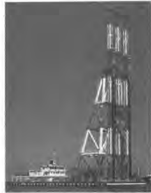
写真-1 地盤改良船
