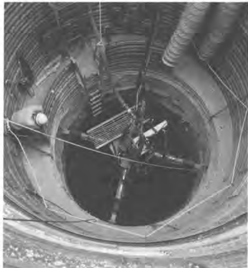
写真-4 吹付状況
