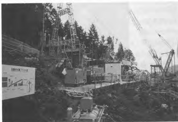
写真-6 現場全景
