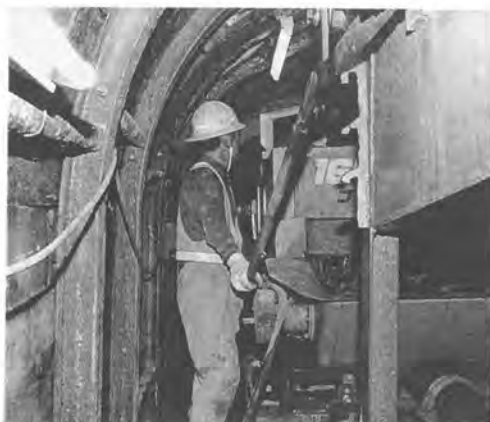
写真4 コンクリートポンプ操作状況
