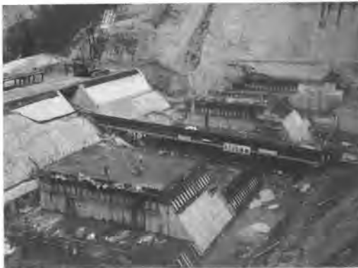
写真-3 現場全景
