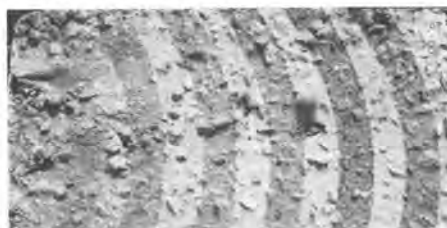
写真-2 1ショット・カッティング状況
