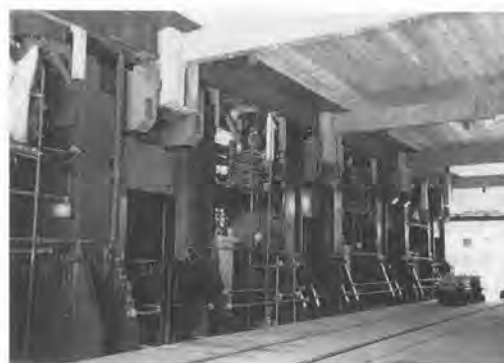
写真2 建物押し上げ状況
