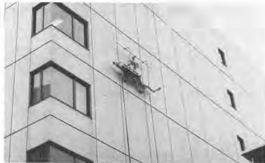
写真3 壁面検査状況
