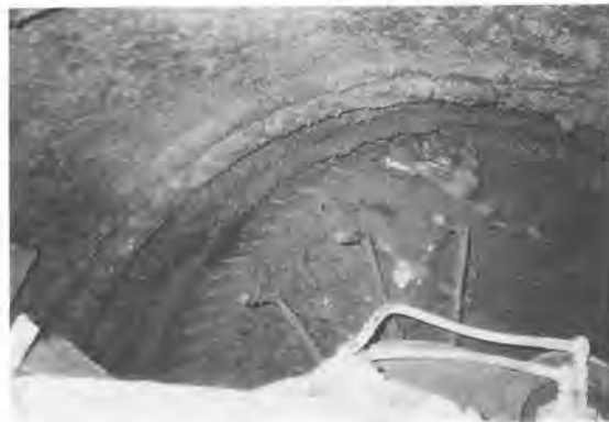
写真-2 土丹層の掘削状況
