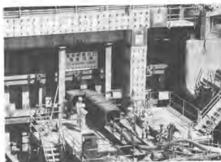
写真-5 現場施工試験状況
