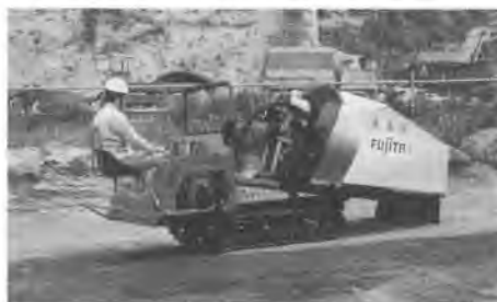
写真-4 造成現場での施工状況
