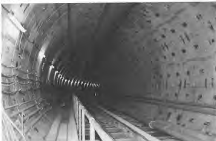
写真-2 覆工状況
