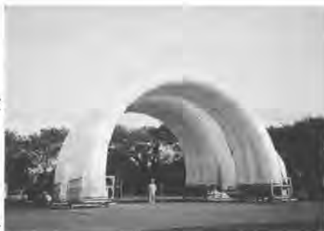
写真-1 パラガスCの全景
