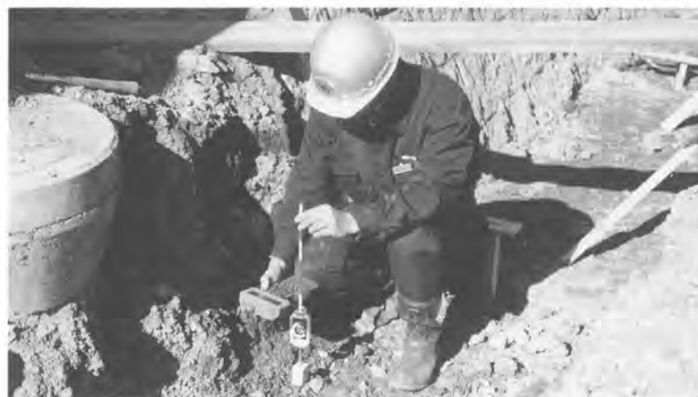
写真-5 測設位置の検索状況（U字溝構築のための測設作業）
