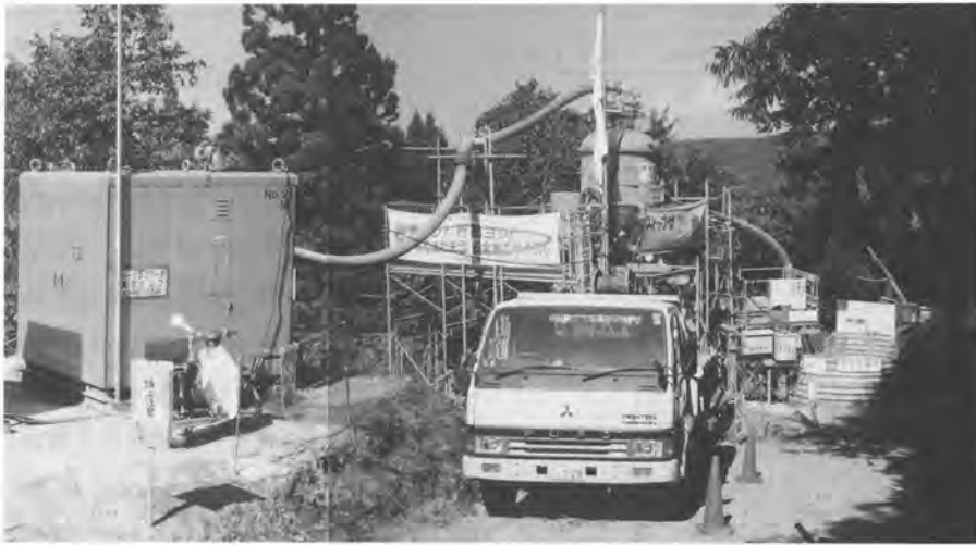
写真-2 現場施工全景
