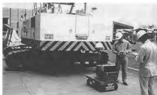
写真—3 電界強度計測状況
