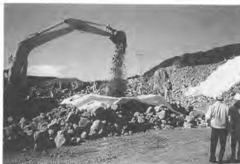
写真3 陸上載荷試験（落下高3.5m）
