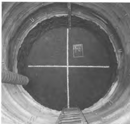
写真-5 吹付完了
