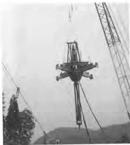
写真-2 吹付ロボット全景
