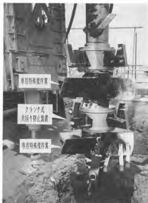
写真-2 クランク式共回り防止装置
