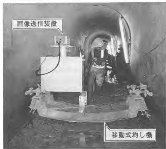
写真 2 打設箇所送信装置
