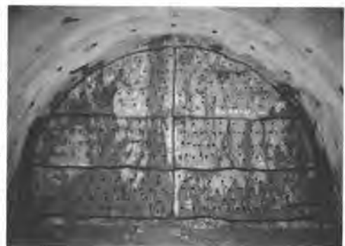
写真-1 連続孔、割岩孔穿孔完了
