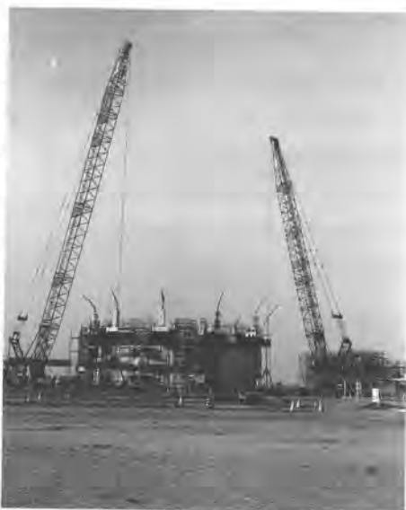
写真-1 施工状況
