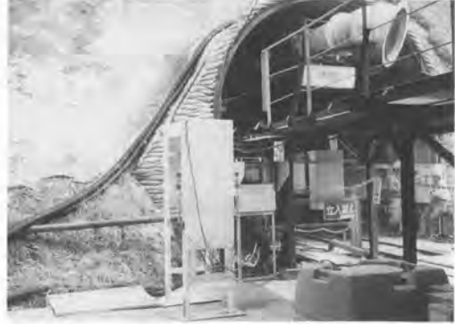
写真-2 入坑ゲートおよび坑口表示器
