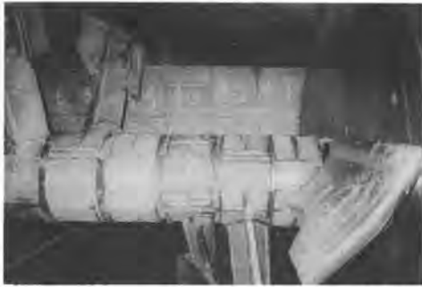
写真-2 カタブツライナーの取付状況
