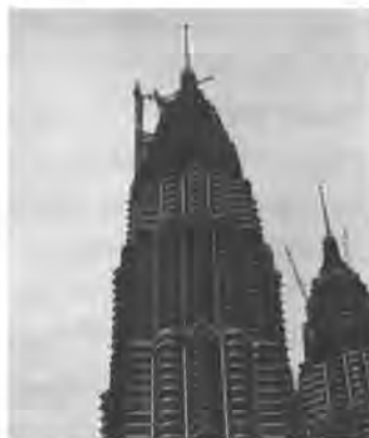
写真-3 解体用クレーンの設置
