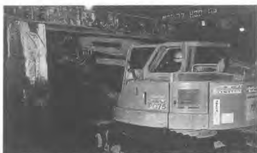
写真3. 地下鉄12号線建設現場とPG75
