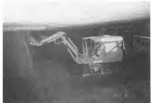
写真二2 ミニショベルによる掘削状況②
