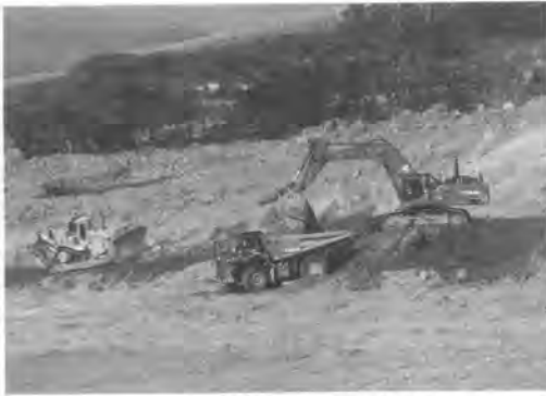
写真-2 施工状況1
