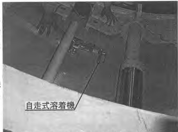
写真-5 円周方向の溶着状況
