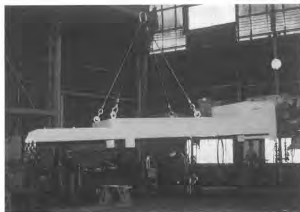
写真-3 1.5トン用リーチバランサー
