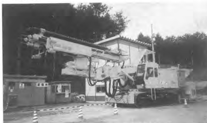
写真1 プレイニングマシン(坑内搬入前)
