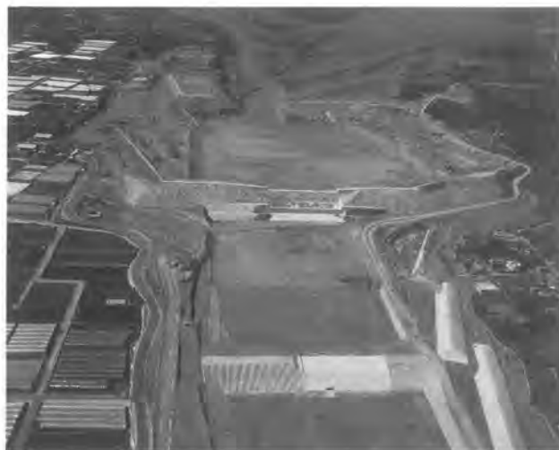
写真-9 工事完了全景
