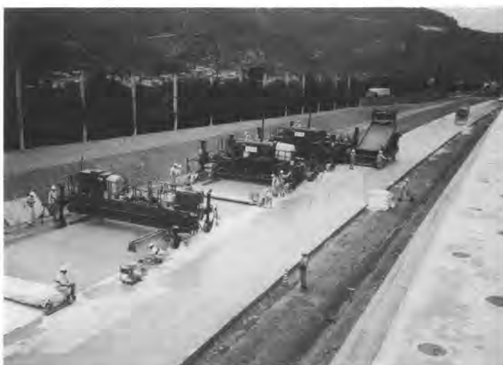
写真-1 スリップフォーム工法用施工機械(新日本坂トンネル明かり部)
