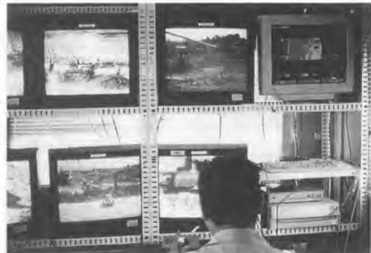
写真-3 遠隔操作状況
