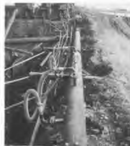
写真 3-4 パイプシャワー設置状況
