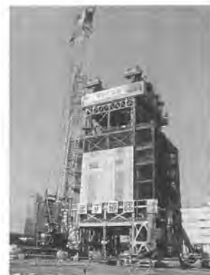
3号ボイラ棟の施工
