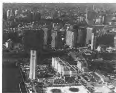
火力発電所全景
