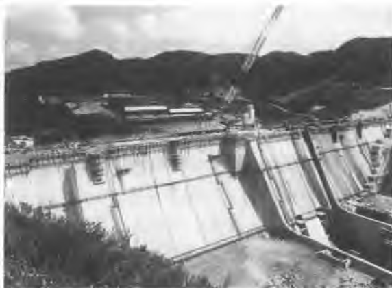
写真-2 堤体下流面配管
