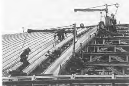
写真-2 敷設状況
