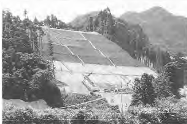
写真-2 施工状況
