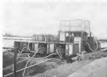
写真 3-2 固化材プラント
