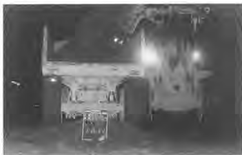
写真2 ずり搬出状況
