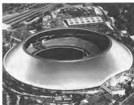
写真-3 第1期工事完了
