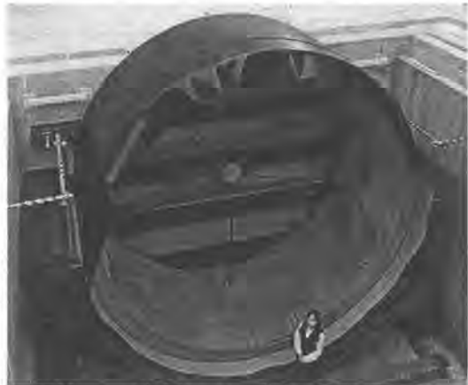
写真-1 防水シートを巻立てたセグメント (97年度実証実験)
