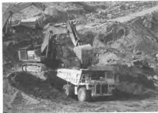
写真-3 施工状況2
