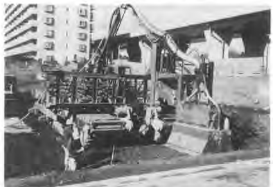
写真-2 施工状況 (サイドシフト型マッドスタビライザ)
