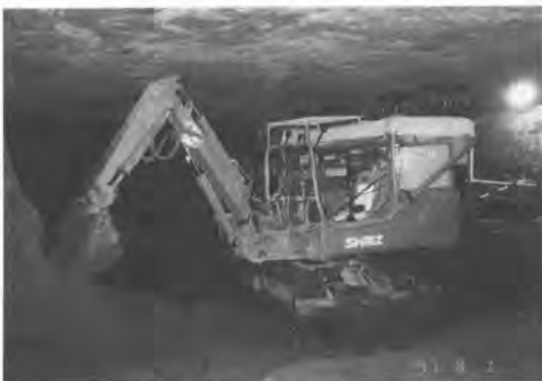
写真一1 ミニショベルによる掘削状況①
