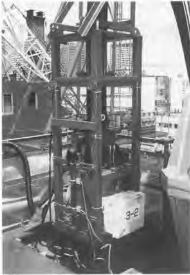
VSLジャッキ
