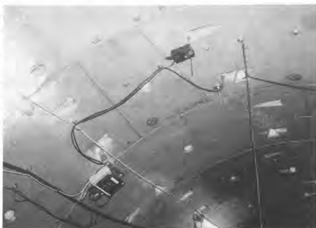
写真-2 固定局設置状況
