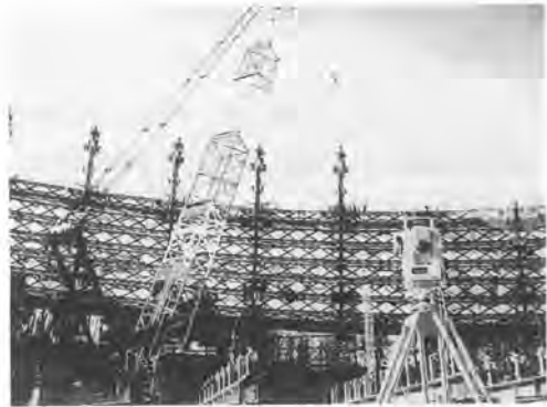
写真-1 鉄骨建方、計測状況
