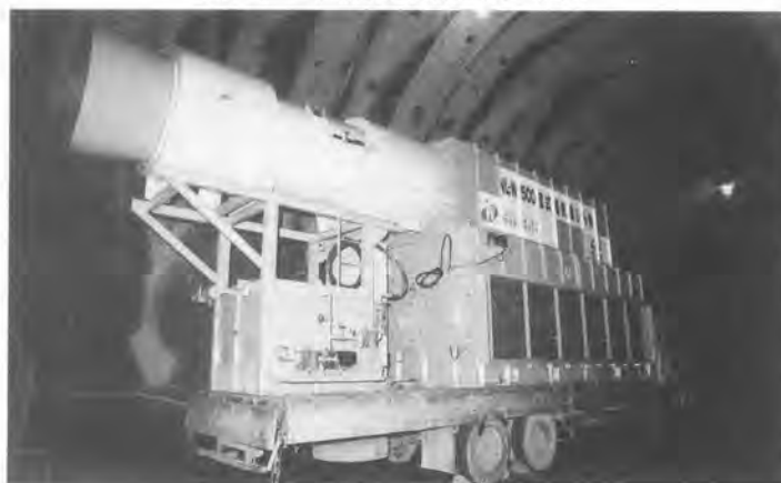
写真-2 電気集塵機坑内設置状況
