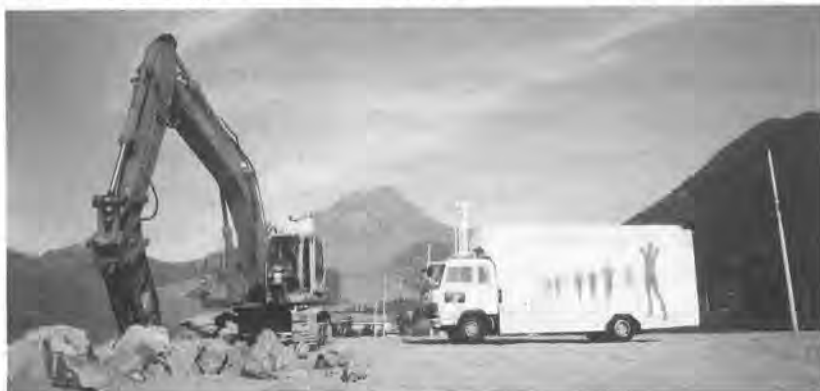
写真-1 全景写真
