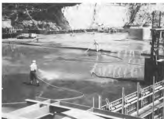
写真－1 打設前清掃
