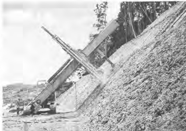
写真-3 ABS稼働状況
