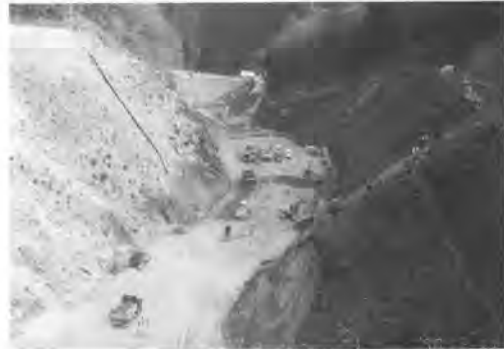
写真-1 現場の盛り立て初期状況
