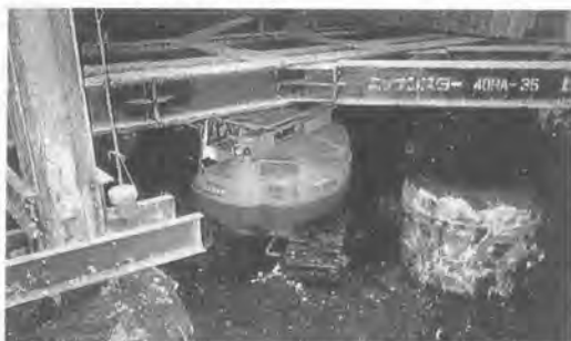
写真2. 地下貯水場工事現場とテスト車
