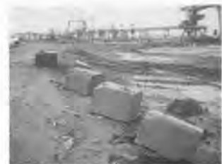
写真 3-5 固化処理土 (処理日の翌日)
