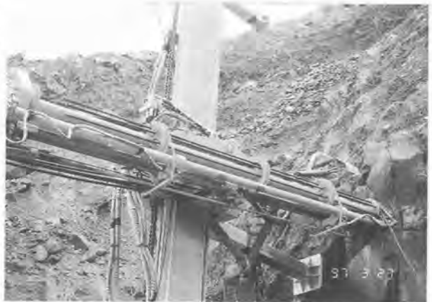
写真-1 自動打設装置
