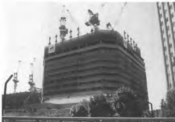
写真-1 工事外観
