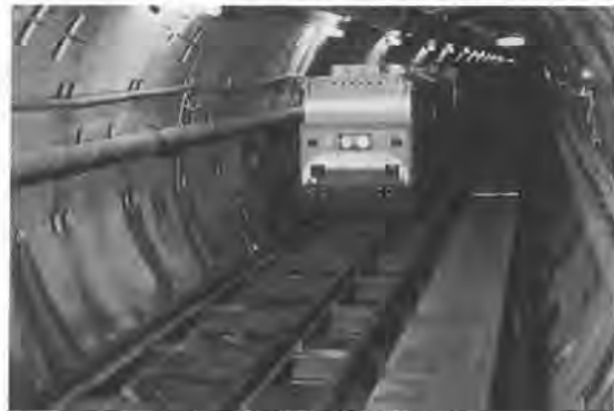
写真1 誘導線敷設状況
