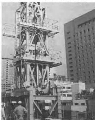
写真-4 盛替架台セット状況
