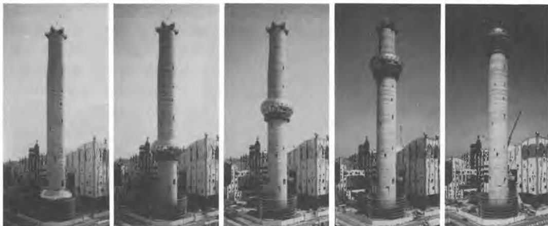
写真-11 ゴールデンボールリフトアップ工事状況
