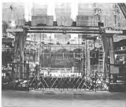
写真-1 大型昇降ステージ全景
