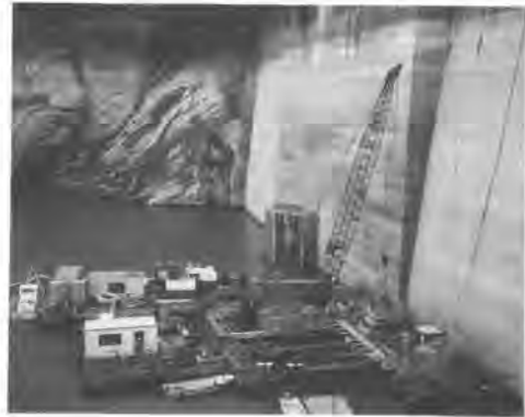
写真-1 施工状況
