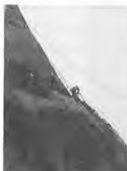
【写真-1】人力による岩壁削工
