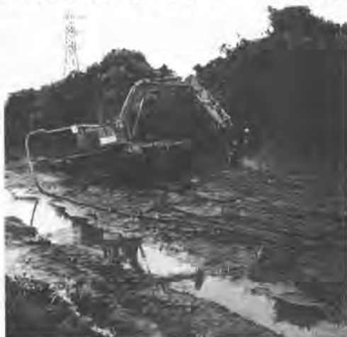
写真-4 PJマッドスタビ工法施工状況
