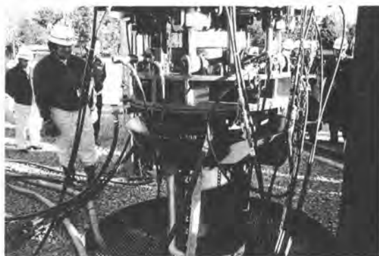
写真-2 圧入状況
