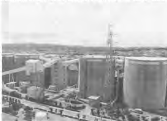
写真1 石炭サイロ全景
