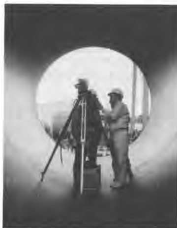
写真・2 鋼管内径測定状況
