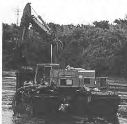
写真-5 浚渫状況
