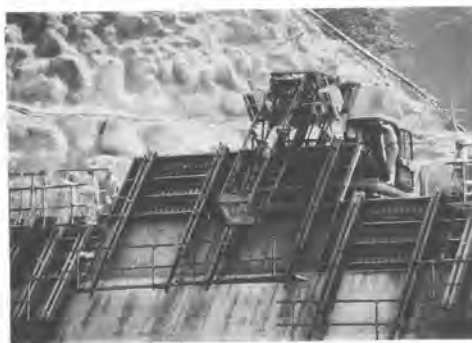
写真-3 ダムフォームスライド実験全景
