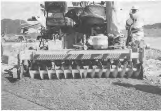
写真-3 ウッドファイバーフィッジャ施工状況
