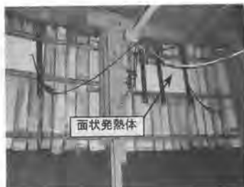
写真-1 面状発熱体取付け状況
