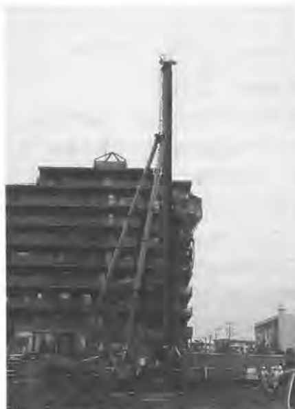
写真-1 SAVEコンポーザー施工状況
