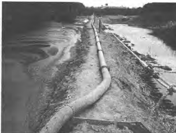
写真-6 浚渫泥の処理池へのポンプ圧送
