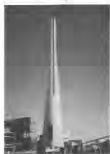
写真-2 電源開発(株)磯子火力発電所
