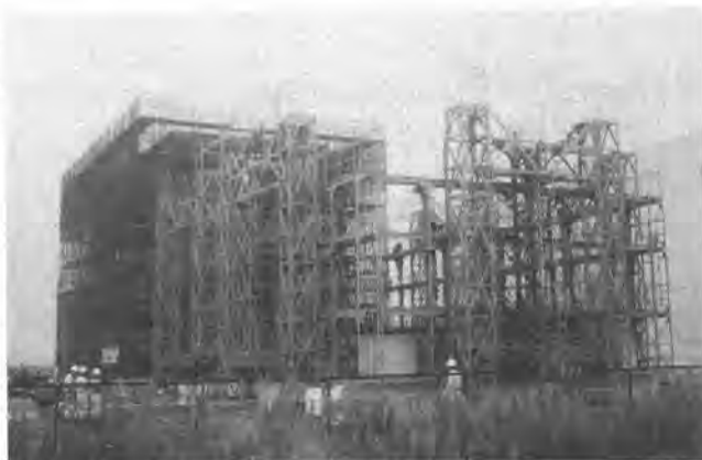
写真-1 油圧式自動昇降外型枠設備全景
