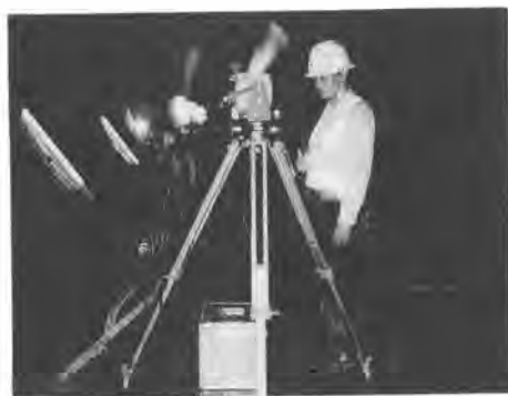
写真-3 一次覆工測定状況
