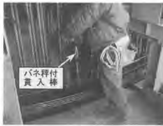
写真-3 貫入試験状況
