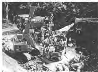
写真-2 道路橋橋脚基礎
