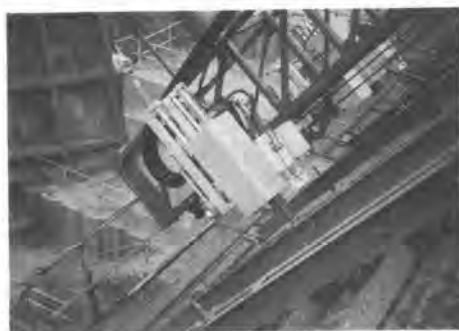
写真-5 ボルト締結作業
