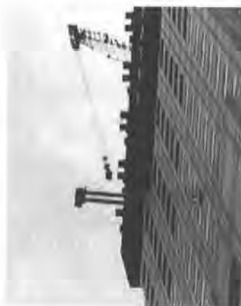
写真2 施工中の外壁板 取付システム
