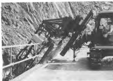
写真-4 スライド作業状況
