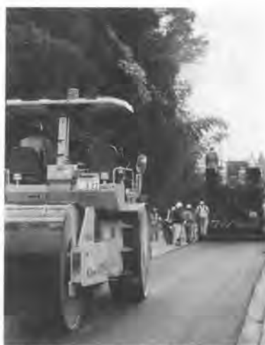
写真-2 マルチレーン施工現場
