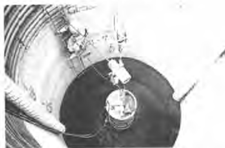
写真-1 作業状況(南いわき幹線)
