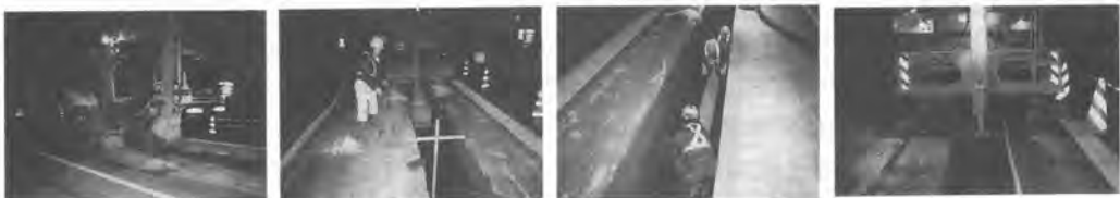
図-2 情報管路埋設工事の施工手順
