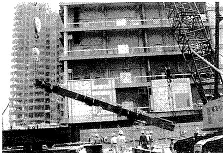
写真1 補助クレーン相吊り方式
