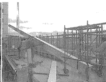
写真10. プラットフォーム材料揚重
