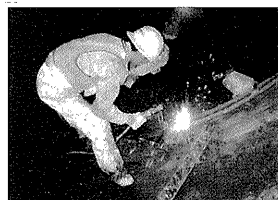
写真-9 スペーサ溶接固定
