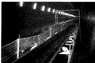
写真-7 ベルコン跨線橋
