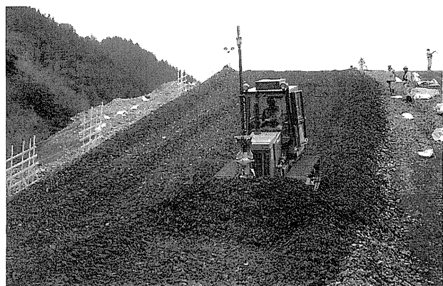
写真-5 急勾配法面での施工
