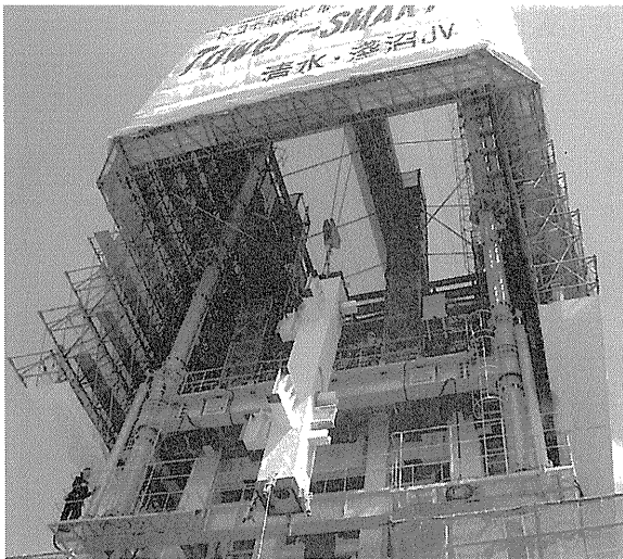
写真2. 荷取構台からシステムによる揚重
