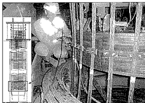
写真-7 下部フレーム取付状況
