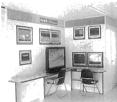
写真-1 工事事務所の中央管理システム
