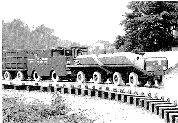
写真-3 タイヤ式坑内搬送システム
