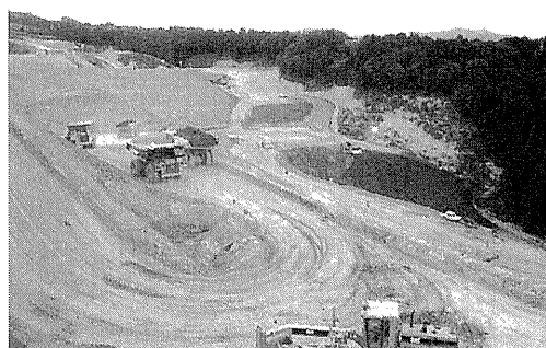
写真-2 現場施工状況
