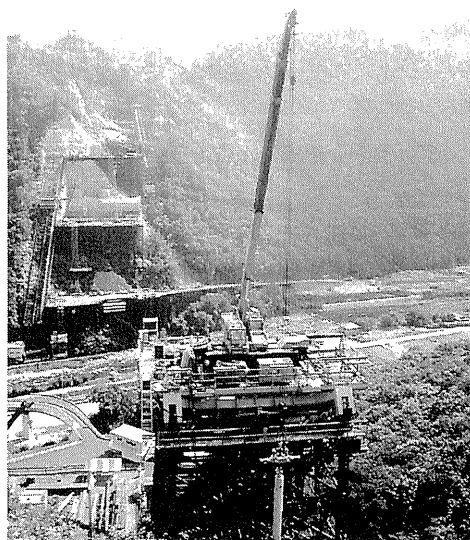
写真－1 架台施工状況
