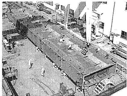
写真 4 製作工場における仮組み
