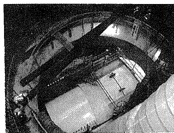
写真-4 現地設置状況
