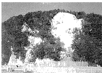
写真-9 崩壊山腹斜面
