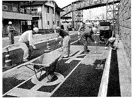
写真-3 人力による充填作業
