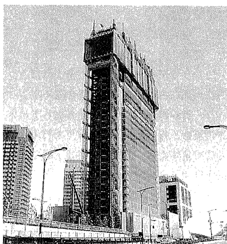
写真6 稼働時の外観
