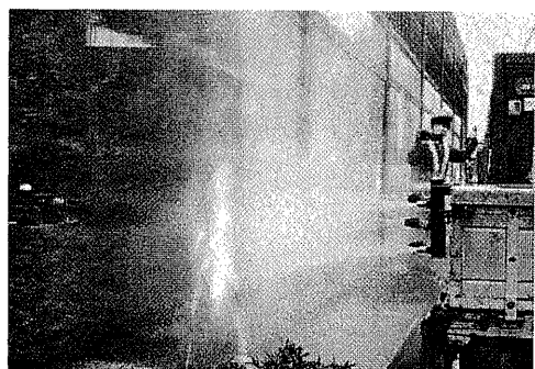
写真-3 現地システム試験実施状況
