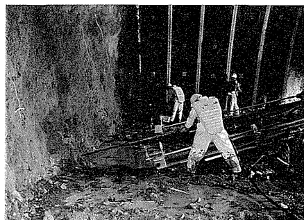
写真－2 実現した遠隔装填作業
