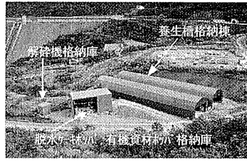
写真-1 「植生土壌化プラント」全景
