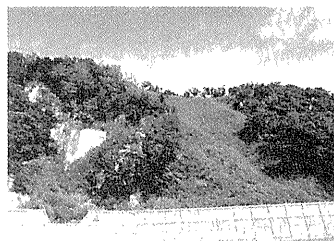
写真-11 施工後3年6ヶ月経過
