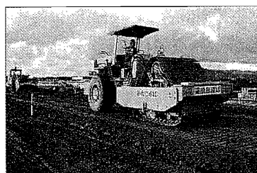
写真-1 試作車の稼働状況
