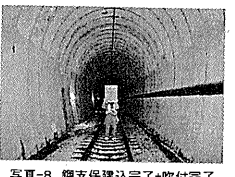
写真-8 鋼支保建込完了+吹付完了
