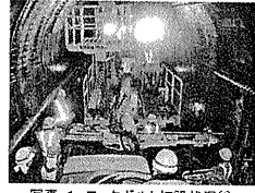
写真-1 ロックボルト打設状況(1)
