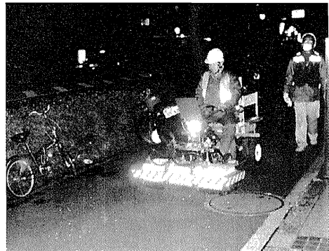
写真-4 現場試験状況
