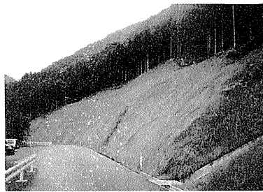
写真-8 施工後6ヶ月経過
