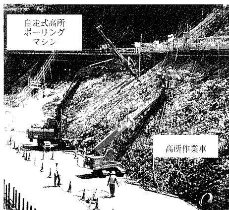
写真-1 施工状況
