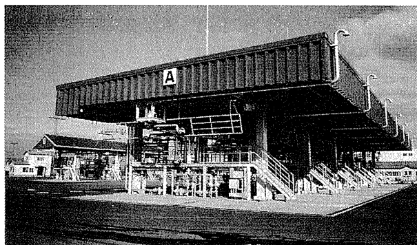
写真—2 現地状況
