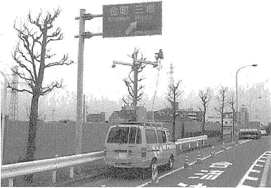
写真-1 点検状況（片持式）
