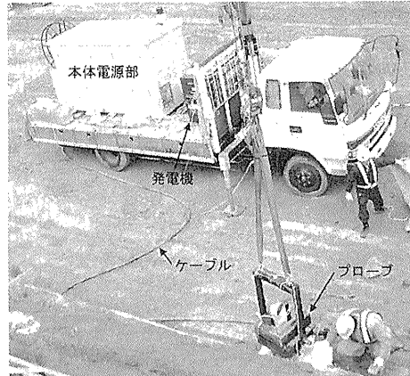
写真-3 現場作業状況
