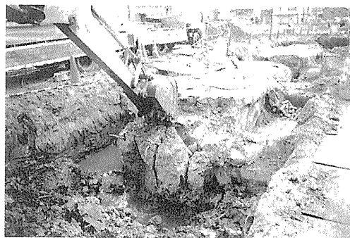
写真－７ 放電後の解体状況
