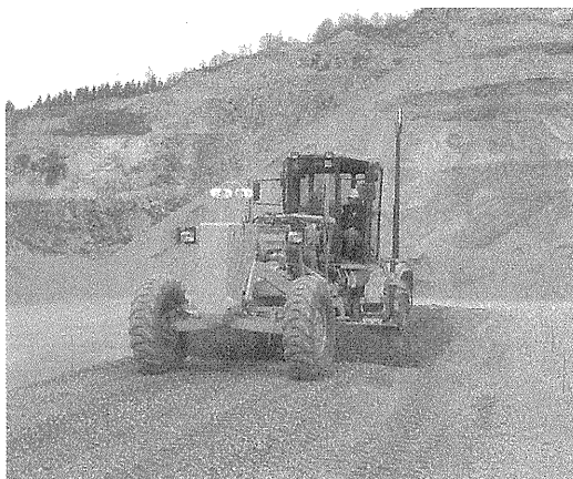
写真-1 試験施工中の3D-MC グレーダ
