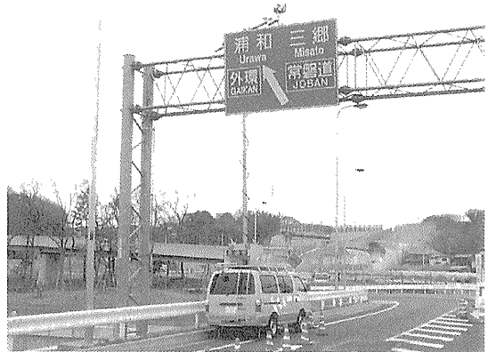
写真-2 点検状況（門型式）
