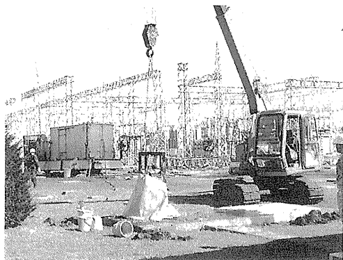
写真－４ 施工状況
