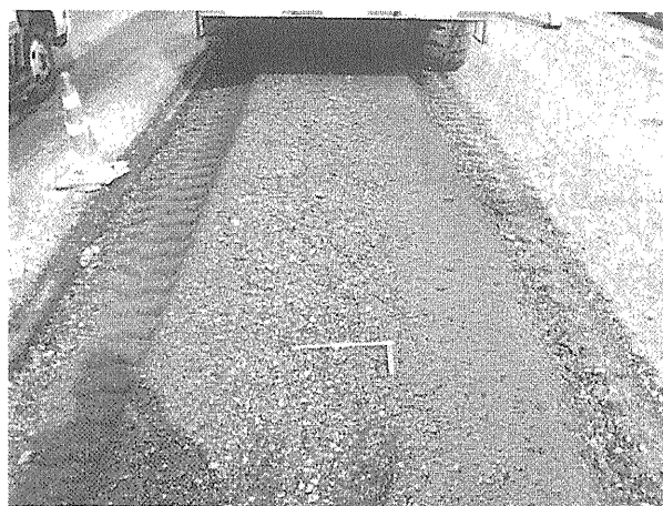
写真-3 破碎・混合状態
