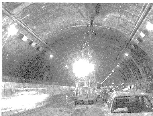
写真 4-2 M トンネル現場写真
