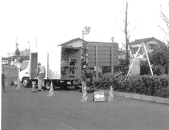
写真-5 動作確認試験状況
