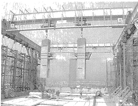
写真-3 P C a 柱施工状況
