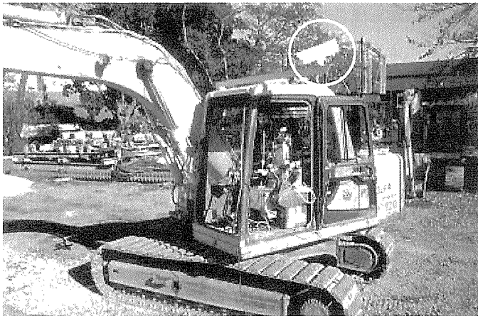
写真-1 張出しカメラ取付け状況
