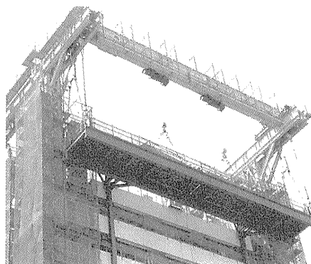
写真-5 建設用リフト揚重状況
