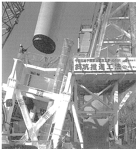
写真-2 推進管投入状況
