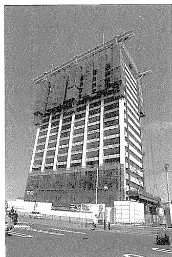
写真-1 施工状況
