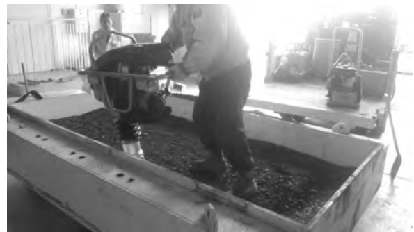
図-5 路盤締固め
