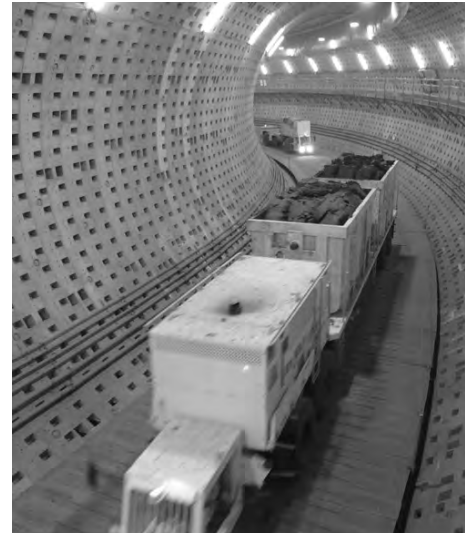
図-7 坑内急曲線走行状況
