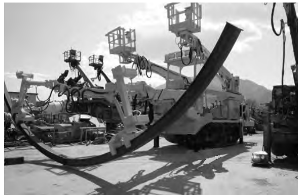
写真-3 インバート支保工接合実験
