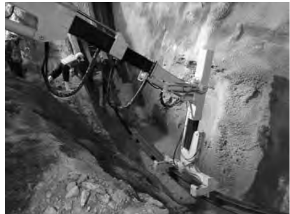
写真-7 支保工建込
