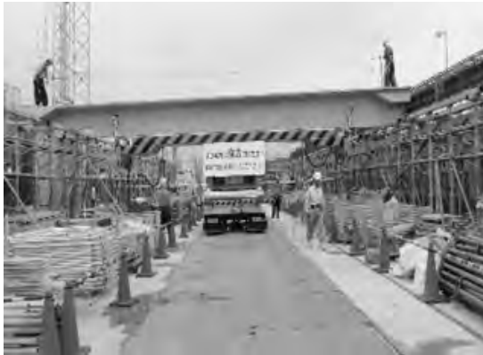
写真-6 受取・運搬状況
