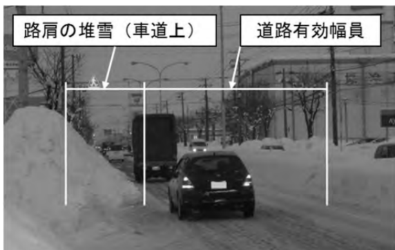
図-1 道路有効幅員と路肩の堆雪
