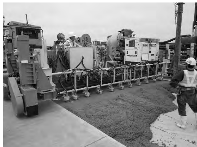
写真-9 施工状況
