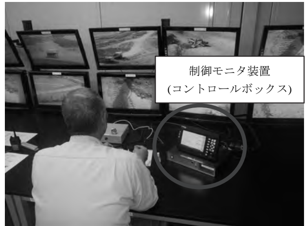
図-6 MG 施工状況
