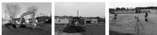
図-2 使用機材、左からPC-120油圧ショベル、D31ドーザ、RTK-GNSS測量機器
