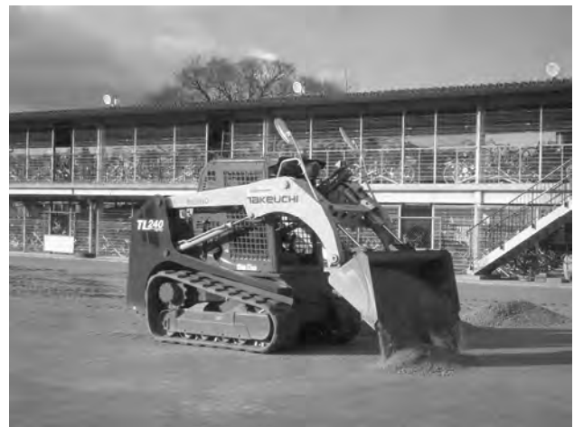
写真-8 同一現場での材料配置作業状況
