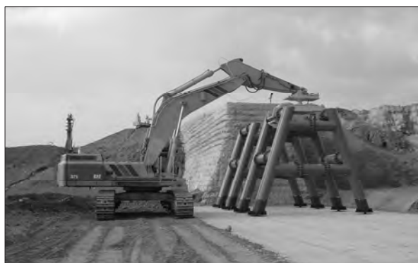
写真4 構造物(鋼製リット)設置
