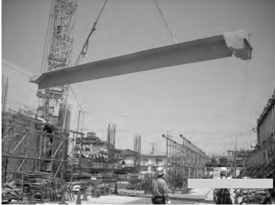
写真-5 PC 床版仮置状況
