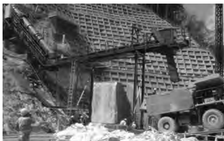
写真-3 監査廊回避 固定式ベルコン設置 (湯西川ダム)
