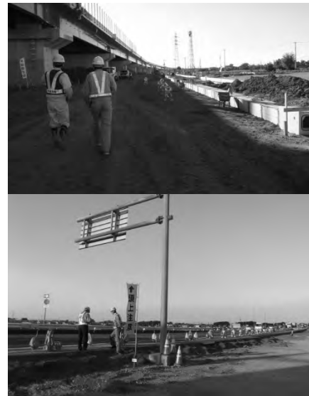
図-8 現場状況 (上段: A現場、下段: B現場)
