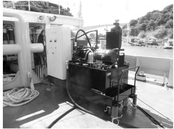
写真-5 油圧ユニット 艀装状況
