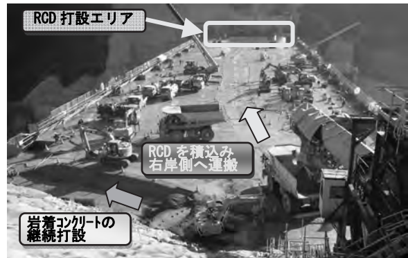
写真-7 岩着コンクリートと次層 RCD の同時施工
