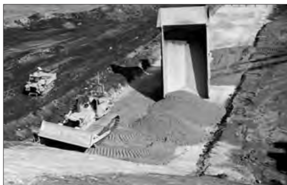
写真3 砂防堰堤(RCC工法)築造
