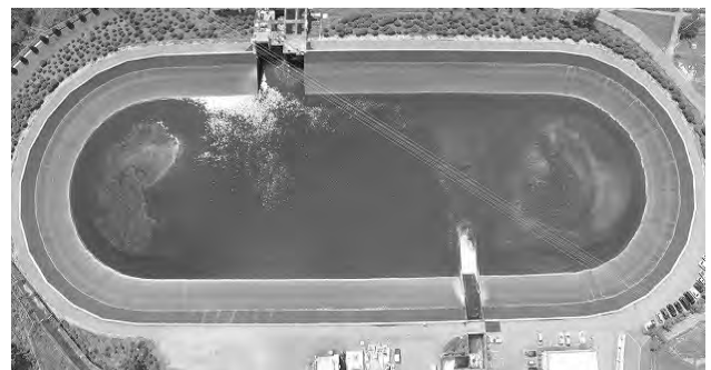
写真-8 現場完成写真
