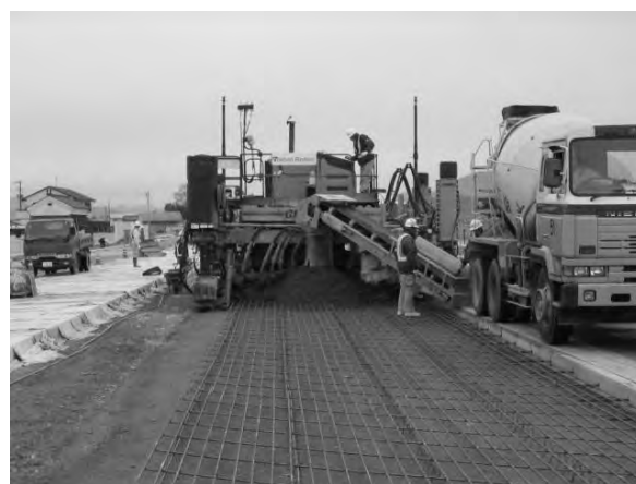
写真-1 施工状況
