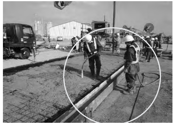
写真-4 施工状況①
