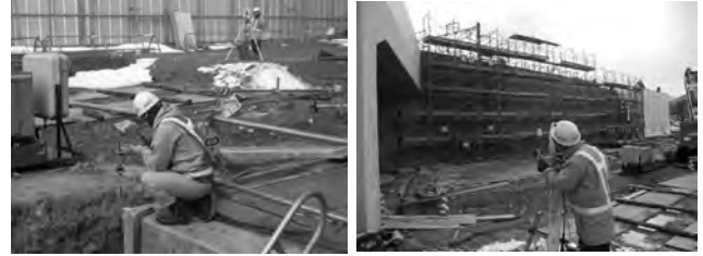
写真-2 TSによる計測点（擁壁工）
