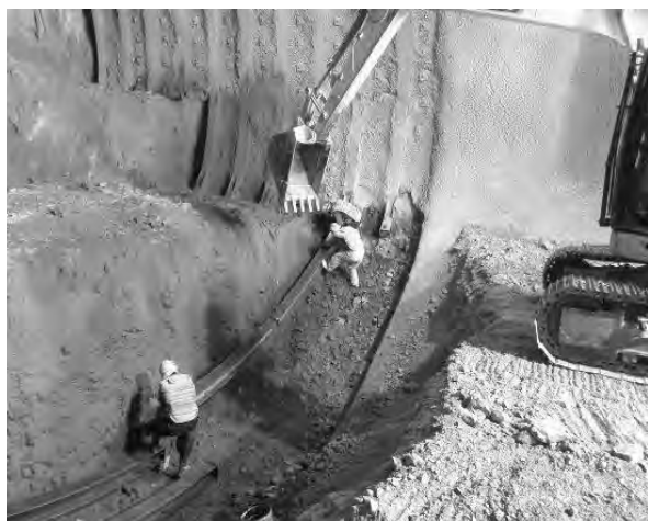
写真-1 インバート支保工と 下半支保工接合作業状況
