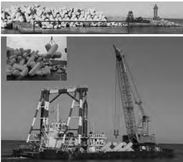
写真-2 試験海域・使用船舶・据付作業
