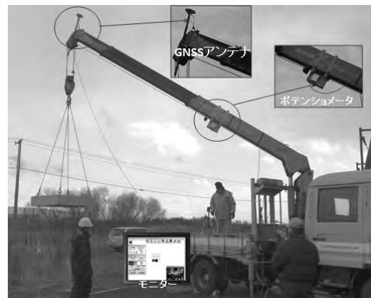
写真-1 コンクリートブロック誘導試験
