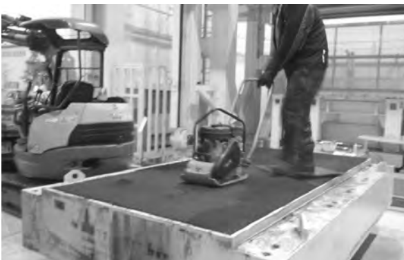
図-10 基層締固め
