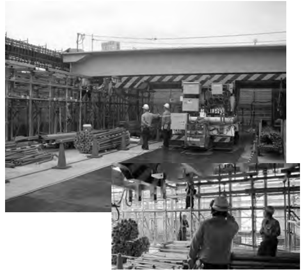
写真-7 据え付け状況
