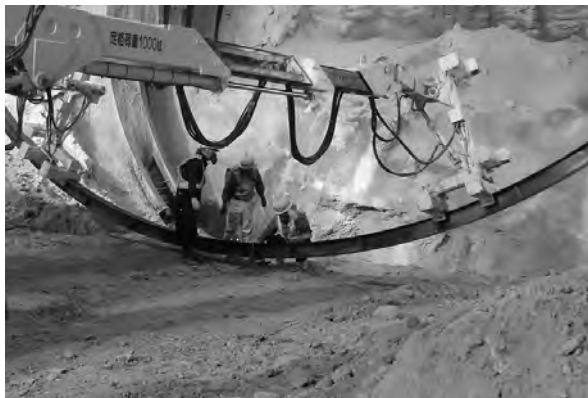
写真-5 支保工仮組
