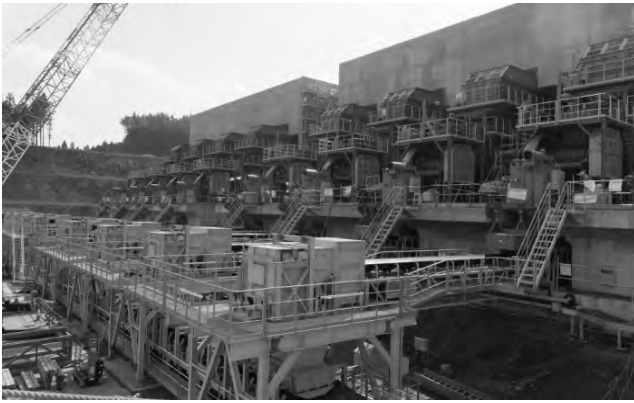
写真-2 完成した破碎設備と引出しコンベヤ
