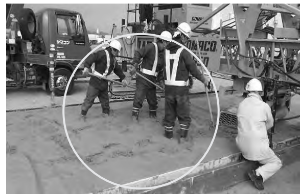
写真-5 施工状況②
