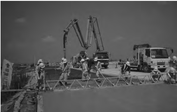
写真-2 鋼製フレームを用いた人力施工の状況
