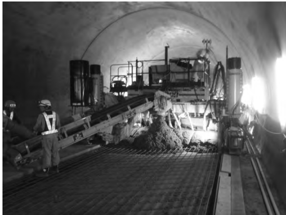
写真-3 施工状況
