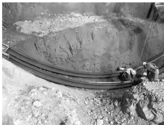
写真-2 インバート支保工接合状況
