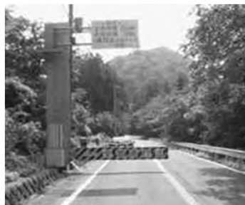
既設遮断機(降雨量制限箇所)
