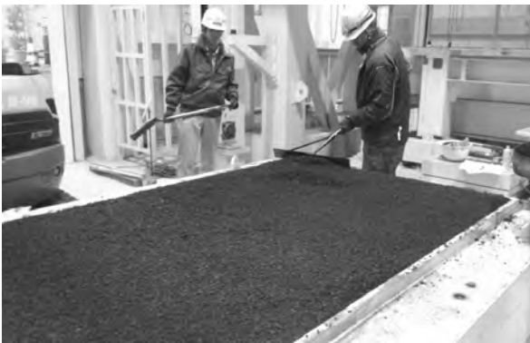
図-9 基層敷均し
