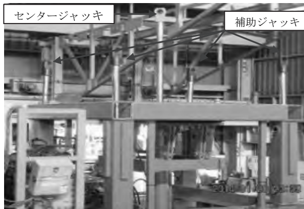
写真-3 補助ジャッキ追加
