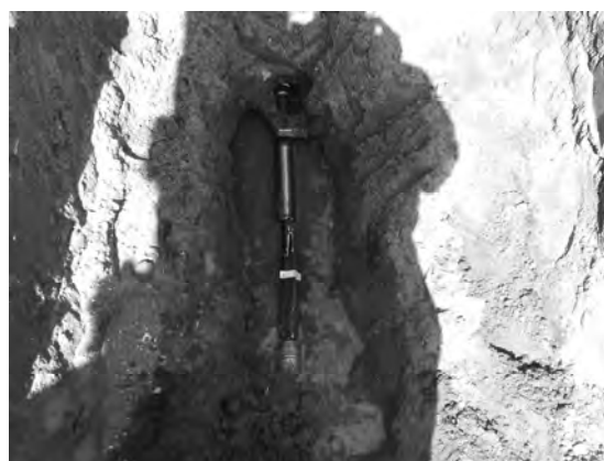
写真-5 先端部削孔ビッドの発掘写真
