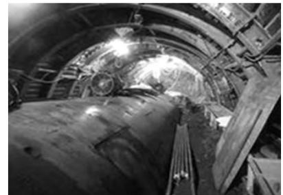
写真-3 拡幅掘削完了状況
