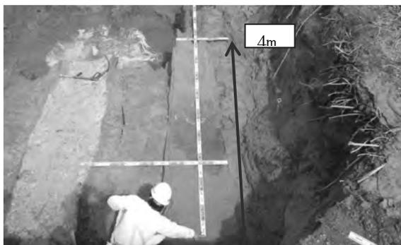
写真-2 矩形(長方形)改良体の出来型形状
