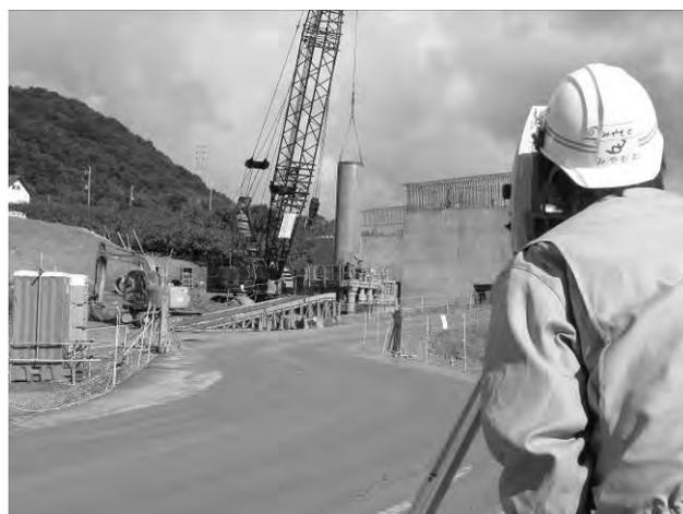
図-2 基礎杭中心座標の計測風景
