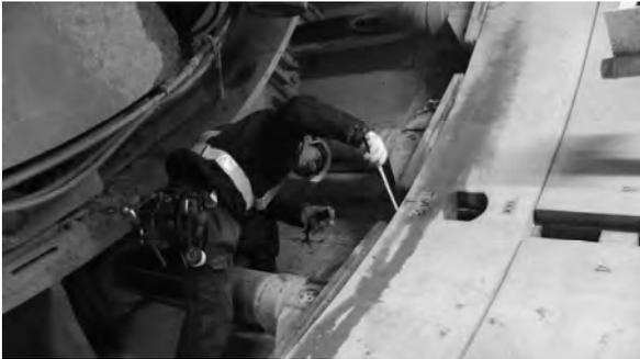
図-2 従来のテールクリアランス計測状況
