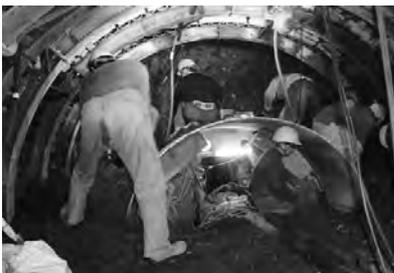
写真-1 人力拡幅掘削状況
