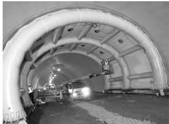
写真-5 ノズル・ホース設置状況
