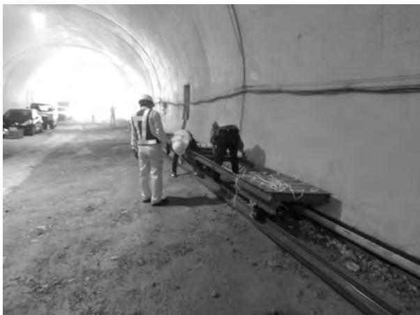
写真-2 レール・台車設置
