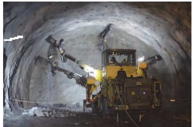
写真-1 4ブームフルオートコンピュータジャンボ (XE4C)
