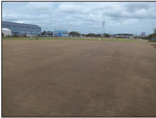
写真-10 改良後の状態
