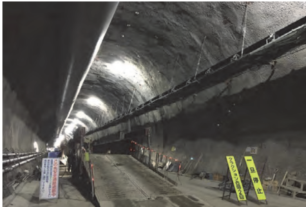
図-14 インパート施工部
