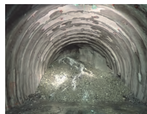
写真-1 異常出水発生状況 写真-3 交差点部濁水タンク TD1340m
