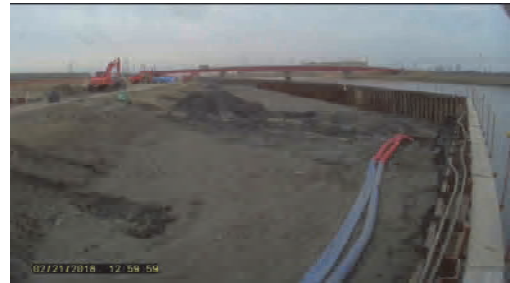
図14 内水部の掘削状況の臨場
