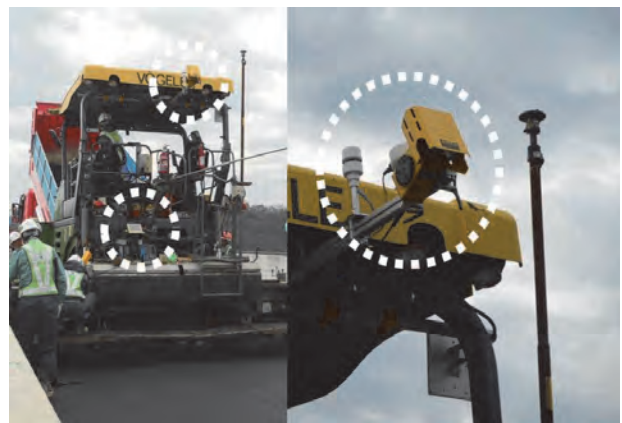
写真-10 敷きならし面管理機器 取付け状況
