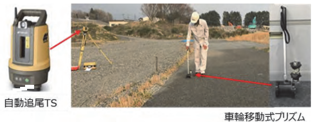
写-4 車輪移動式プリズムを用いた自動追尾 TS 計測状況
