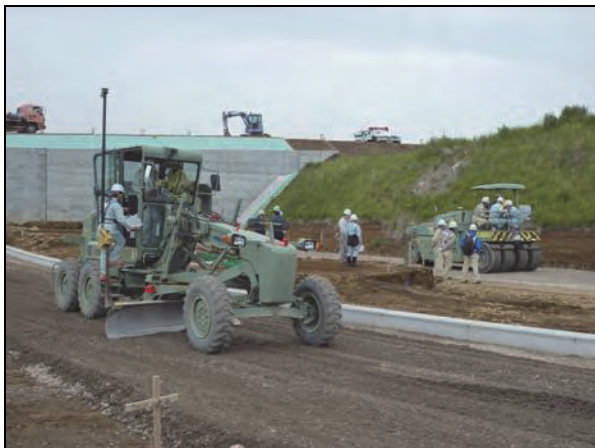
写真-1 平成22年当時の様子 (MGバックホウとTS・GNSS 締固め管理を見学)
