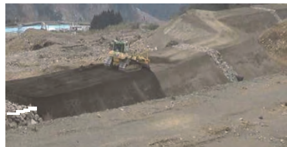
写真-3 ブルドーザ敷均し・転圧状況(土留盛土工下段)
