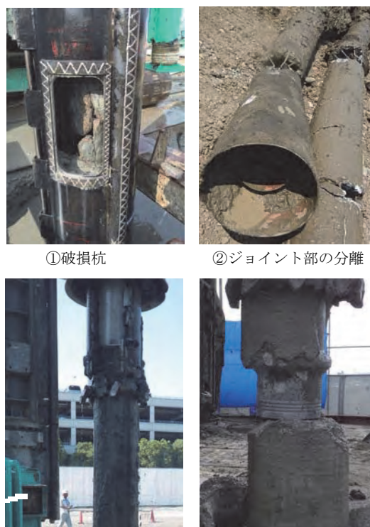
図-3 破損・分離しやすい既存杭の例
