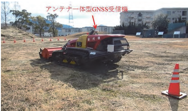
写真-3 動作確認状況
