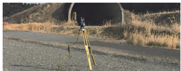
写-5 ノンプリズム TS 計測状況
