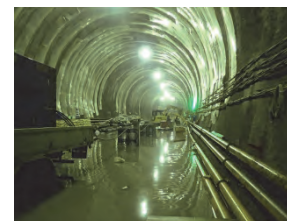
写真-2 坑底部緊急排水状況
