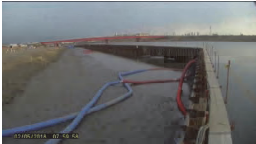
図11 水替えにより水位低下の臨場
