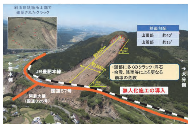
図-1 阿蘇大橋地区被災状況
