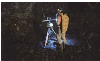
写真-3 3Dスキャナによる切羽の形状測定状況
