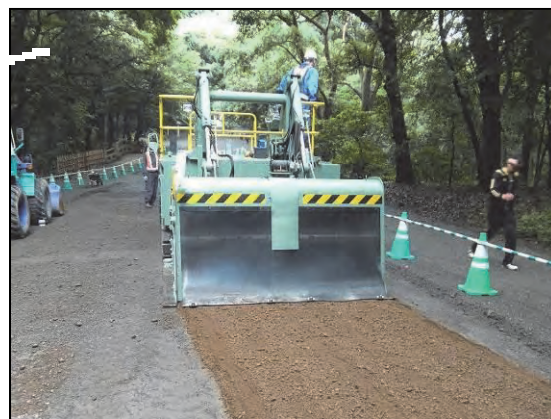
写真-5 改良前・後の状態
