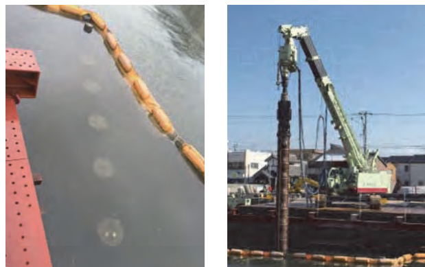
図-8 水中に杭頭がある際の引抜き
