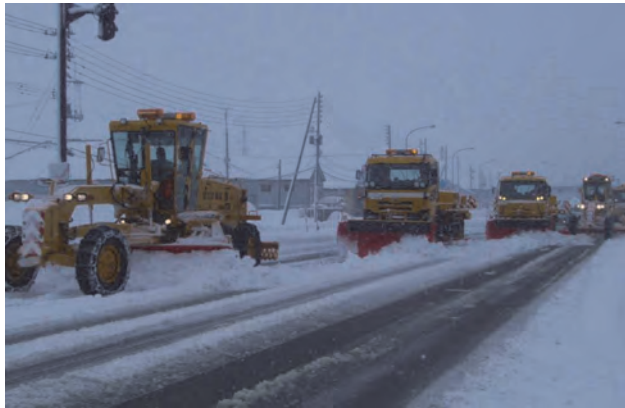
写真-1 北陸の除雪作業状況
