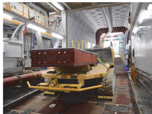
写真-5 セグメント坑内運搬状況
