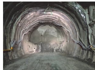
写真-5 切羽湧水導水状況 写真-6 交点部清水タンク
