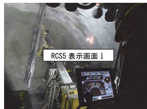
写真-2 マシンコントロールシステム
