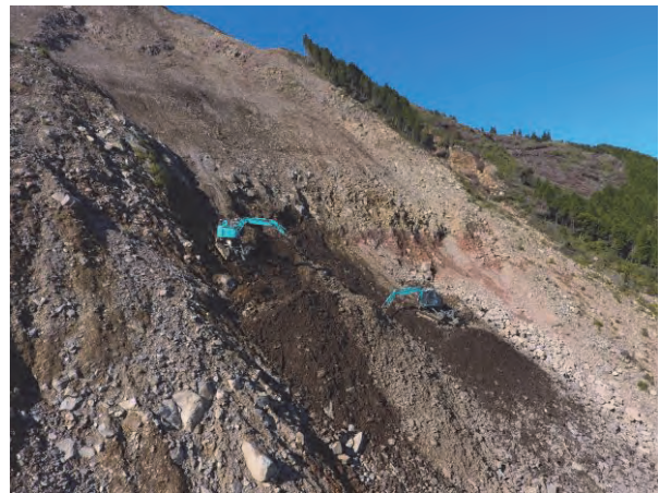
図-13 施工状況近景
