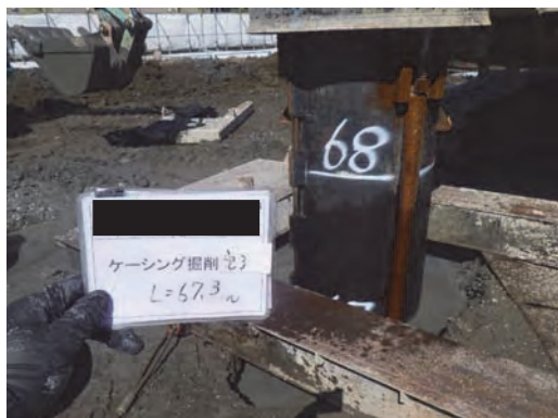
図-9 新設杭干渉部での引抜き (67m)
