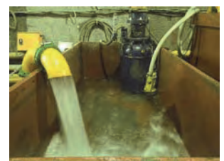
写真-5 切羽湧水導水状況 写真-6 交点部清水タンク
