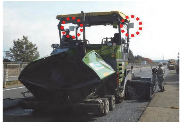
写真-9 Wi-Fi 装置取付け状況
