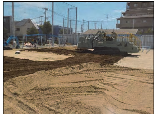
写真-8 狭隘な箇所の施工
