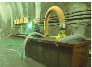
写真-2 坑底部緊急排水状況
