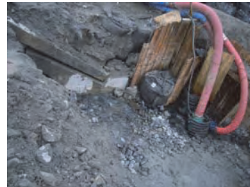
図19 周辺の地盤の変状を矢板で仮押さした釜場の設置状況
