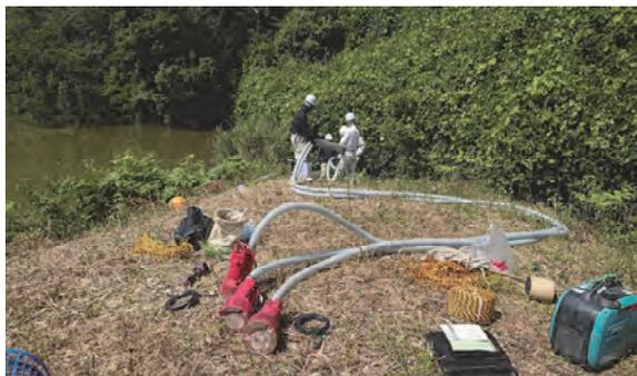
図-4 Φ100 mm「ハイブリッド・S」の各部材は全て人力運搬が可能な部材で構成した。
