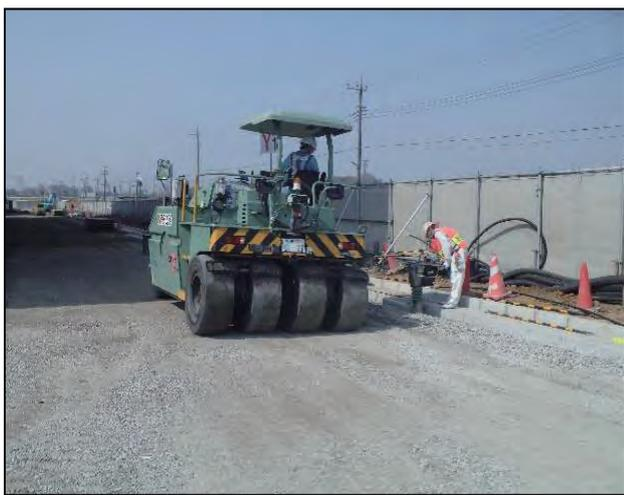
写真-5 外構工事転圧作業状況
