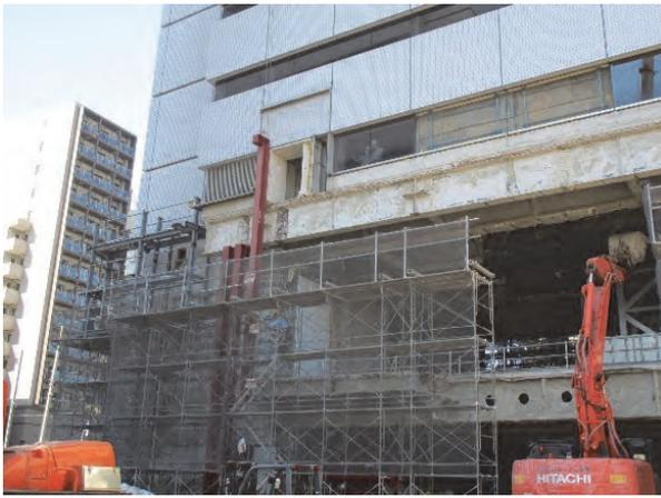
写真-6 ユニットフレーム受け架台
