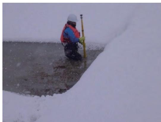
図-1 水没した河床の出来形計測の様子
