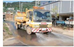
写真-5 散水車による散水作業状況
