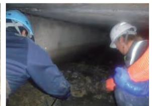
写真-9 排水管清掃作業(水循環式)
