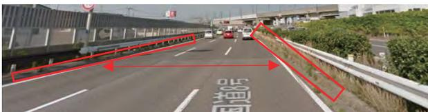
写真-4 横断方向のガイダンス 路側端
