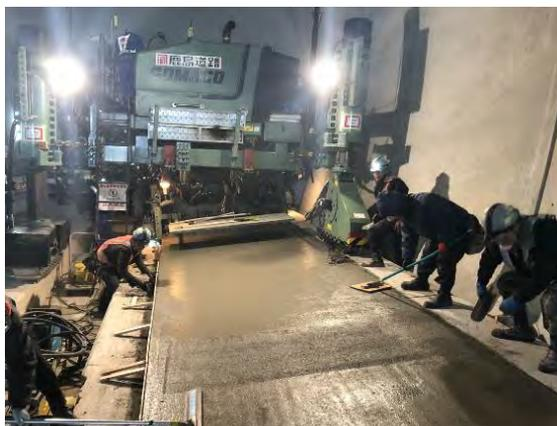
写真-7 敷均し後の仕上げ施工
