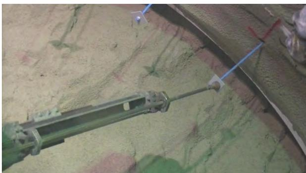
図-3 ロックボルト挿入状況
