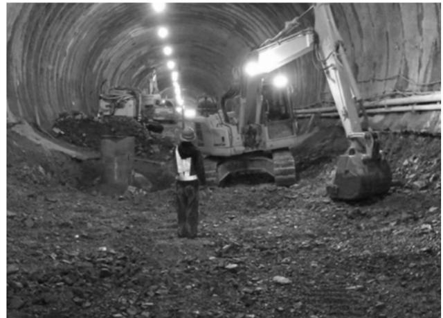
図-15 従来インバート掘削(掘削高さ確認)
