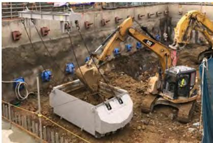
写真-5 実際のずり積込み状況
