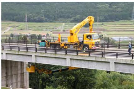
写真-2 橋梁点検車での点検状況
