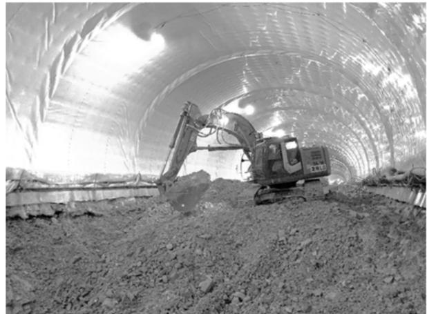
図-14 従来インバート掘削(重機足場状況)
