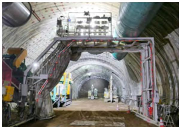
写真-3 防爆カーテン及び警告照明システム
