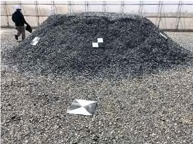
図3 計測対象に標定点を設置した例
