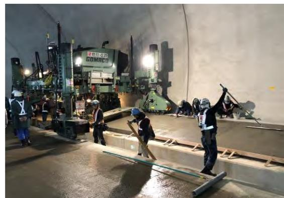
写真-6 施工時写真：敷均し仕上げ
