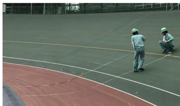
写真-1 目視によるひび割れ調査
