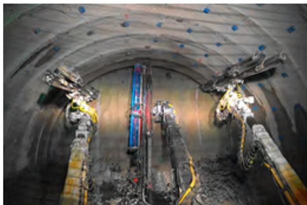
図-17 改良後のユニットの施工状況
