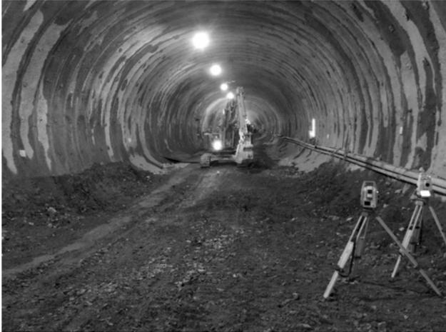
図-7 重機LS-TS及び定置式3Dレーザースキャナにおける掘削面の計測状況
