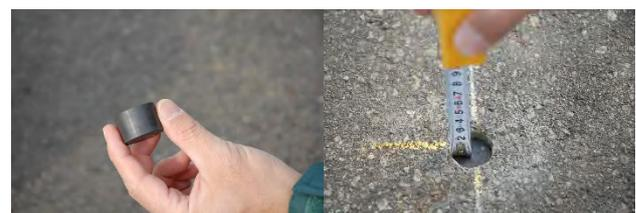
写真-4 磁気マーカ埋設状況
