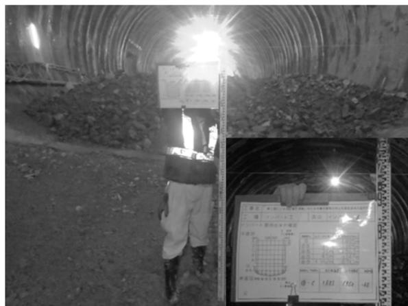
図-6 従来工法による掘削出来形管理(水糸からの下がりによる確認)
