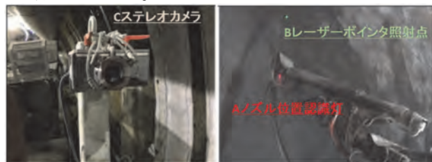
図-4 緑点照射カメラ追尾式ガイダンスシステム図
