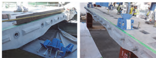
写真-2 PS ジョイント床版接合部
