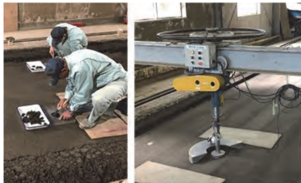
写真-2 測定状況 (左: 砂置換法, 右: CBR)
