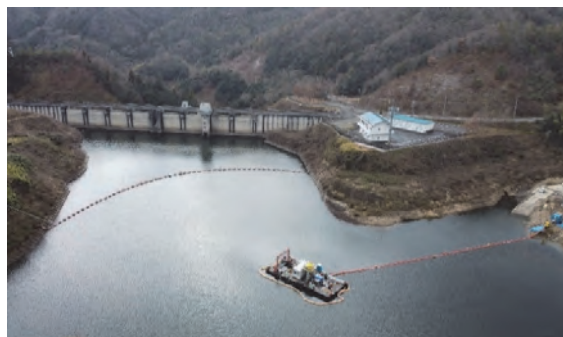
写真-1 ダム湖における試験施工
