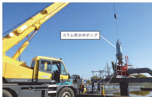
写真-2 コラム形水中ポンプ設置状況
