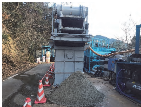
写真-8 陸上ヤード 砂回収状況
