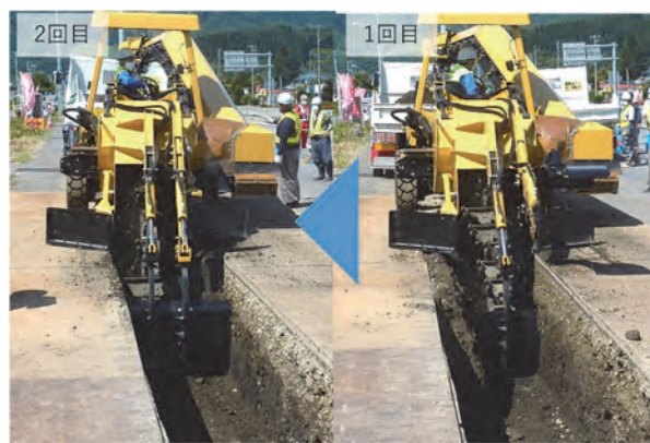
写真-5 トレンチャーでの掘削状況
