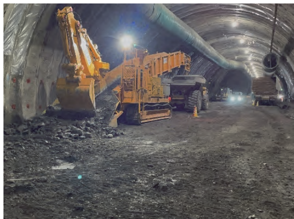
写真-9 トンネル坑内運用状況(前方)
