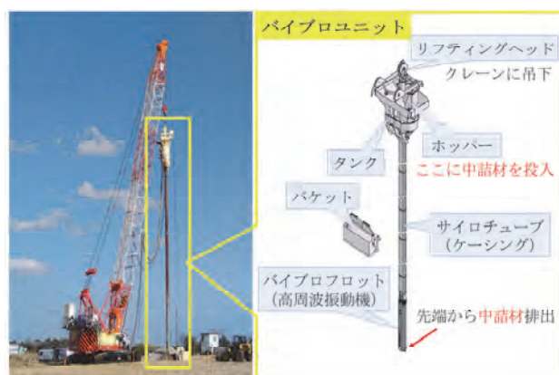
図-1 施工状況および施工機の構成
