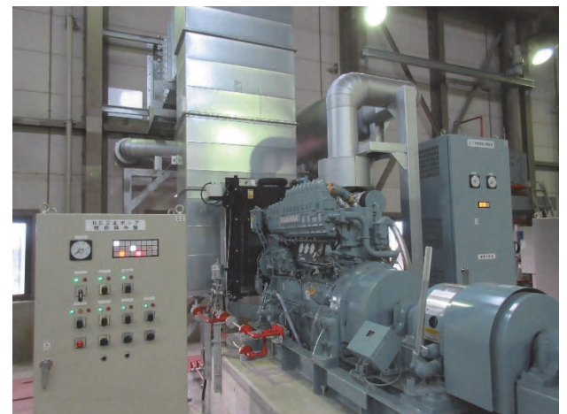
写真-1 主原動機無水化前(上)後(下)
