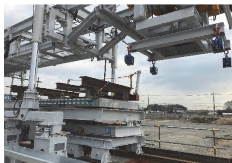
写真-5 運搬台車を用いた床版運搬状況
