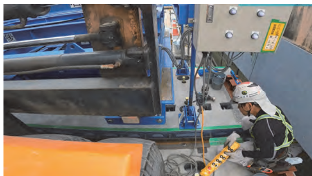
写真-8 心出し装置操作状況
