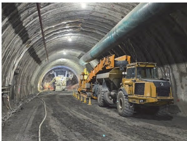
写真-10 切羽の早期解放状況
