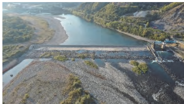
図-2 実証した現場のUAV写真
