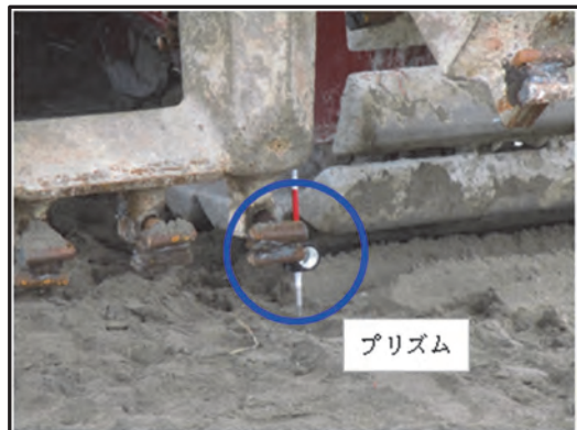
写真-2 攪拌装置先端
