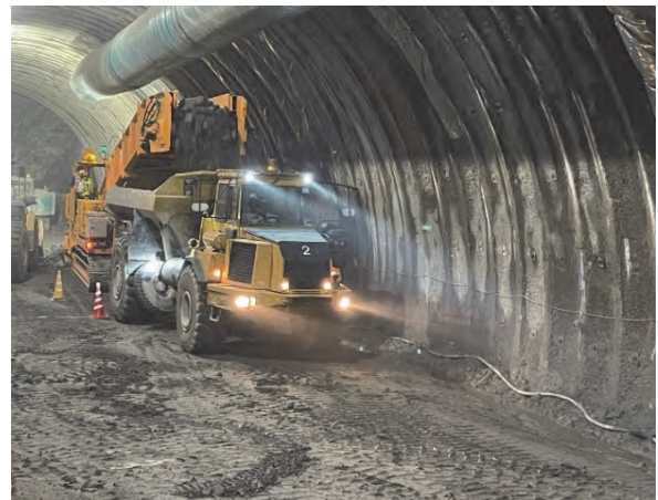
写真-8 トンネル坑内運用状況(後方)
