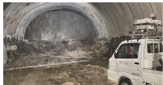
写真-2 3D計測機器設置
