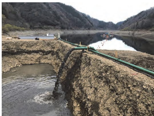
写真-7 湖岸沈砂池
