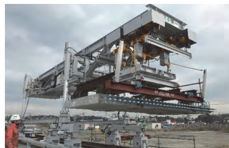
写真-6 床版架設機での床版架設状況
