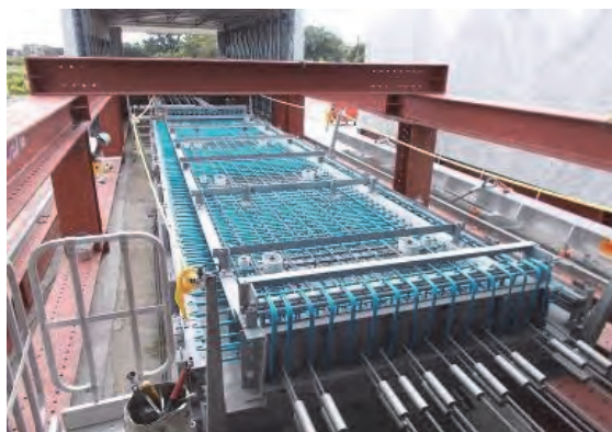
写真-14 床版製作状況
