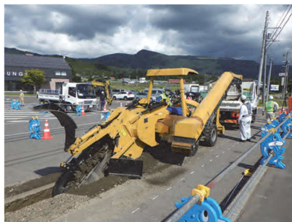
写真-2 トレンチャーによる施工状況
