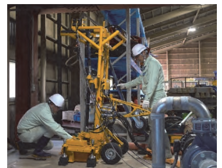
図-3 建屋内高さ制限下での施工
