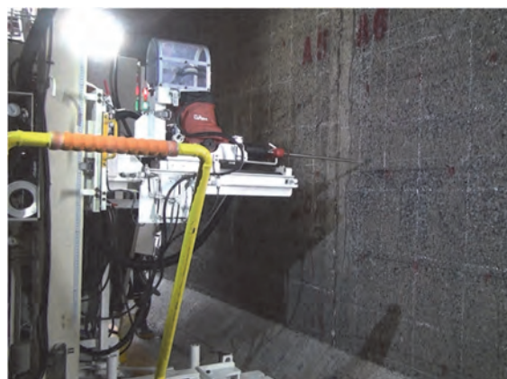
写真-5 自動削孔装置の自動削孔状況
