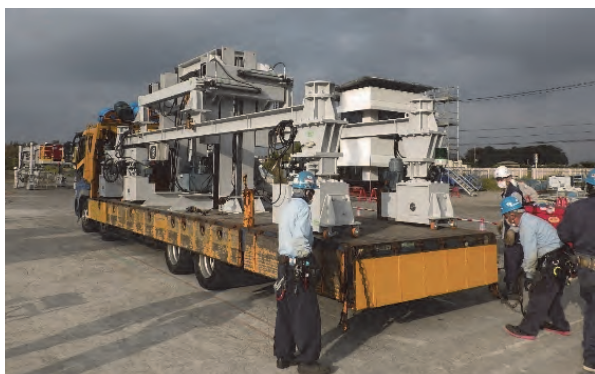
写真-1 架設機走行フレーム運搬
