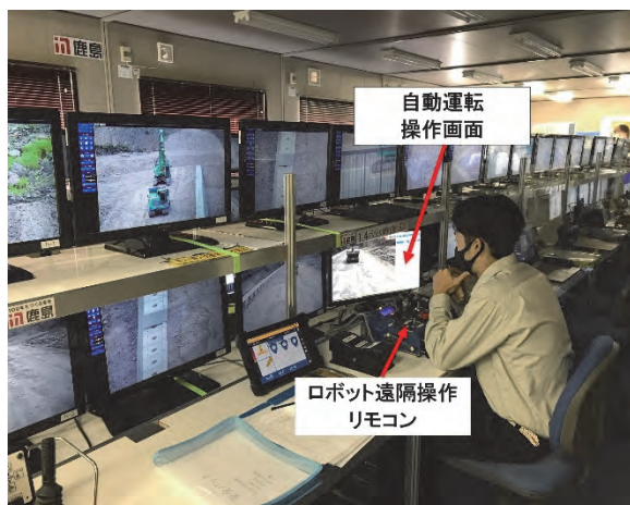
写真-5 操作室状況
