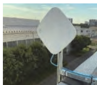
写真-2 アンテナ設置状況 (B 棟)
