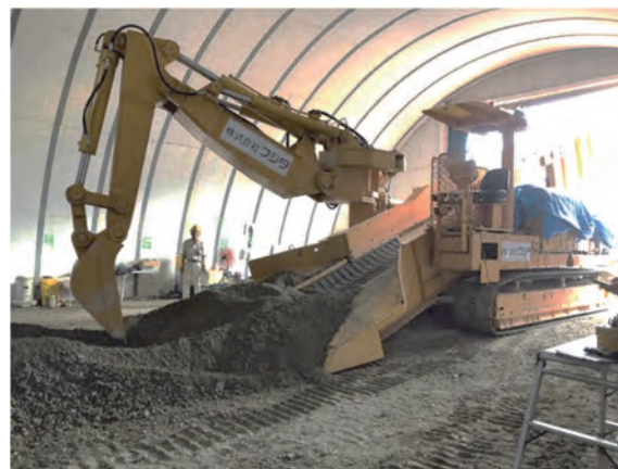
写真-5 模擬トンネル実験状況
