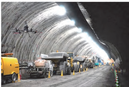
図-5 坑内の自律飛行状況
