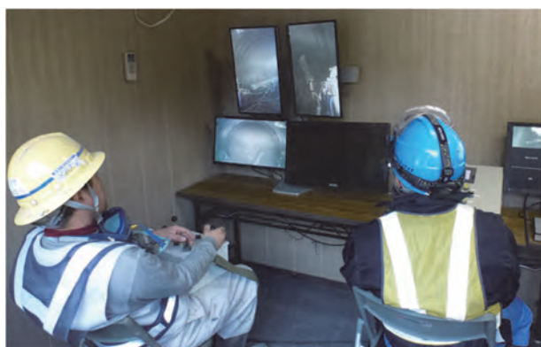
写真-1 遠隔吹付風景
