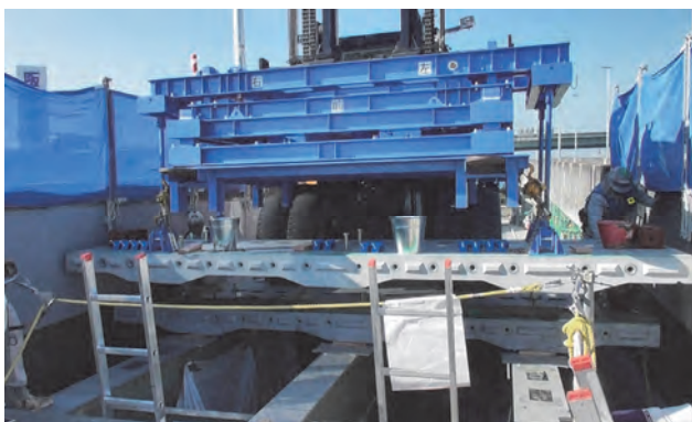
写真-6 PS ジョイント床版運搬状況
