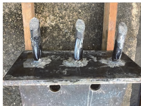
写真-4 頭部を切断したスタッドジベル
