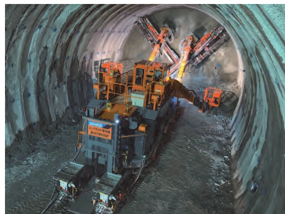
図-1 2 ブームロックボルト打設専用機
