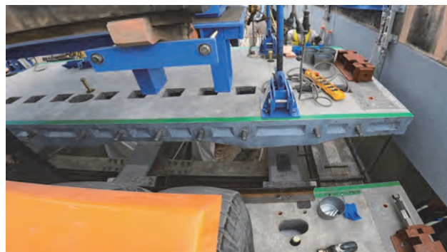
写真-7 PS ジョイント床版架設開始
