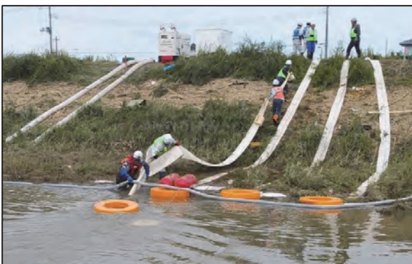
写真一1 排水ポンプ投入現場
