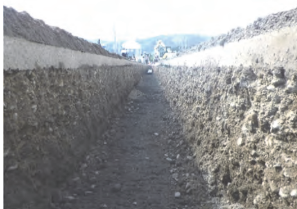
写真-3 掘削後の仕上がり状況
