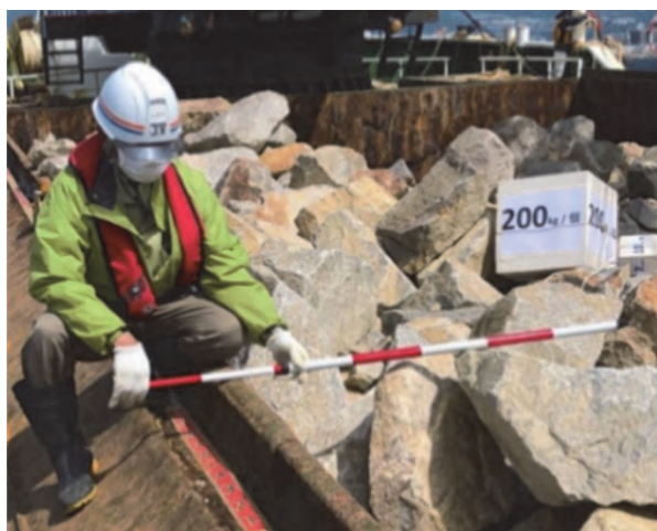
図-5 検収作業状況
