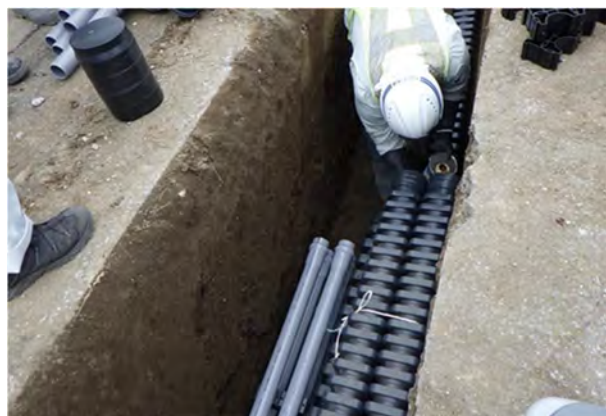
写真-4 敷設状況（角型 FEP 管の接続）
