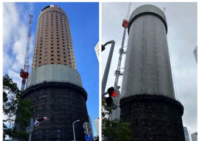
写真-8 FCF 足場（左：組立完了 右：上昇完了）
