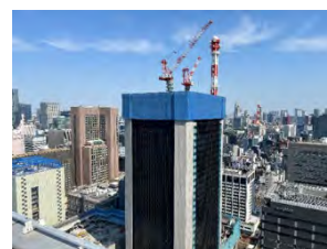
図-2 ブロック解体工法
