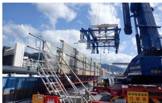
写真-6 床版架設機投入状況
