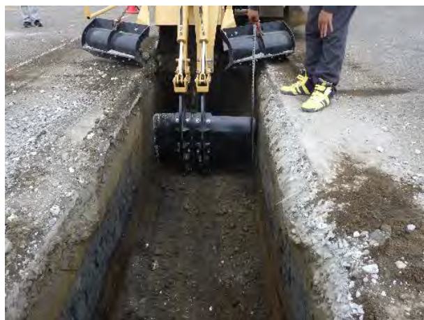
写真-8 掘削状況
