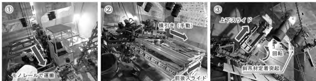
写真-8 斜吊材緊張状況
