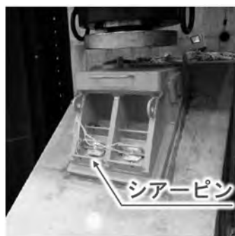
写真-2 载荷試験状況
