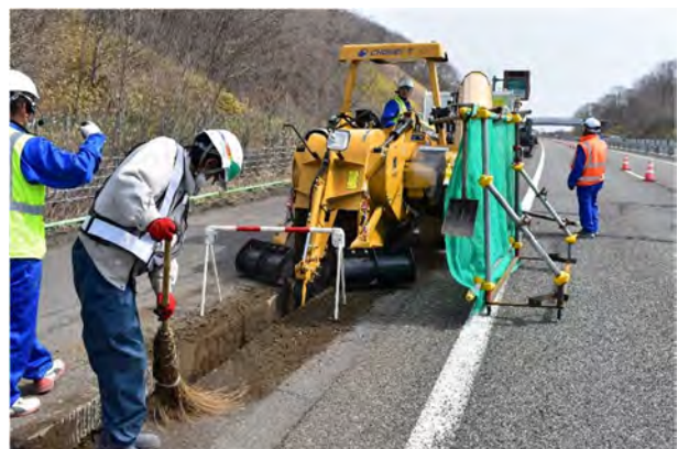
写真-1 掘削状況（高速道路での施工）
