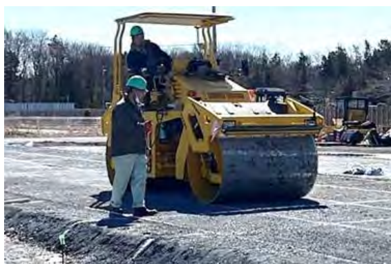
写真-2 7t 振動タンデムローラ
