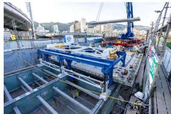
写真-7 床版架設機稼働状況
