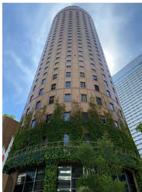
写真-4 施工建物
