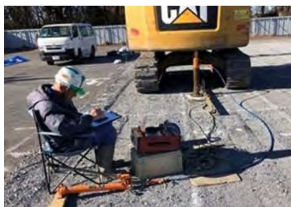
写真-5 平板載荷試験
