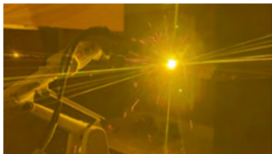
写真-13 自動溶接中の状況
