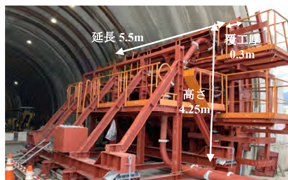
写真-2 中規模の打込み実験
