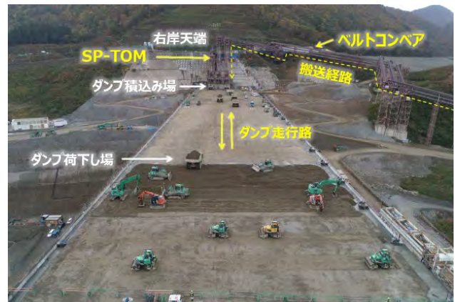
写真-3 堤体全景と材料搬送設備
