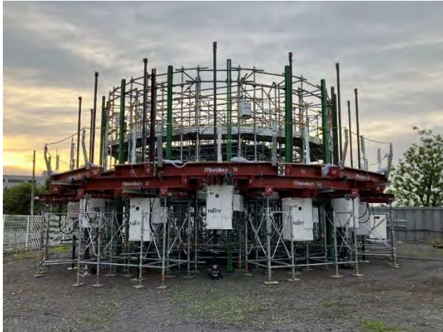
写真－5 実験設備外観
