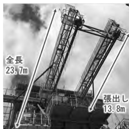
写真-4 片持ち天井クレーン
