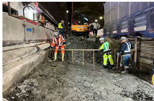
写真-4 通常の出来形管理状況
