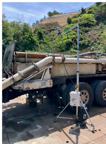
図-4 現場検証時設置状況
