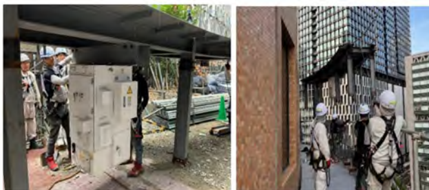
写真-7 FCF 足場の設置状況
