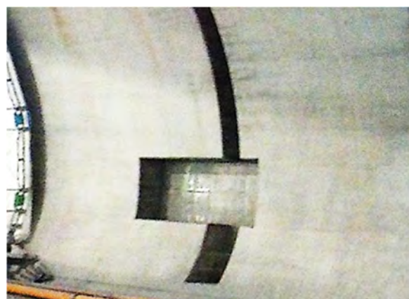
写真-8 箱抜き箇所の充填状態
