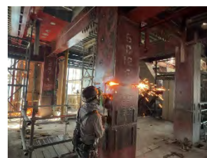
図-4 柱のガス切断
