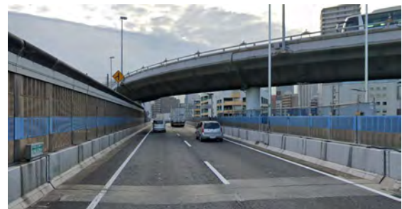
写真-1 工事対象橋梁京橋方状況
