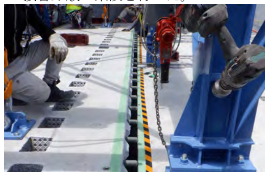
写真-2 PS 接合床版の接合作業状況
