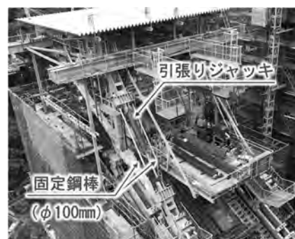
写真-3 引張りジャッキと固定鋼棒
