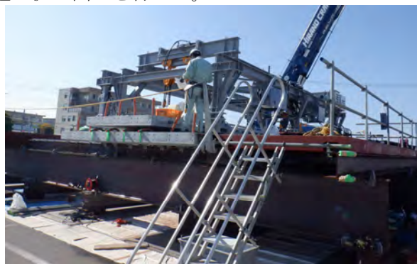
写真-3 実物大施工性確認試験
