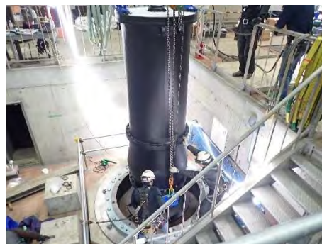
写真-2 主ポンプの据付状況
