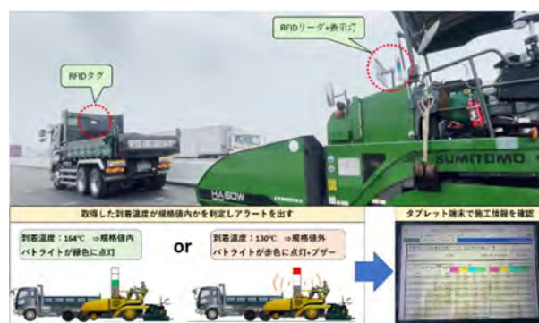
図-10 システム活用時の到着温度計測状況
