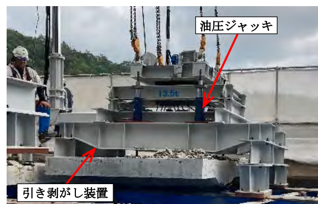
写真-2 床版撤去状況
