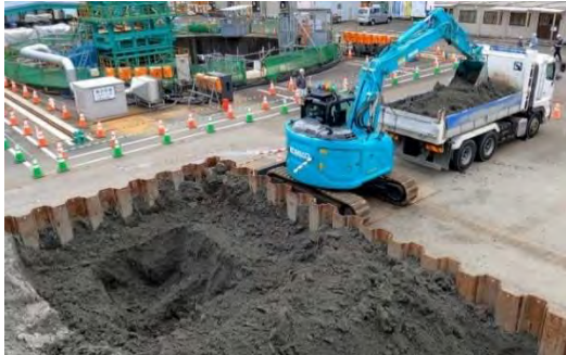
写真-12 自動運転での積込み状況
