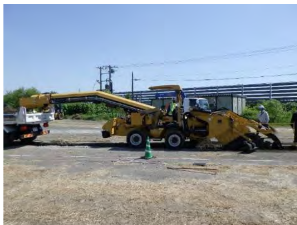
写真-1 トレンチャー試験施工状況
