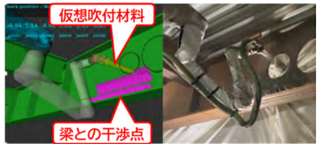
図-7 モーション・シミュレータと実際の吹付
