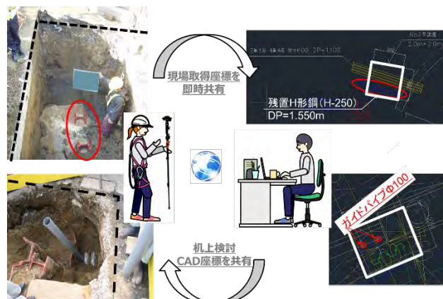
図-7 埋設管試掘後の測位結果共有例
