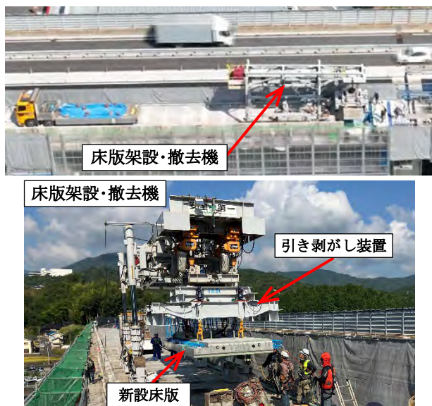
写真-15 伴高架橋（シングル SDR）施工状況
