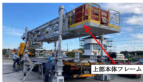
写真-9 上部本体フレーム組立状況
