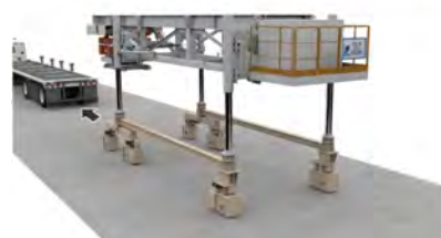
図-7 上部本体フレーム組立ステップ
