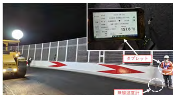
図-6 転圧温度計測状況
