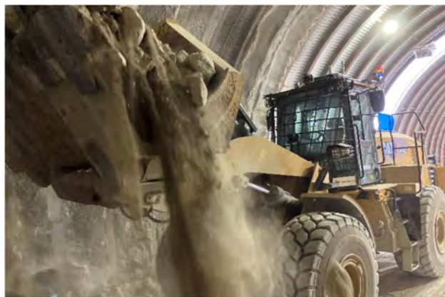
写真-5 自動運転システムによるずりすくい取り状況
