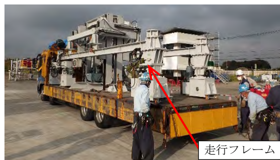
写真-8 走行フレーム組立状況
