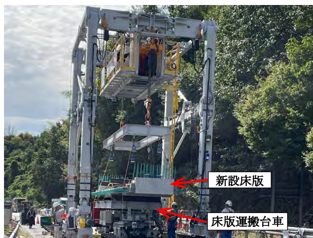
写真-7 新設床版積み替え状況
