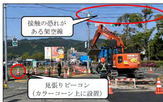
写真-7 交差点アスファルト剥ぎ取り
