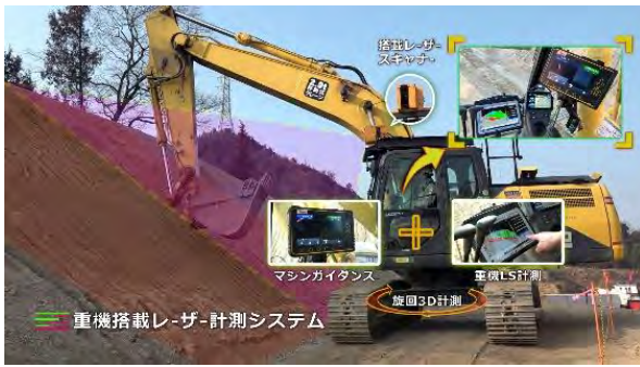
図-2 STEP1 施工しながら出来形管理
