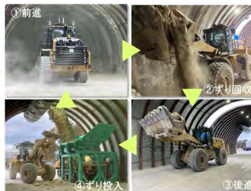
図-1 ホイールローダによるずり出しの一連動作
