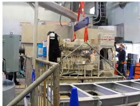
写真-4 エンジンAの搬出状況
