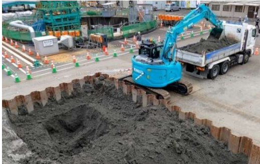
写真-12 自動運転での積込み状況
