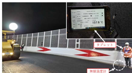
図-6 転圧温度計測状況
