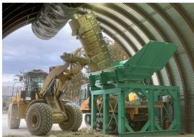
写真-6 自動運転システムによるずり投入状況
