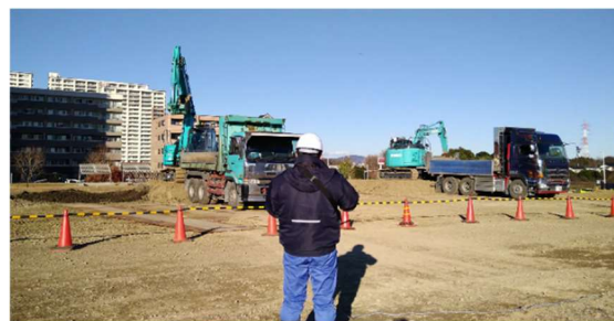
写真-10 自動運転ショベル2台への動作指示状況
