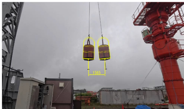
図-12 制振制御 無効時（バケット+錘）
