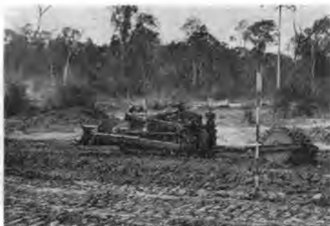
写真-8 タンクにおける土堰堤工事
