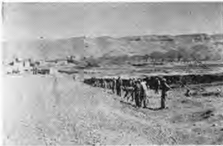
写真-3 兵隊による土工
