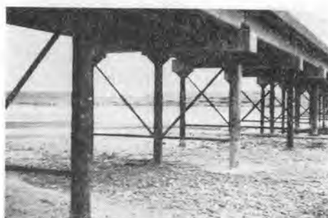
写真-9 アメリカの援助による pre-cast のコンクリートけた (アフガン西南部)
