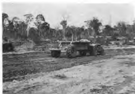
写真-9 タンクにおける土堰堤工事
