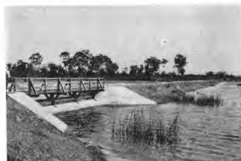
写真—7 タイのコーラード地方に設けられたタンクの堰堤および余水吐堰堤
