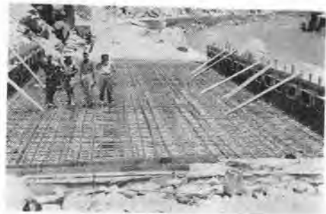
写真-2 ダバリー橋床版の鉄筋
