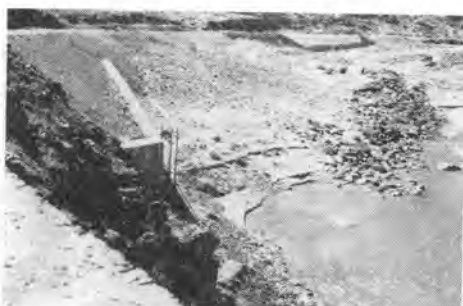
写真-6 完成した道路
