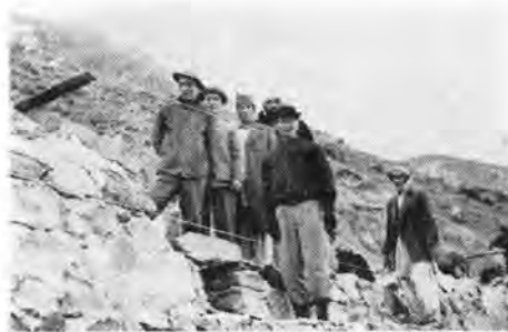
写真-4 雑石と生石灰モルタルにより施工中の擁壁
