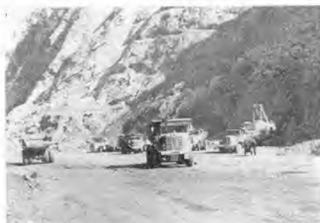
写真-5 ダム掘削工事中のペイホーラダンプトラック パワーショベルはマリオン111M
