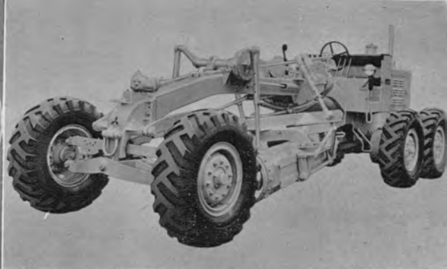
↑ 三菱 LGII型モーターグレーダ(12t) 製作開始：昭和29年3月
