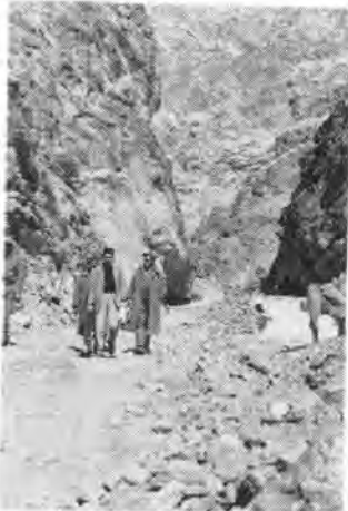
写真-1 草木1つないカブール河畔の工事中の道路
