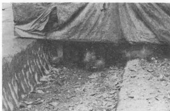
写真-2 D.H 掘削状況および破碎ずり
