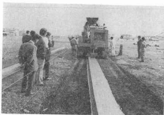
写真-2 コンクリート自動成形機の実演
