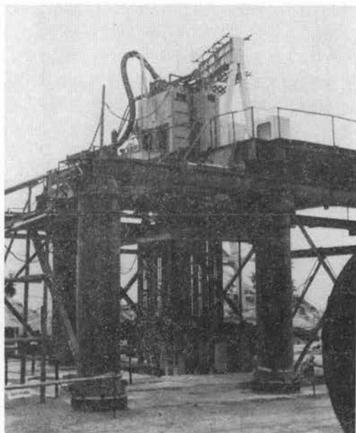
写真-1 D.H掘削機の面掘削試験全景
