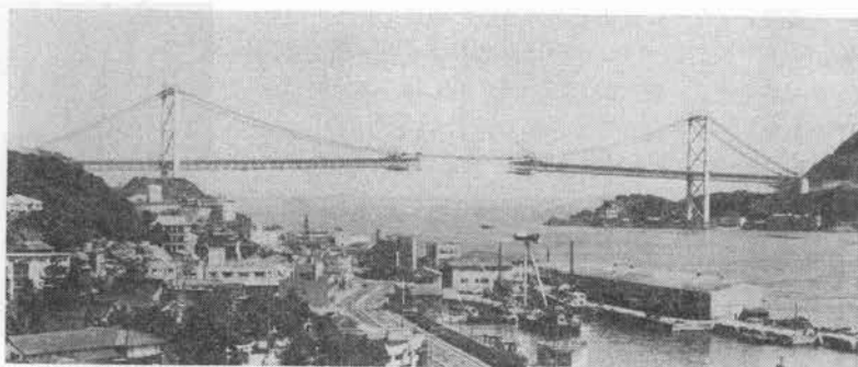
写真-1 ドッキング間近の関門橋
