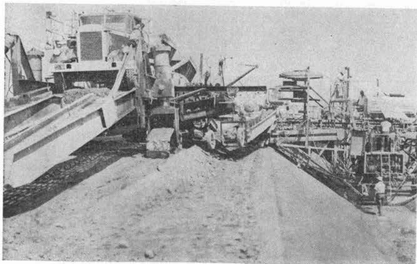
← 写真-1 舗装機が成形された排水路中を前進しているとき、ボトムダンプは舗装機とともに進む自走ランプ上に乗り上げる。
