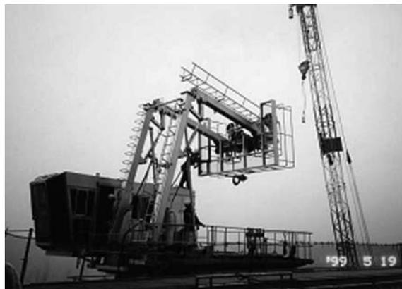
写真一 5 ガントリーの自力折り畳み状況
