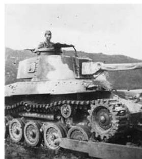
昭和19年、中型戦車にブレードを装着して、ブルドーザ代用テストをした。肝心のブレードは写真から外れているが、ブレードのプッシュロッドが写っている。乗っているのは若かりし日の小生。小口径砲の下の小窓の車内に運転手が乗っており、小窓の右前下にブレードを上下するチェーンブロックのチェーンだけが見える。ブレード操作には、操作手が前部ボンネットの上に乗る、砲身にしがみついてチェーンブロックを扱った。
