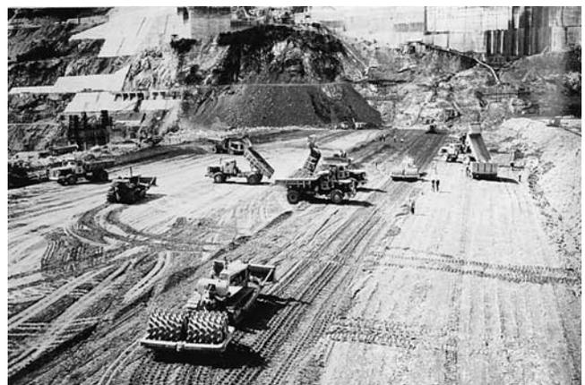
写真—10 土質遮水壁の締固め
