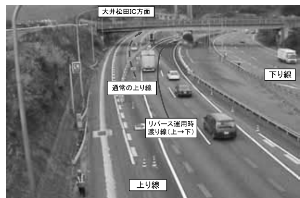
写真-1 御殿場側 移行部
