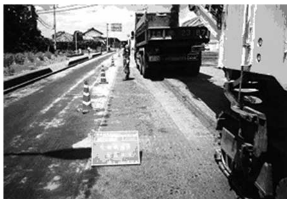
写真一 2 切削工法
