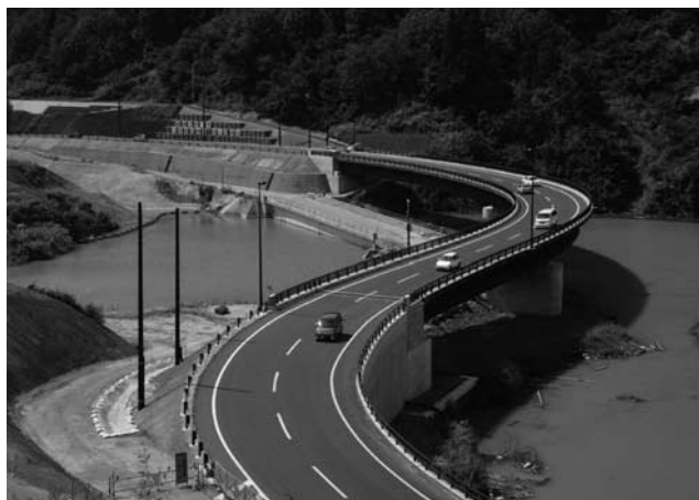
写真—12 供用を開始した新宇賀地橋
