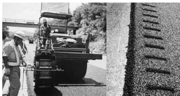
写真—2 転圧式ランブルストリップスの施工状況（左）と出来形（右）
