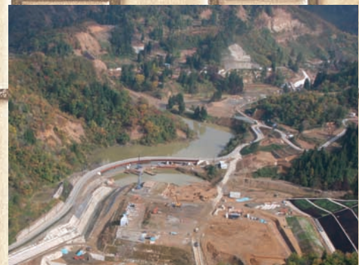
↑復旧した新宇賀地橋 (東竹沢地区)
