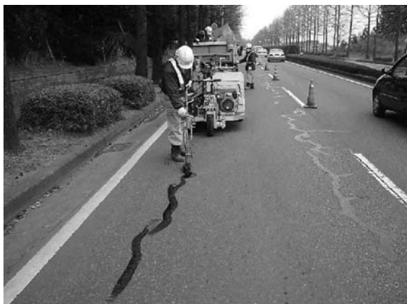
写真一 1 シール材注入工法
