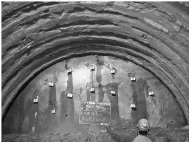
写真一五 長尺鏡補強工
