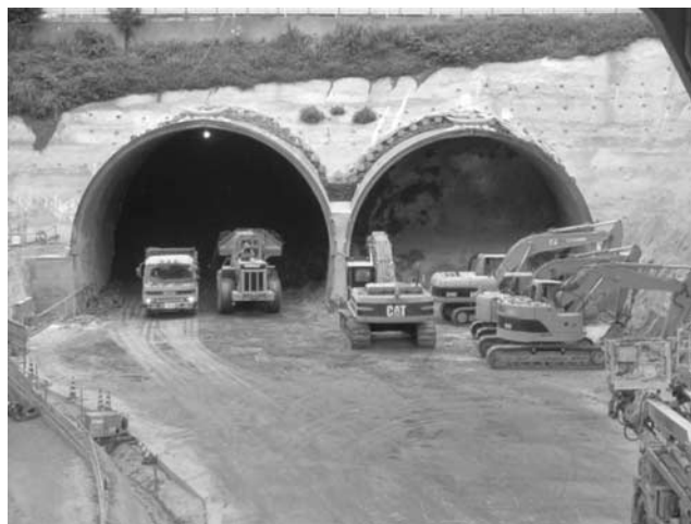
写真一4 坑口部施工状況
