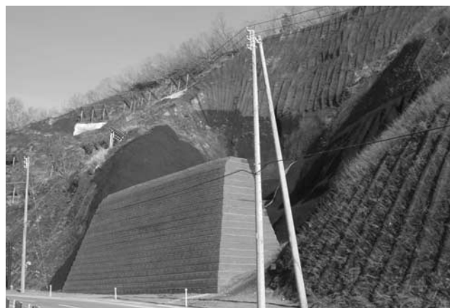
写真—7 雪崩防護擁壁の設置
