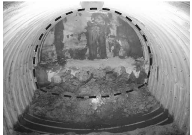
写真一七 全断面の早期閉合状況
