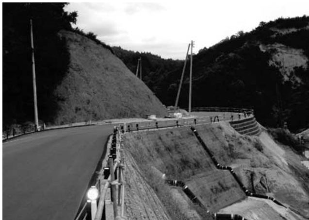
写真一九 補強土擁壁の施工状況
