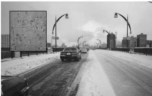
写真—10 ゴムロールの供用路線（左上は路面写真）
