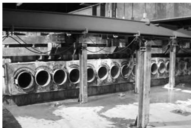
写真—5 水平部パイプルーフ全景
