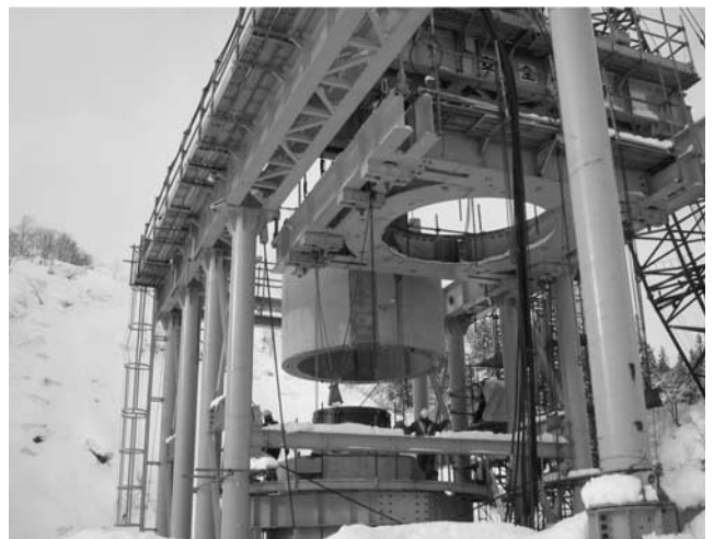
写真一 4 PRCウェル施工状況
