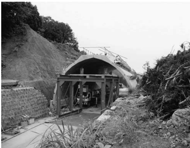
写真一 3 竹沢隧道施工状況
