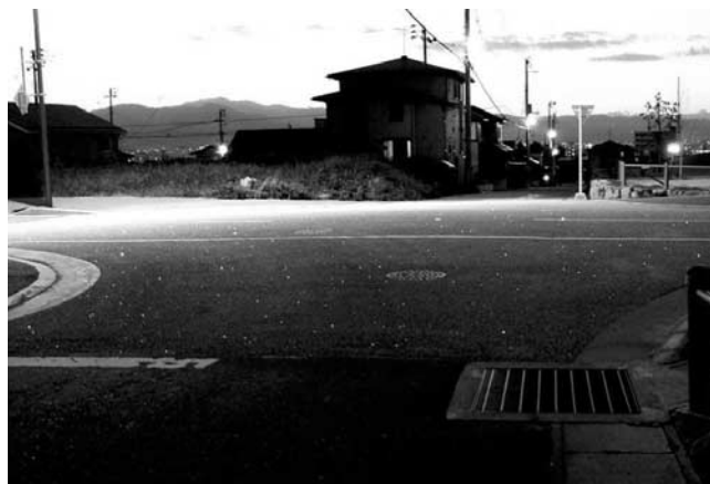
写真—7 光る骨材を利用した路面
