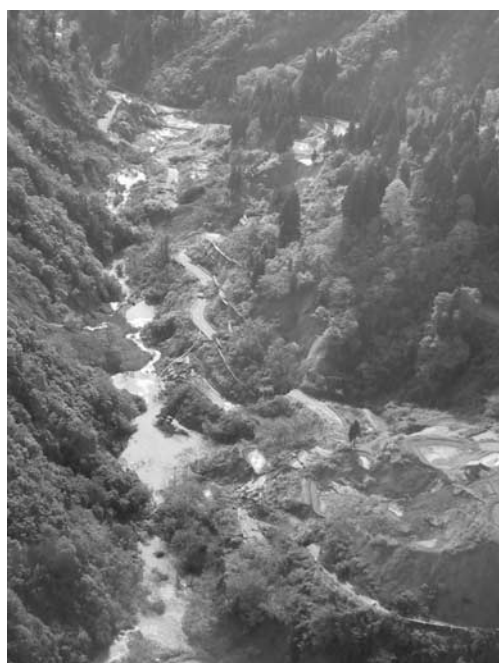
写真—1 被災した神沢川沿いの国道291号
