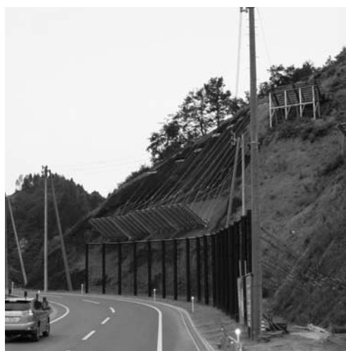
写真—6 せり出し防止柵の設置
