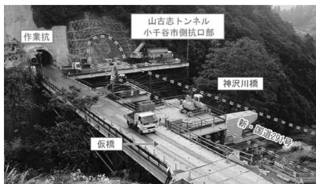
写真—2 山古志トンネル仮橋・作業坑
