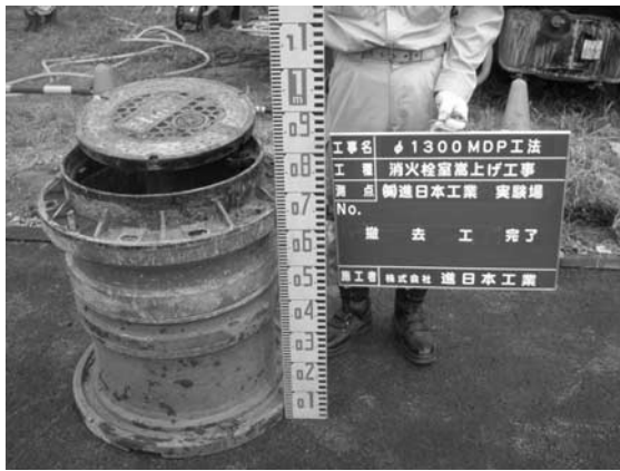
写真一 9 既設人孔撤去
