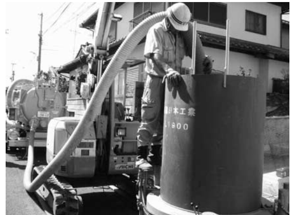
写真四 吸引掘削工
