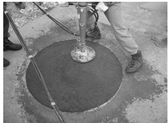
写真一 12 舗装本復旧工
