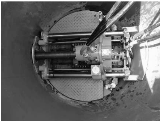
写真五 新設管路敷設（推進工法）
