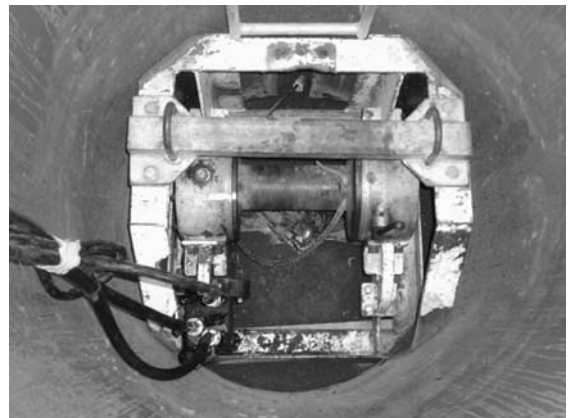
写真六 既存管路更新（引抜き工法）
