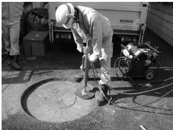
写真一 11 コンパクターによる転圧（埋戻し工）
