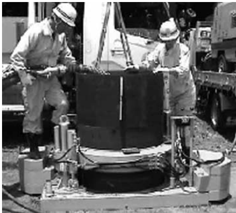
写真三 油圧機・ケーシング設置工
