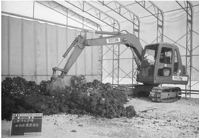
写真—3 生石灰混合（テント内）
