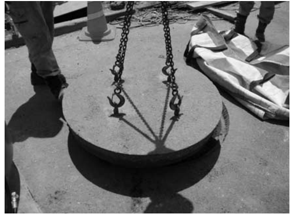
写真二 掘削舗装版処理工
