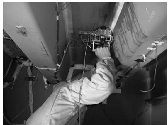
写真—5 タイヤ式鋼床版探傷装置 (（財）首都高速道路技術センターと共同開発)
