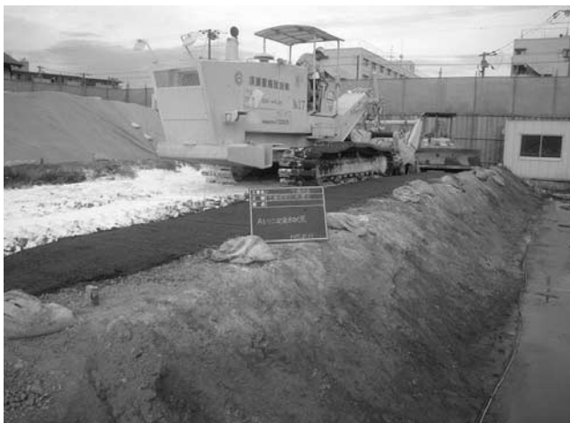
写真—4 スタビライザーによる資材混合状況
