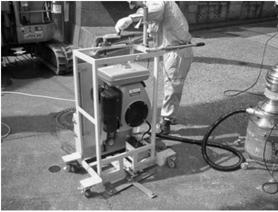
写真一 円形カッターによる舗装版切断工
