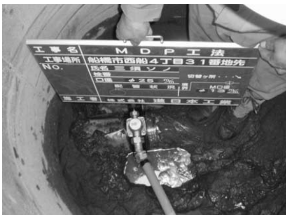
写真七 本管接続状況
