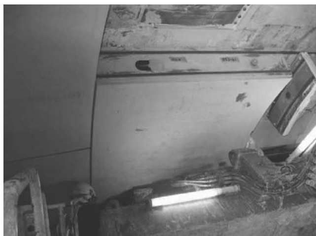
写真一1 セグメント組立状況
