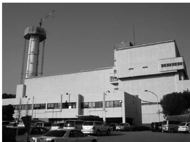
写真—1 S 焼却施設の解体工事状況
