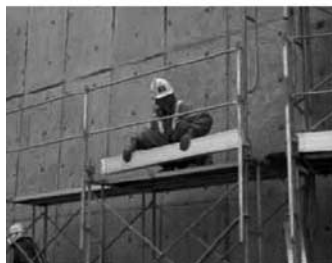
幅木(つま先板)設置作業
