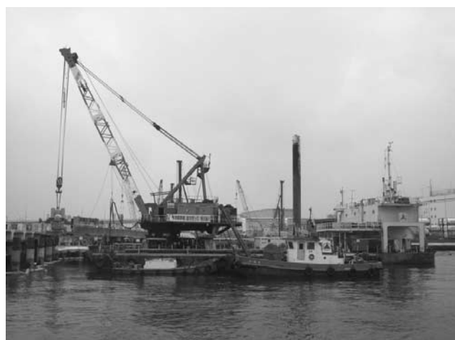
図-16 現場施工状況
