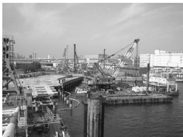
図-15 現場施工状況
