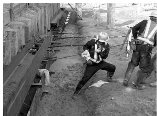
写真—2 除去式アンカーの引き抜き作業状況
