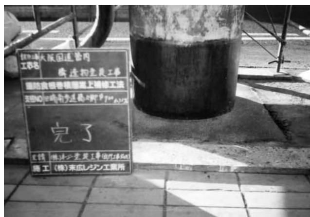
写真一7 *街・やすらぎ【JNK 工法】*完了
