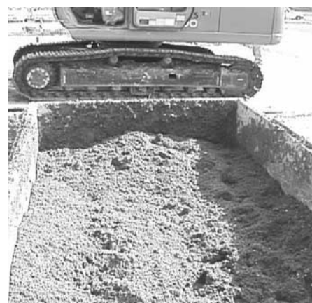
繊維質固化処理土工法により生成された土砂。処理後、直ちに人が乗って歩ける状態にまで改質できる。
