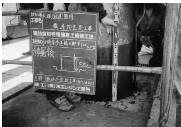
写真一6 重防食根巻積層後
