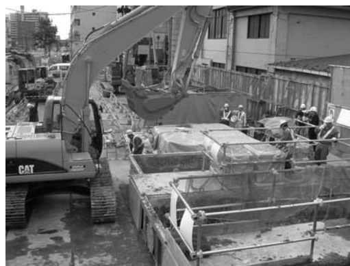
繊維質固化処理土工法を採用した工事現場の様子：仙台市宮城野区小田原から青葉区本町までの一般国道 45 号線道路下にシールド工法により共同溝を 1.37 km 構築する工事（仙台東部共同溝工事）。シールド掘進機を導入するための立坑を掘削する際に排出される汚泥を繊維質固化処理土工法で全量処理し、4 号線バイパス拡幅工事に盛土材として再利用するという完全なゼロエミッションを実現した現場である。
