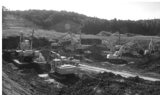
写真—7 築堤改良工事状況（事例2）
