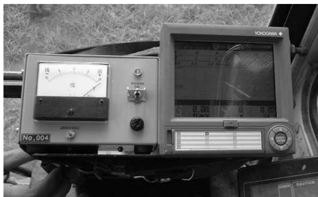
写真ー3 施工管理装置
