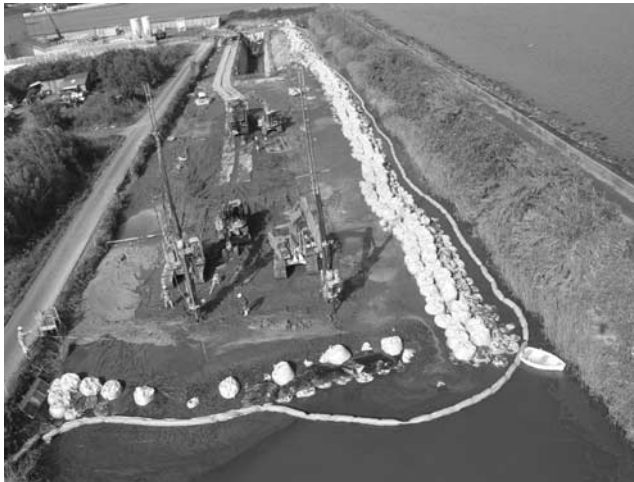
写真—4 超軟弱地盤上での施工状況
