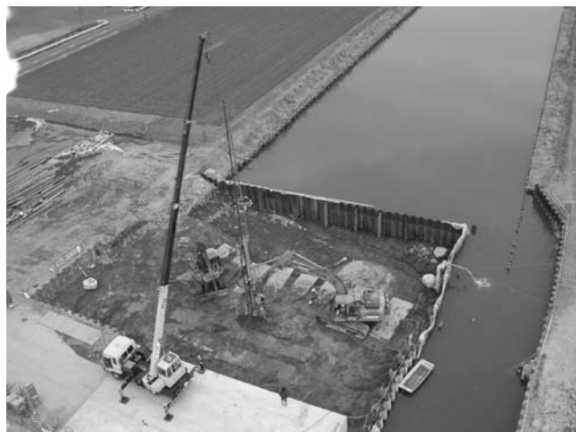
写真-2 構造物基礎施工状況
