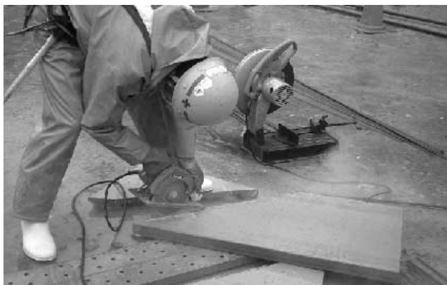
写真—5 切断加工状況
