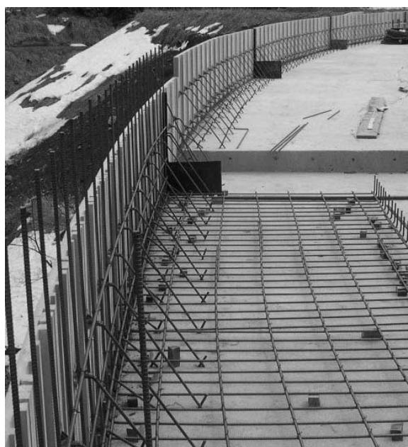
写真—8 曲線区間の施工例
