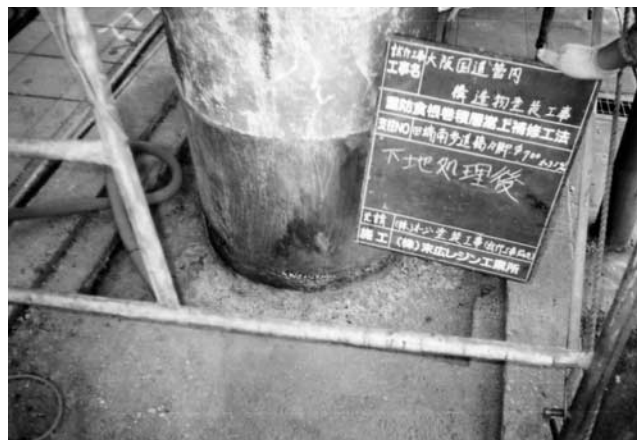
写真一5 はつり粗面化・下地処理後
