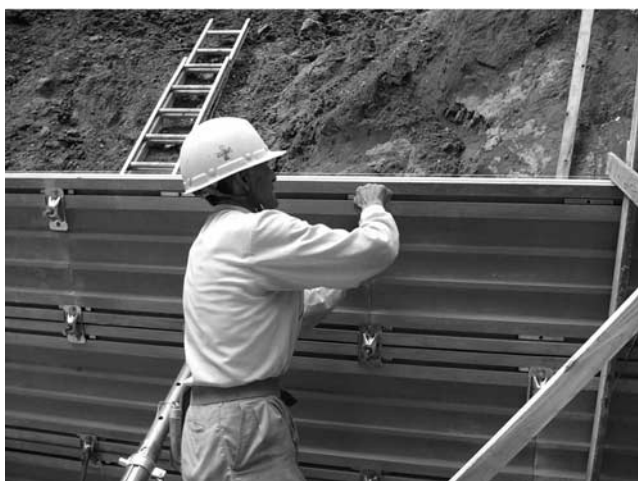
写真—6 接続金物の取付状況
