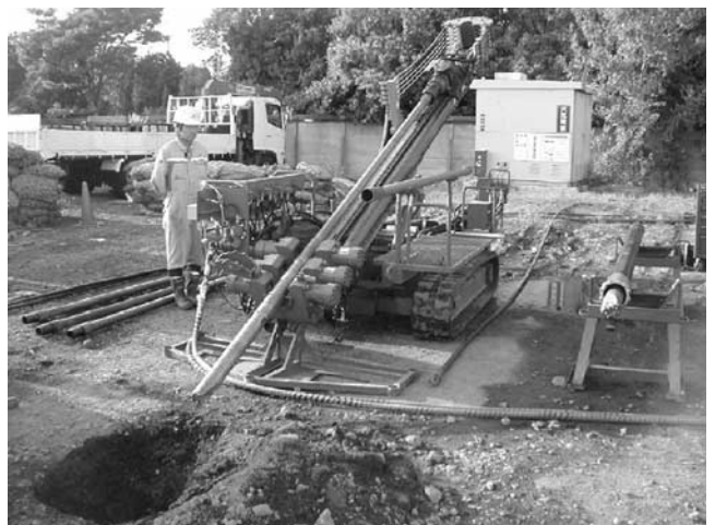
写真-2 専用ボーリングマシン
