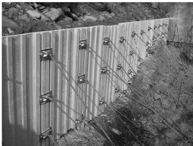
写真—7 縦使いの施工例
