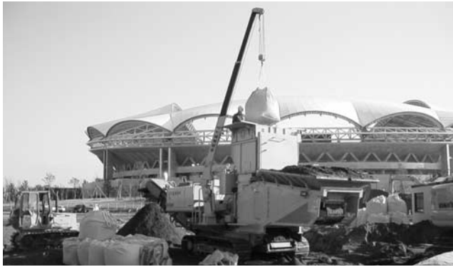
写真—8 地盤改良工事状況（事例3）
