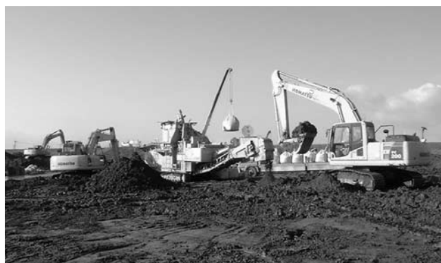
写真—6 護岸掘削改良工事状況（事例1）
