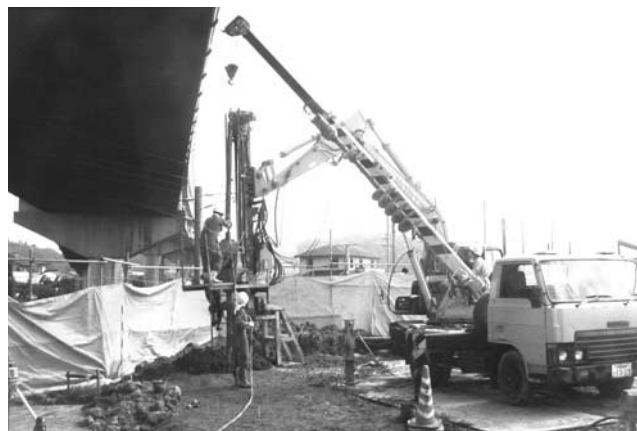
写真-3 上空制限下での施工状況
