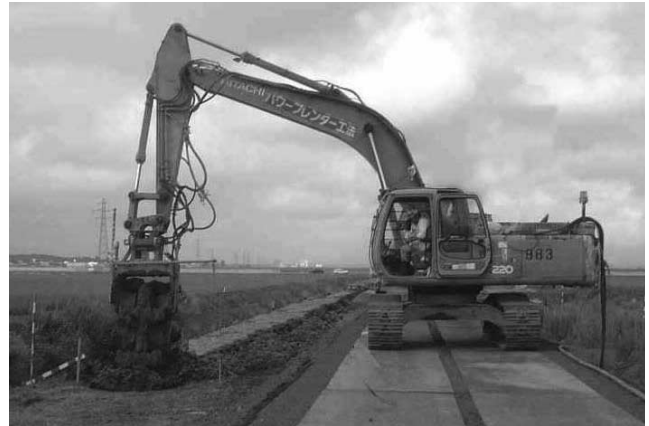
写真—5 地中連続壁の造成状況
