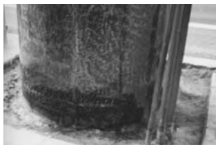
写真—9 下地処理後
