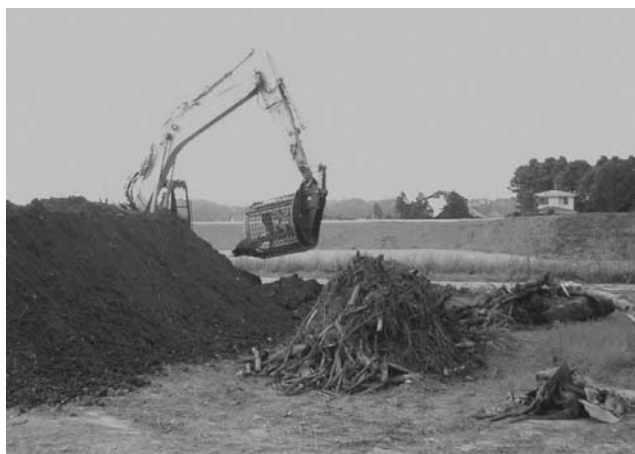
写真ー2 分別施工状況
