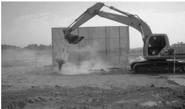
写真—5 散布時の改良材の飛散
