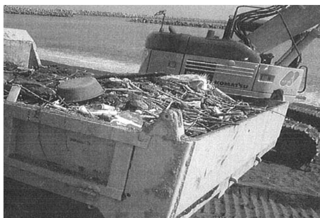
写真-8 清掃状況
