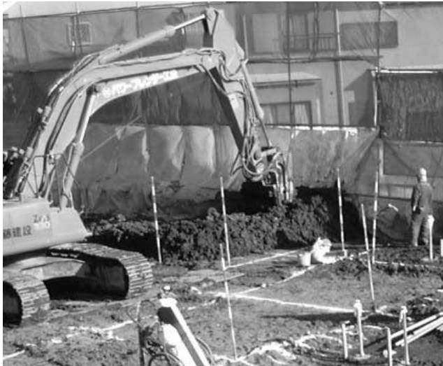
写真—4 施工状況
