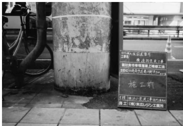
写真一4 施工前
