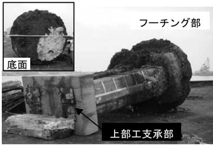
写真一2 転倒した左岸側橋脚
