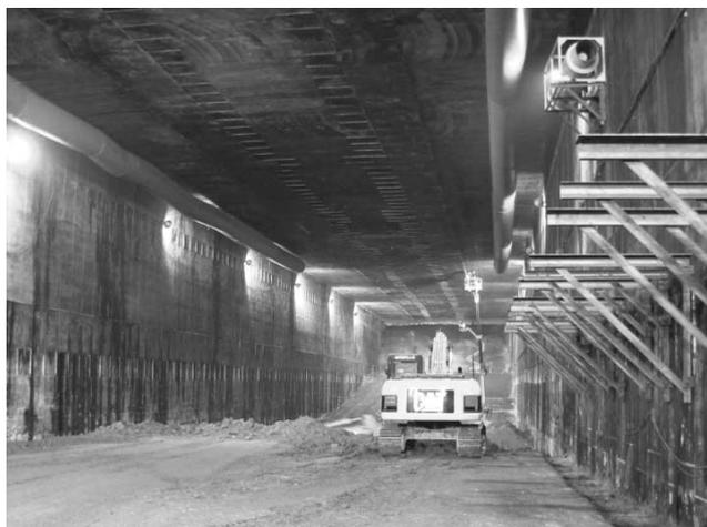
写真—1 内部掘削状況
