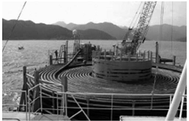
写真一七 ターンテーブルからの取水管送り出し
