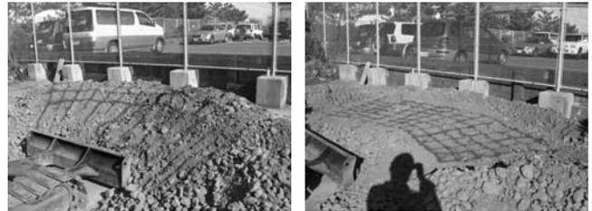
写真一4 遠隔均し実験 (左：施工前 右：施工後)
