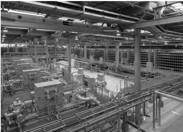
図-4 UF膜のユニット(奥)と高圧RO膜用ポンプ(手前)
