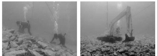
写真—1 捨石均し (左：潜水士 右：水中バックホウ)
