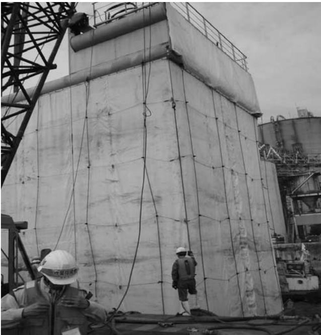
写真-3 汚濁防止膜の組立状況
