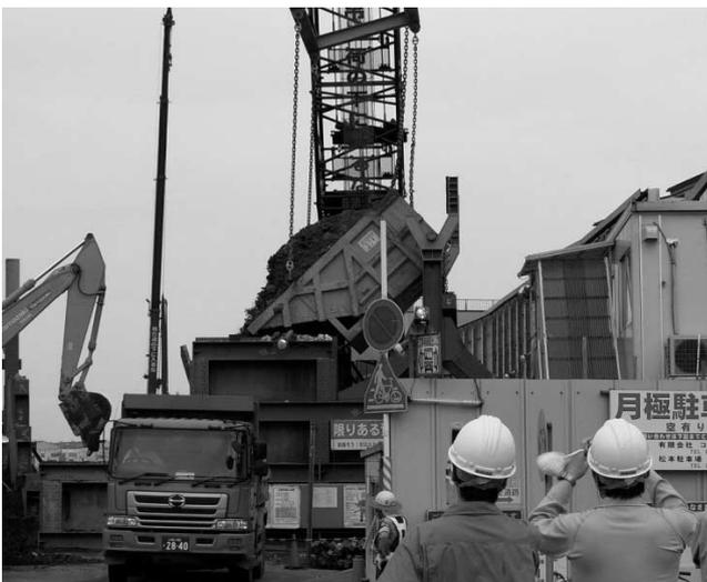
写真-3 転倒式ベッセルによる掘削残土搬出状況
