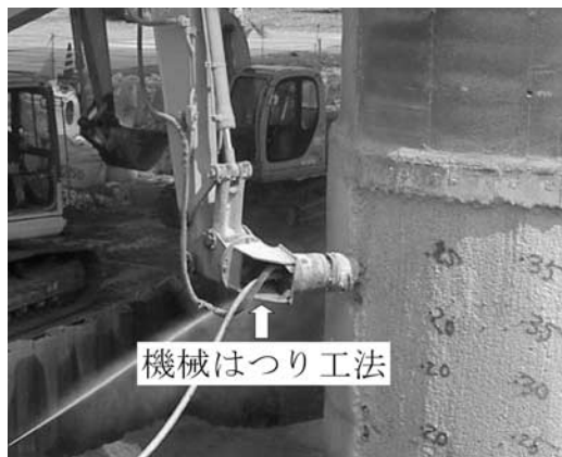
写真—9 機械はつりによる施工状況
