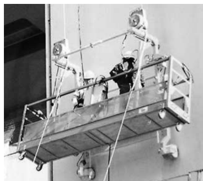
写真—1 磁石車輪ゴンドラ
