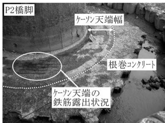
写真—5 基礎天端鉄筋露出
