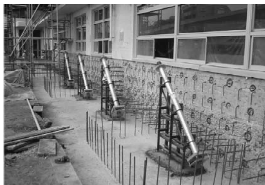
写真—4 斜め PC 鋼材固定用治具設置
