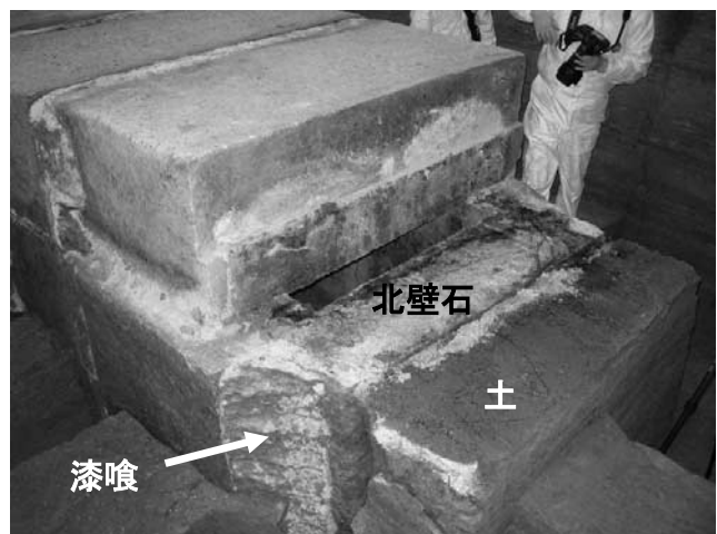
写真—3 最北側の天井石4の解体後
