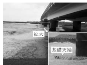
写真－2 基礎洗掘状況
