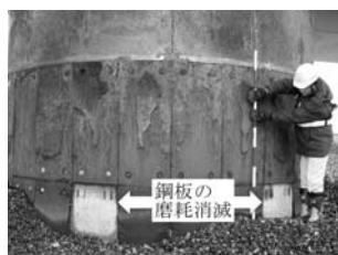
写真—4 銅板の磨耗消失状況
