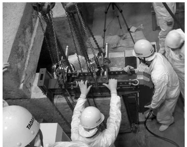
写真―6 Ⅰ型治具使用 東側壁石3（685 kgf, 116 × 89 × 42 cm）
