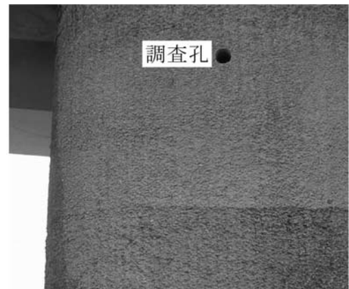
写真—10 コンクリートはつり面の状況（WJ工法後）
