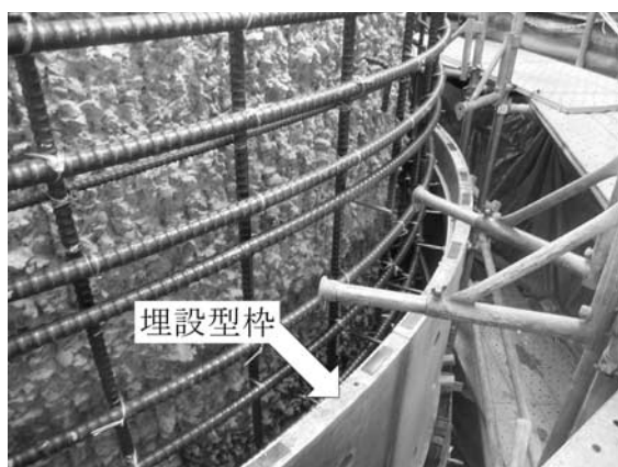
写真—7 埋設型枠取付け状況
