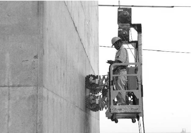
写真一 2 真空吸着車輪ゴンドラ
