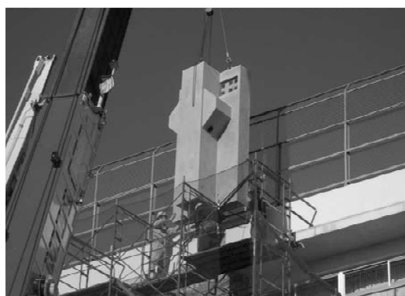
写真—5 PCa 柱部材の建て込み
