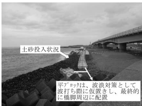
写真—6 土砂投入状況
