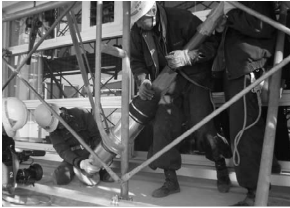
写真—6 斜め PC 鋼材の固定端の取付け
