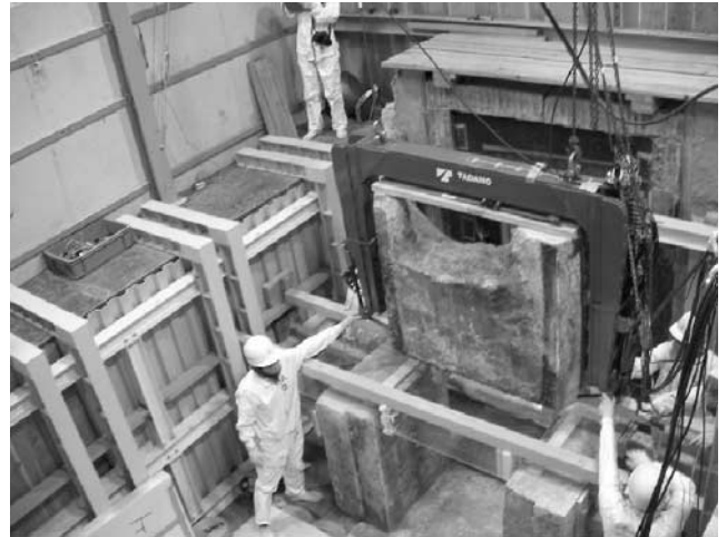
写真―4 Ⅱ型治具南壁石用使用 南壁石（835 kgf, 118 × 137 × 54 cm）
