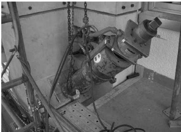
写真—7 斜め PC 鋼材の緊張
