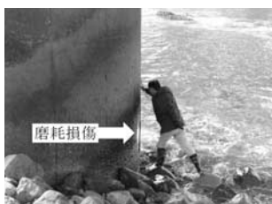
写真—3 橋脚磨耗状況
