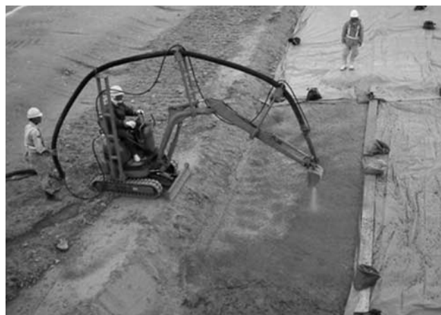
写真—4 吹き付け施工状況
