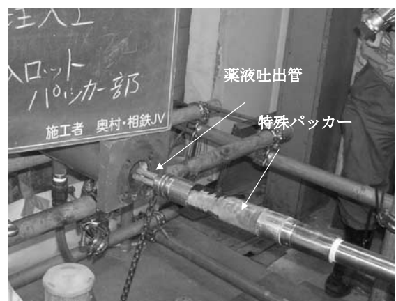
写真—4 一次止水（薬液注入）
