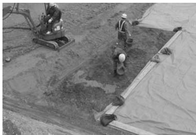
写真—3 クレイスラリー塗布状況
