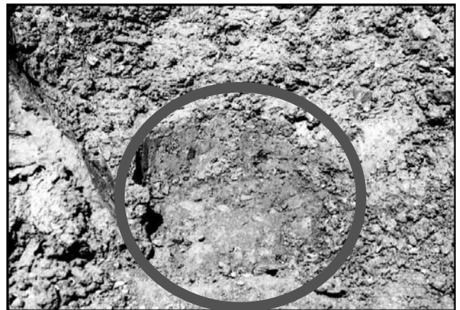
写真—7 基盤面への貼り付き状況
