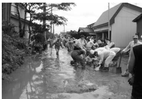
写真—1 人海戦術による排泥作業状況
