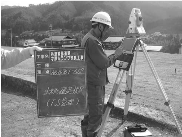
図—9 出来形管理写真の例
