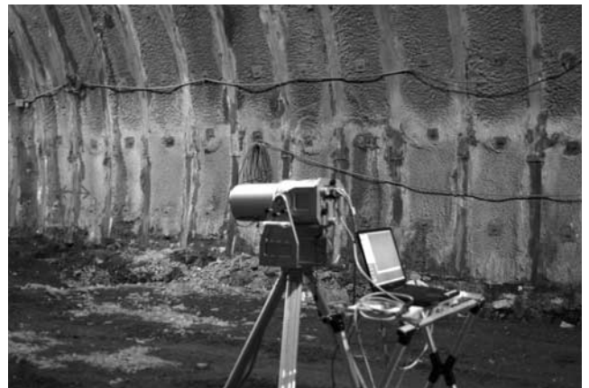
写真—4 3次元レーザースキャナー設置状況（横向き配置）
