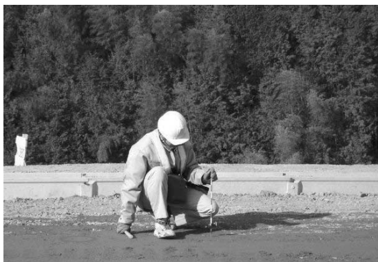
写真—4 測定時のミラー設置状況
