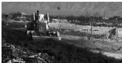
写真—8 カブール空港近辺での爆破処理の瞬間
