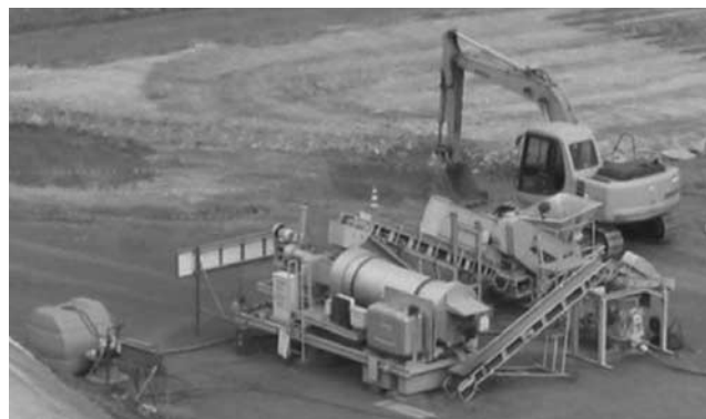
写真—1 システム全景 (吹き付け用バックホウを除く)
