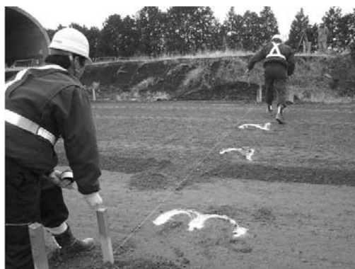
写真ー1 現行施工路盤整形時の確認作業
