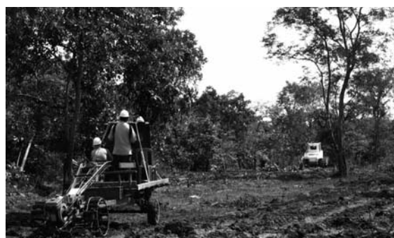
写真—11 ラジコンによる操縦と更地化
