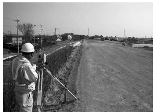
写真—3 TS による出来形計測状況
