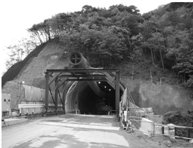
写真一5 敦賀バイパス小河トンネル
