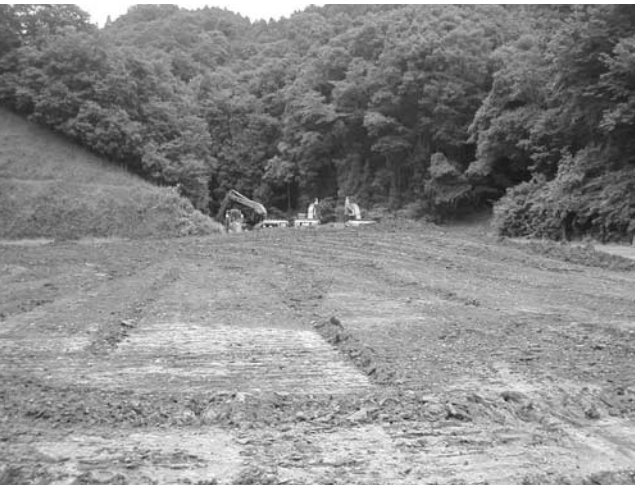
写真一4 施工後出来形写真
