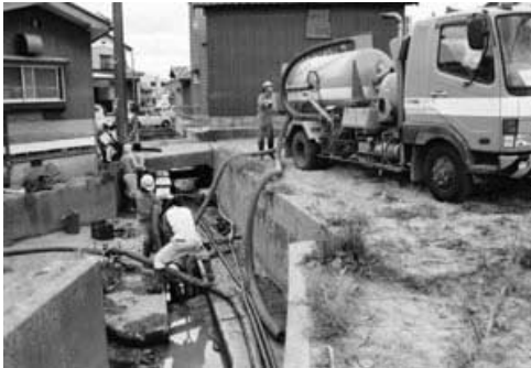
写真-3 汚泥吸引車による作業状況
