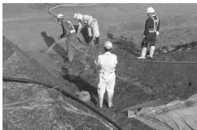
写真—2 岩盤清掃状況
