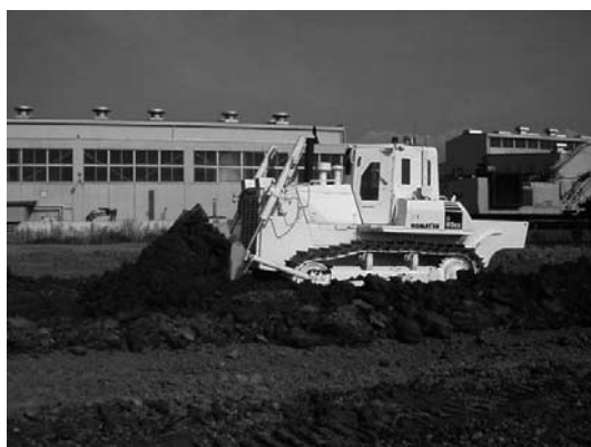
写真—22 ブレードによる整地作業
