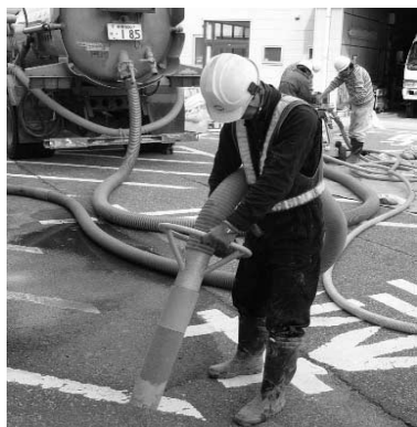
写真—5 既存装置
