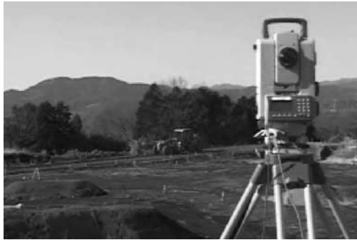
写真—2 情報化施工路盤整形時の状況
