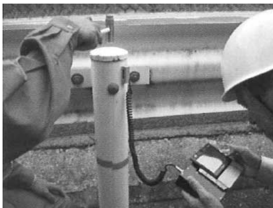
図—10 防護柵支柱の地中埋込深さ検査
