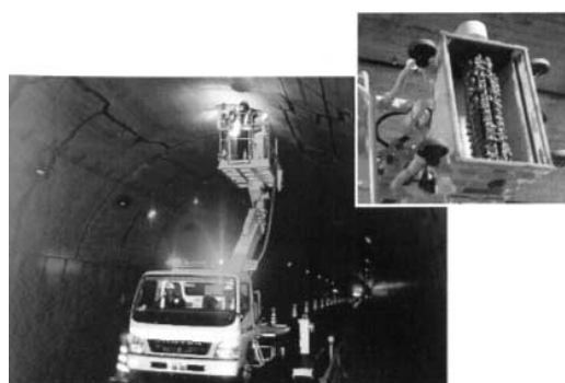
図—6 トンネル覆工打音点検システム
