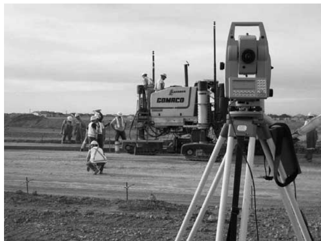
写真—3 TS による CSP の 3D 制御
