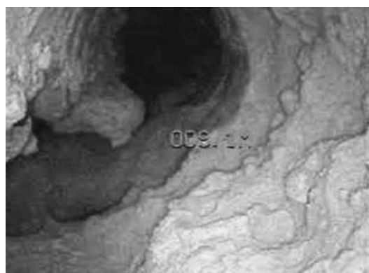
写真—1 孔内写真（従来工法）
