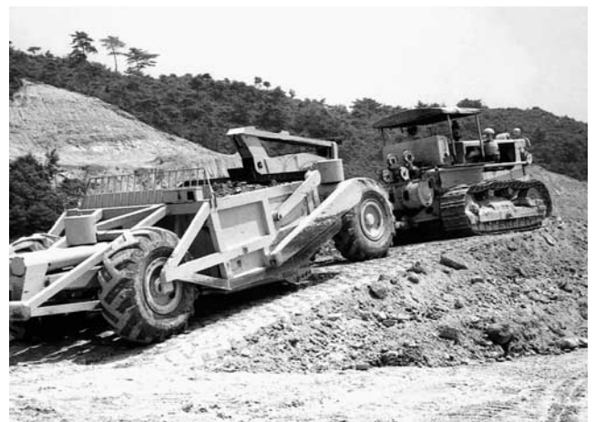
写真—7 D120 トラクタに牽引される RS09 キャリオールスクレーパ 1964 年（昭和 39）
