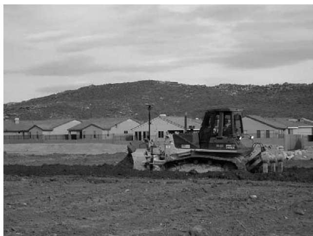
写真—5 GPS-3D-MC ブルドーザによる宅地造成工事(米国ユタ州)
