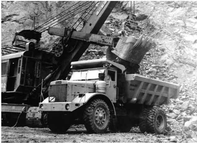
写真—4 佐久間ダムで稼働中の HD150-1 15t 積みダンプトラック、1954 年（昭和 29）
