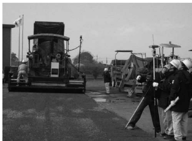
写真—2 AF への高精度 GPS-3D-MC の適用
