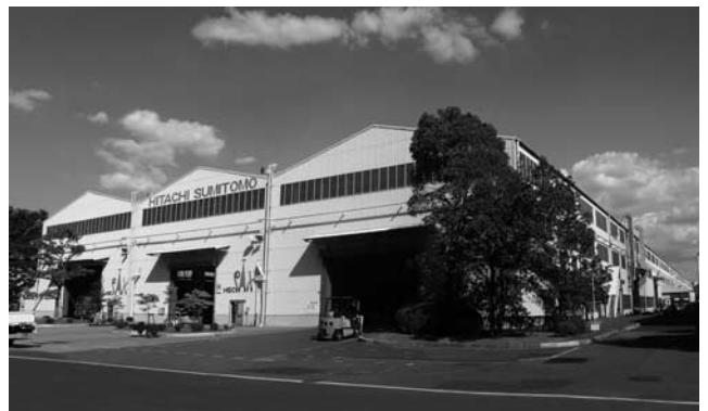
写真—2 工場全景
