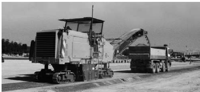
写真—4 TS-3D-MCによる路面切削機制御
