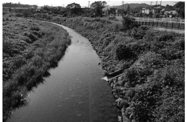
写真—3 平井川：根固工の位置が浅いため淵が失われている
