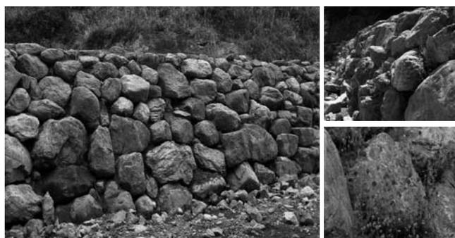
写真—10 深目地施工(左)と目地に詰めた地元の種子入り粘土(右)
