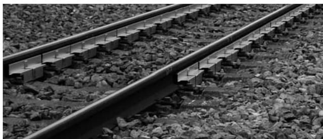
写真—4 レール吸音材の敷設状況
