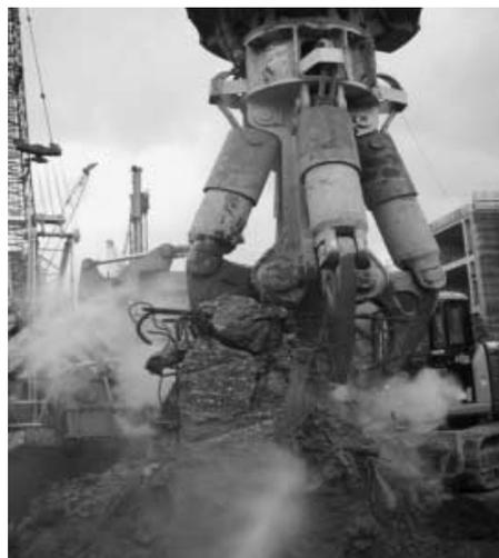
写真-2 つかみ出した障害物をそのまま地上にて破碎・選別する
