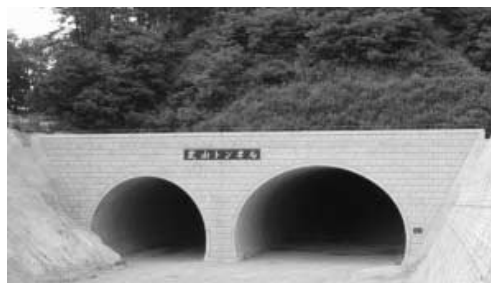
写真—4 坑門工完成後
