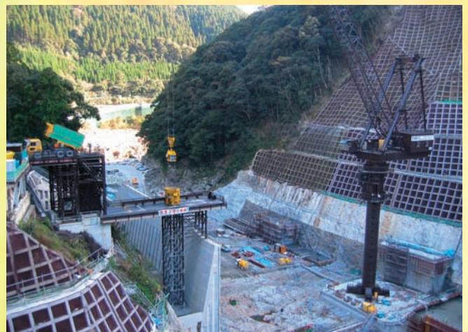
⇧タワー・クレーンによる下部ダムコンクリート打設状況
