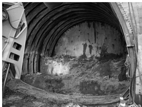
写真—6 識名トンネル掘削状況(補助ベンチ付き全断面掘削+早期閉合)
