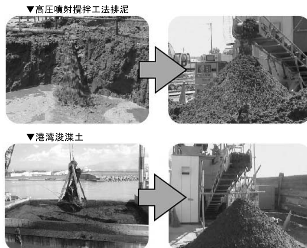
写真―1 泥土の処理前後の状況
