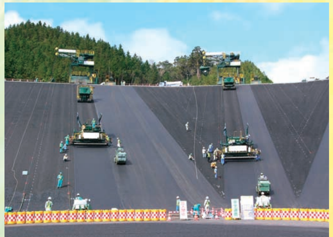
⇧上部調整池斜面部舗設状況
