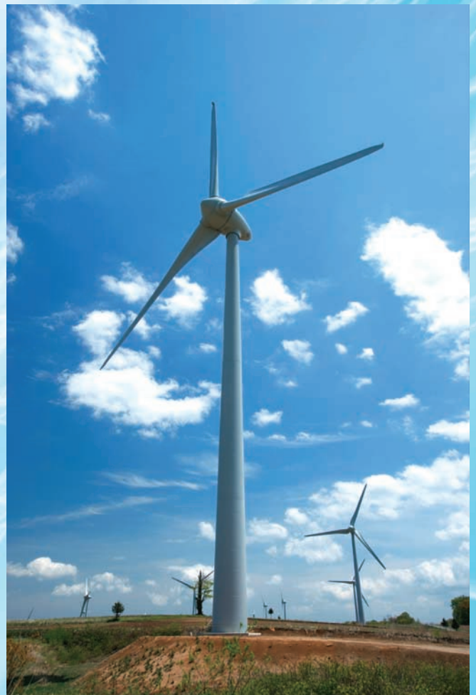
⇧ 風車完成状況
