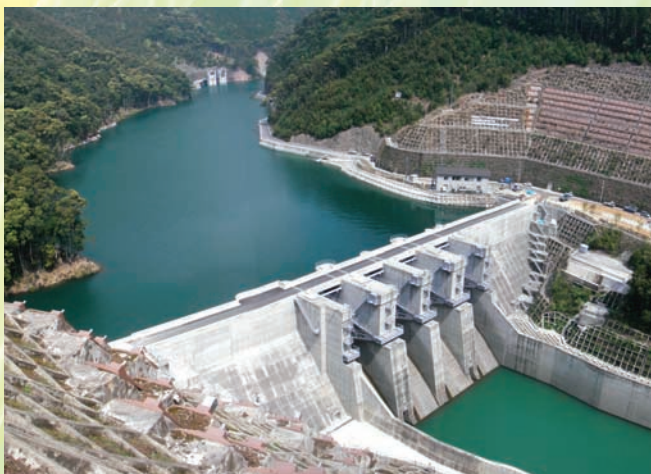
⇧下部ダム（平成 19 年 4 月）
