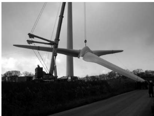
写真—6 ロータ吊り込み状況
