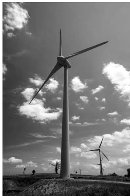
写真—7 風車完成状況
