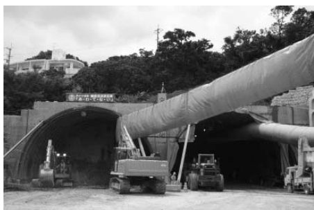
写真—5 識名トンネル坑口部
