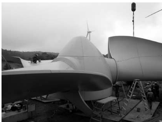
写真—5 ロータ地組立状況
