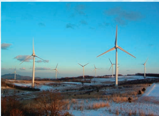
⇧ 2,000 kW 風力発電機
