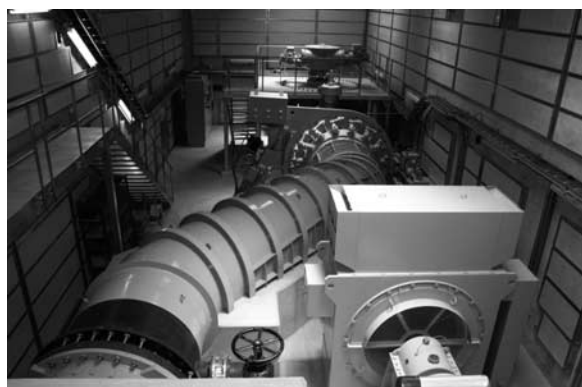
写真—2 発電機・水車 据付完了
