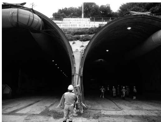
写真—1 豊見城トンネル坑口部
