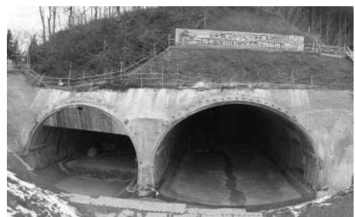
写真—3 北山トンネル坑口部
