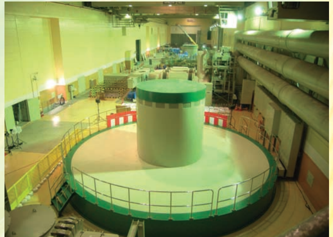
⇧発電所本館全景（平成 19 年 7 月）
