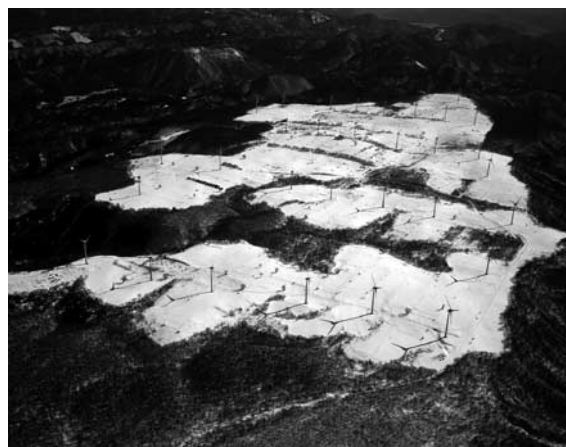
写真—1 発電所全景
