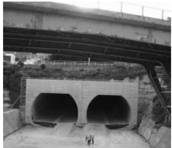
写真—2 坑門工完成後（ボックストンネルと接続）
