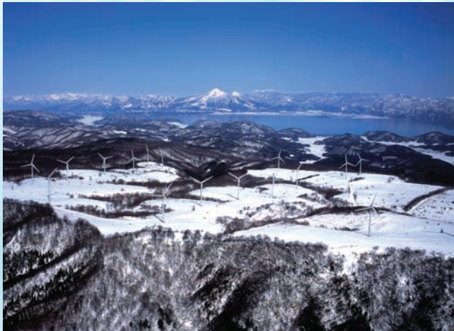
⇧ 風力発電所全景
