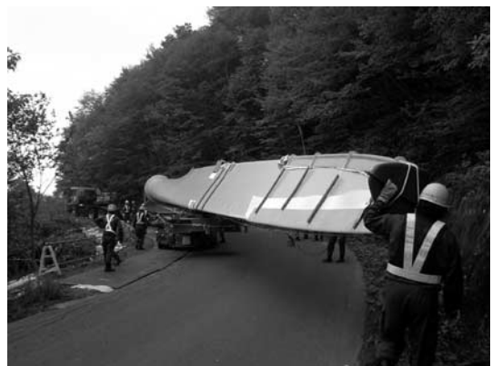
写真—4 ブレード輸送状況
