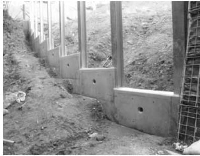
調整コンクリート工
