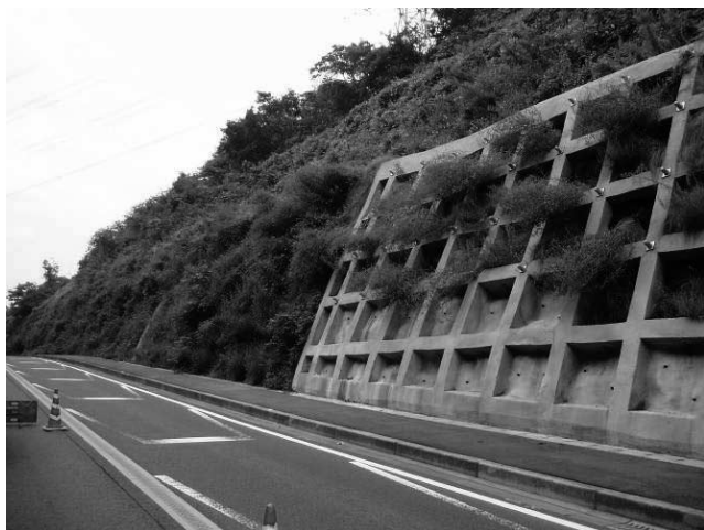
写真一2 アンカー（鉄筋挿入工）併用現場吹付法砕工（手前）とクモの巣ネット工法を施工した法面（奥の植生が繁茂した法面）
