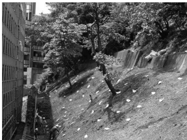
写真—13 高強度ネット張工状況
