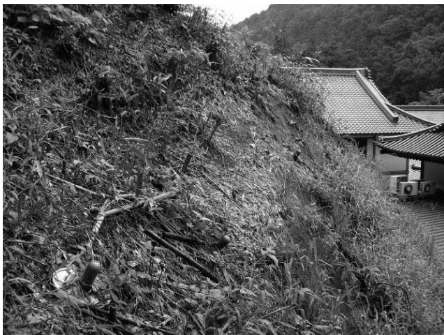
写真—9 施工後約半年経過 植生が繁茂し始め、従来の植生である小隈笹や葉平竹が芽吹いている。
