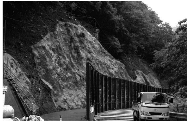
写真—10 施工前の現場全景
