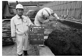
写真一六 不良土コーン指数確認状況
