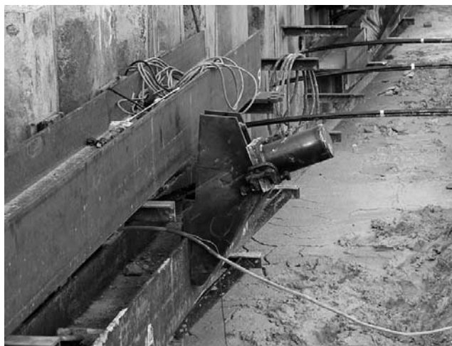
写真一四 高周波電流通電
