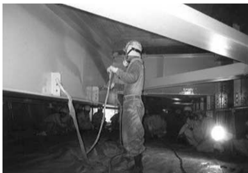
写真— 1 高塗着スプレー塗装作業の様子 7) （塗料のはね返りやミストの浮遊はほとんど認められない）
