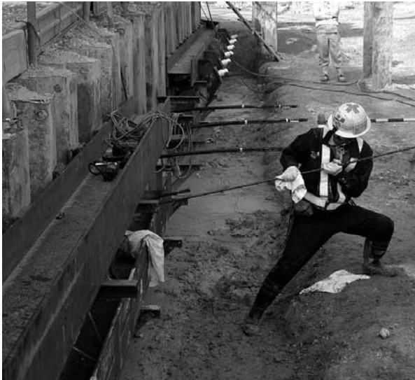
写真一5 人力による引抜き状況
