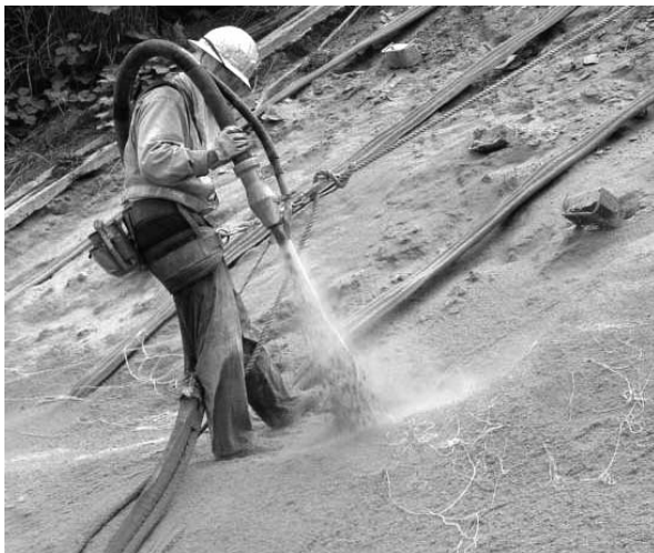
写真—6 長繊維混入補強土吹付状況
