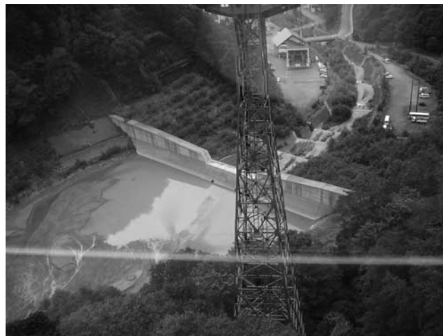
写真一1 着手前の堆積状況（シルト系）
