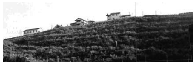
写真—3 宮崎県 霧島台団地における適用事例。アルファグリーン工法にて約 2 万 m 2 を施工した。木本類を中心に生育している。1999 年 4 月施工
