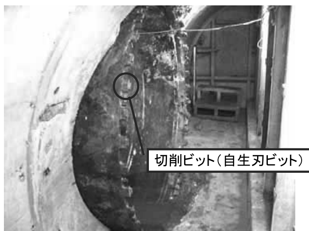
写真—1 T-BOSS 工法到達接合状況
