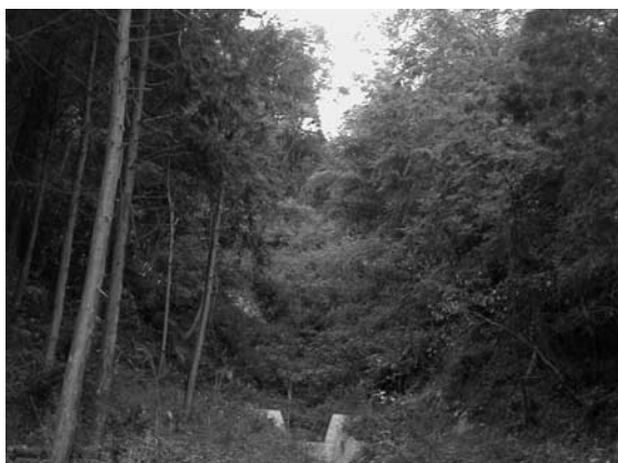
写真—5 高知県 春野町における適用事例。芽苗植栽工と併用した。2002年9月施工
