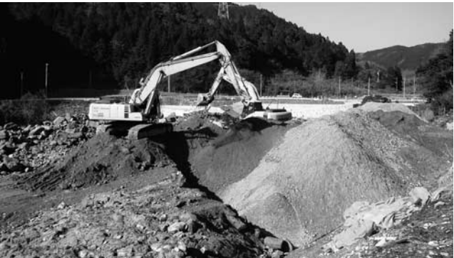
写真―3 スケルトンバックホウによる母材採取
