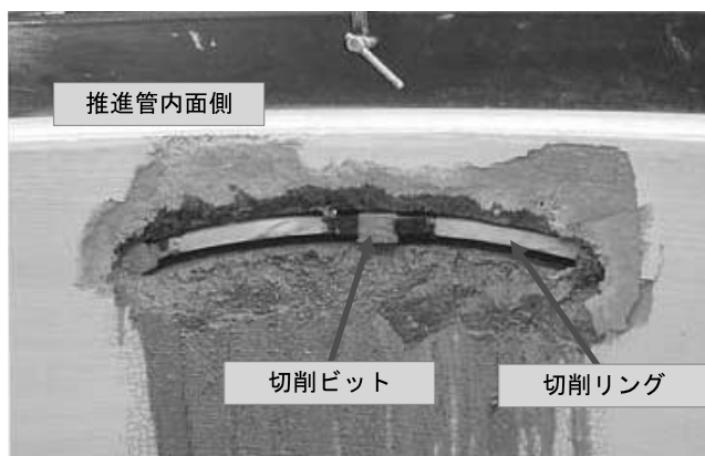
写真—5 貫通状況
