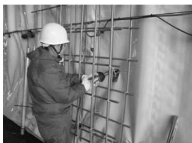
写真—2 補修作業状況
