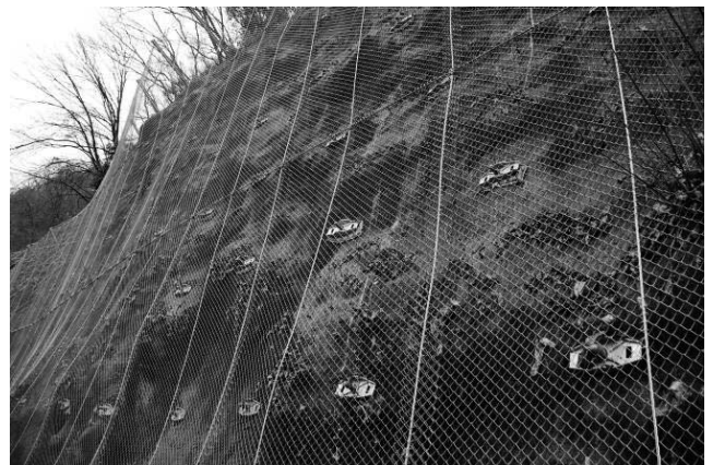
写真—11 施工後の状況 全面には落石防護網が架けられている。
