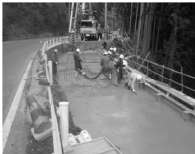
保護コンクリート工
