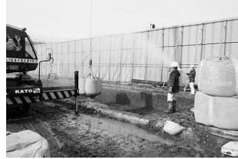
写真一八 固化剤マデックス投入状況
