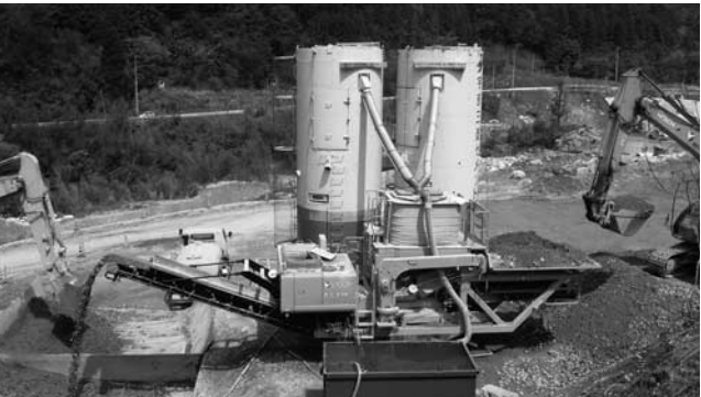
写真―4 自走式土質改良機による CSG 製造
