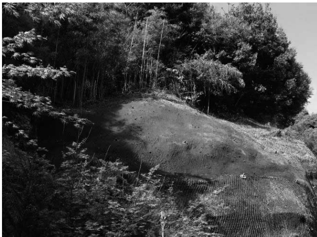
写真—8 施工した全景
