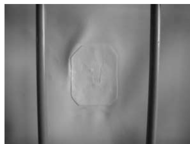
写真—4 補修状況
