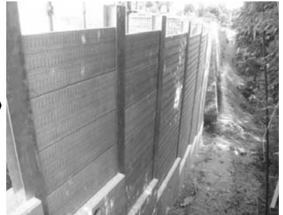
壁面材設置工
