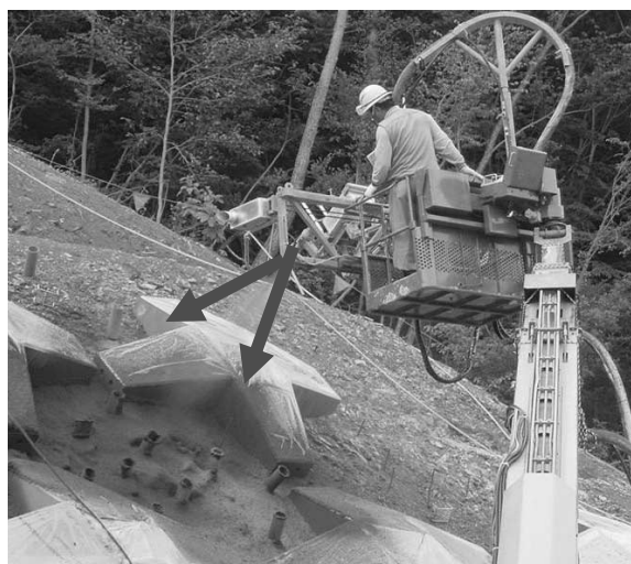
写真—18 高所作業車専用吹付ノズルアタッチメント近景
