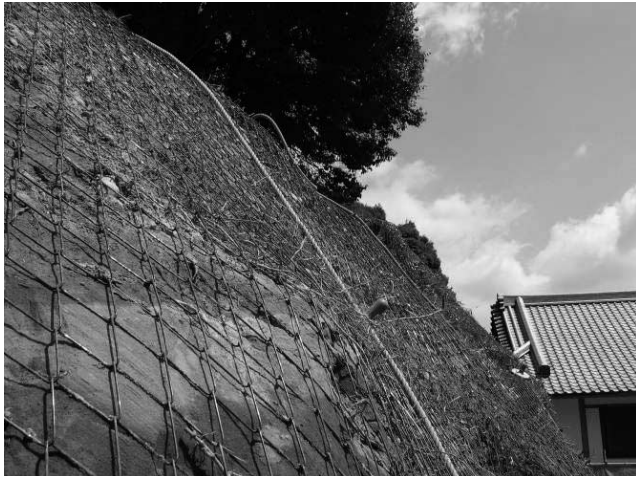
写真—7 地形の切り取りをせずに高強度ネットを張った。植生に必要な土壌が流失している箇所は、植生基盤材を人力で貼り付けた。
