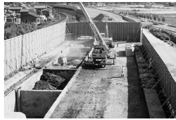
写真一七 固化剤マデックス投入状況
