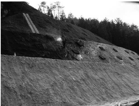
写真一12 無播種での吹付状況
