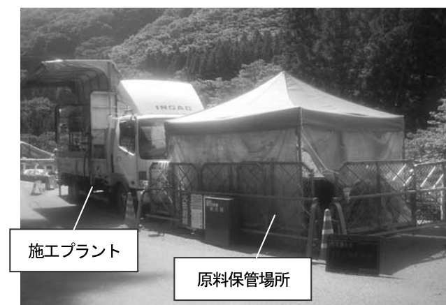
写真—2 施工ヤード設置状況
