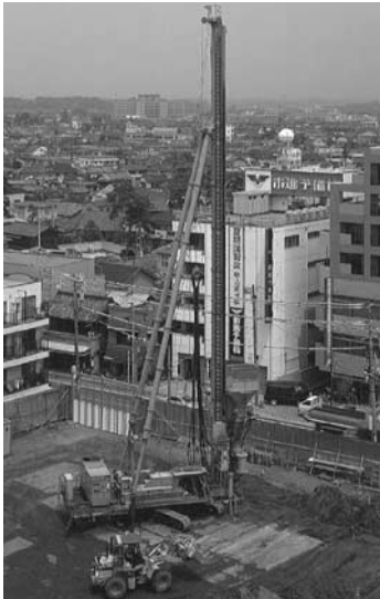
写真-1 市街地での施工状況
