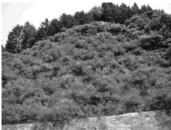
写真—4 宮崎県 高千穂町における適用事例。モルタル吹付面の上に、吹付施工した。1996年6月施工
