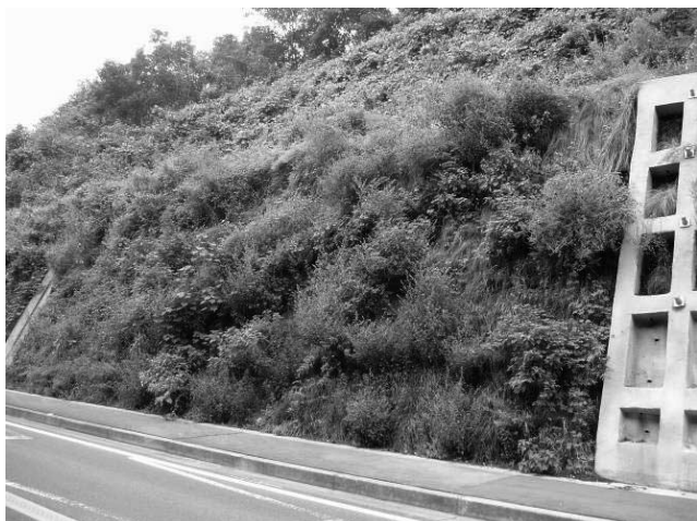
写真一3 植生土のうを積み上げて植生基盤を造成した
