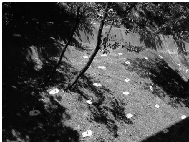
写真—12 ざぶとん材設置状況
