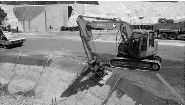
写真―7 コンパクタによる法肩・法面転圧
