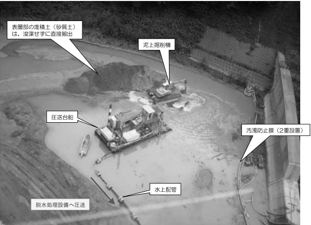
写真-3 泥状掘削機による浚渫作業状況②（シルト系）
