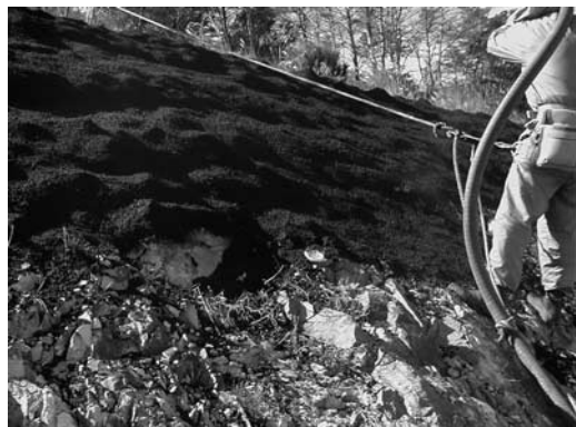
写真一 1 ラス金網張工等の緑化基礎工無しで施工している様子。 吹付材料のリバウンドもほとんどない。
