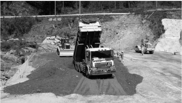
写真―5 製造された CSG の運搬・荷降ろし
