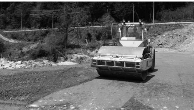
写真―6 10t 振動ローラによる CSG 転圧
