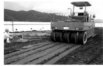
写真一十五 転圧状況
