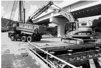
写真一三 不良土積込状況
