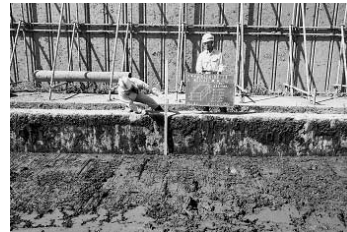
写真一十 改良土土量確認状況
