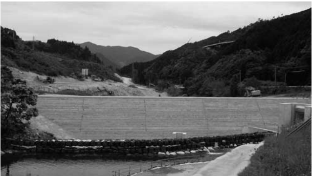
写真―8 CSG 仮締切堤完成写真
