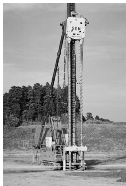
写真—1 SDM 工法施工機械と高圧水噴射状況
