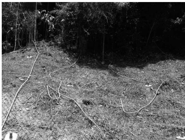
写真一6 冬枯れた下草の上に高強度ネットを張った
