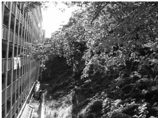
写真—14 施工後半年経過の現場状況 (写真—13と同位置)
