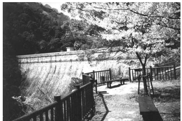
写真-1 下流側よりの布引ダム全景
