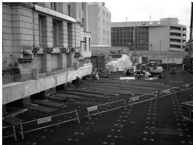
写真-4 一次移動路盤
