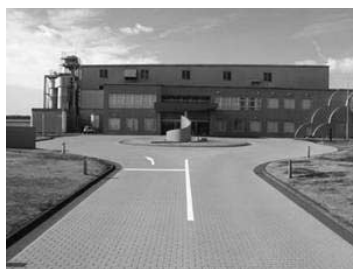
写真-3 ストリートプリント完成写真
