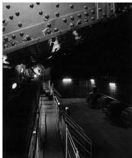
写真—3 橋脚内スペース 橋桁があがると、左上から桁の端部が下りてきて、右側のスッパのところで止まる。
