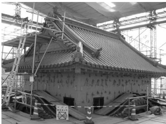
写真—12 天守4層屋根葺完了
