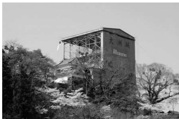
写真—13 素屋根全景
