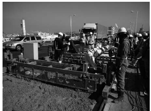
写真一1 SFRC 打設状況
