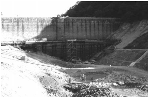
写真—2 バンカー線(作業用構台)全景
