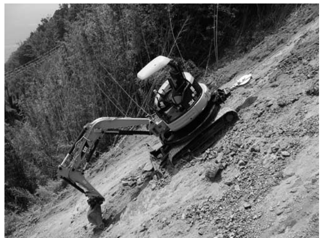
写真－1 掘削・整形作業状況
