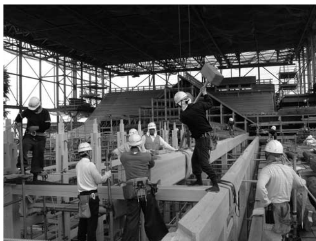
写真—4 本丸御殿大広間建て方作業
