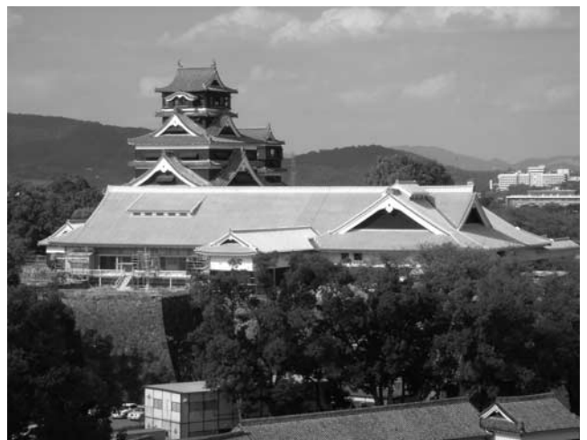
写真—3 天守閣と本丸御殿（手前）
