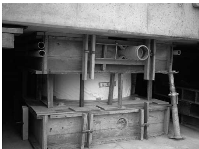
写真—10 免震部材・基礎設置
