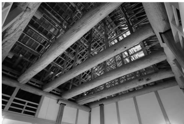
写真—6 大御台所の小屋組み
