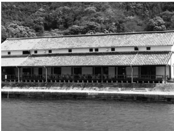
写真—6 修復された三角築港記念館
