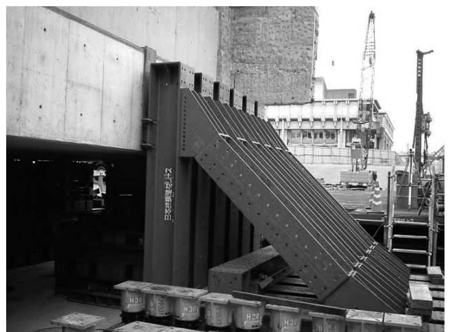
写真—9 水平補強状況
