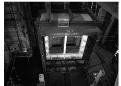
写真—4 発進立坑状況 (刃口部と鋼殻 1R 目)
