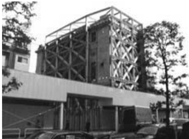
写真—4 仮設鉄骨で補強された保存部
