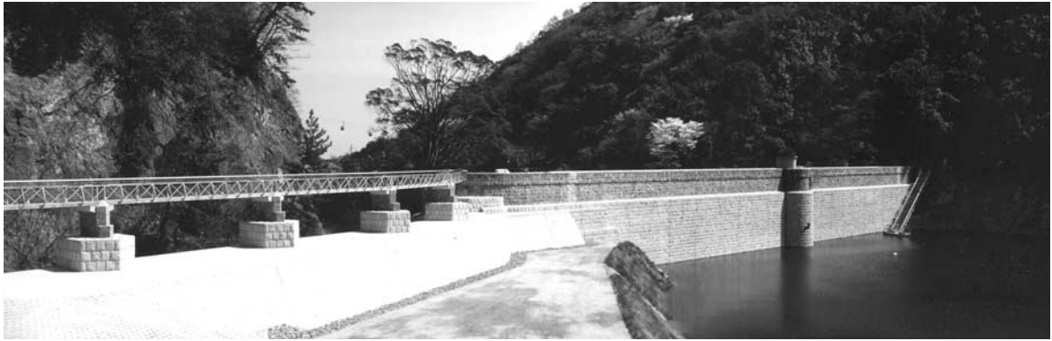
写真—5 管理橋・堤体補強完了全景
