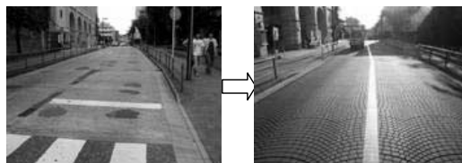
写真-1 施工前（インターロッキングブロック、左）と施工後（ストリートプリント、右）
