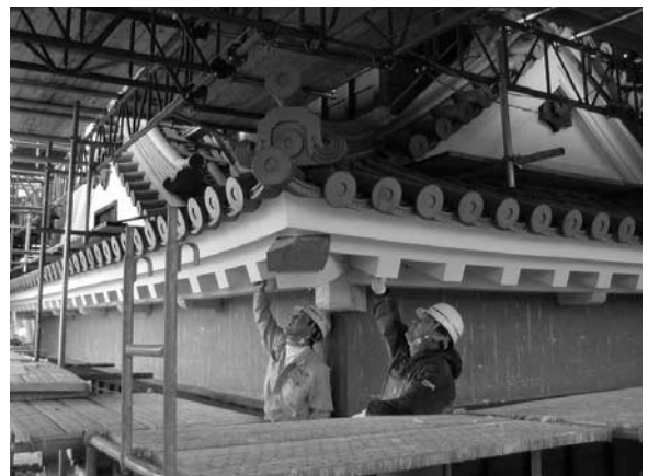
写真—11 天守4層軒揚裏漆喰仕上げ状況
