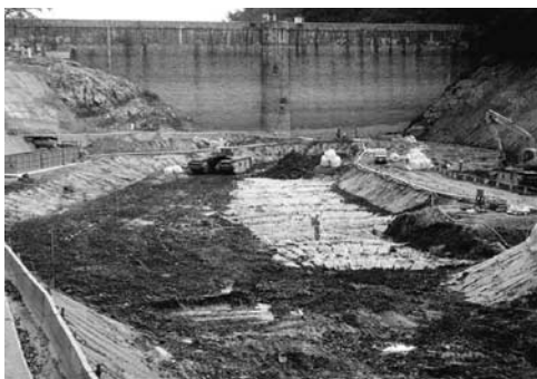
写真—4 軟弱土固化処理状況
