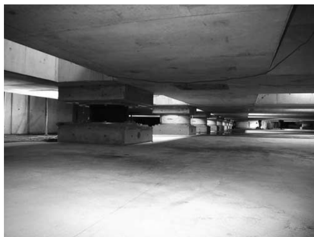
写真—11 免震ピット状況
