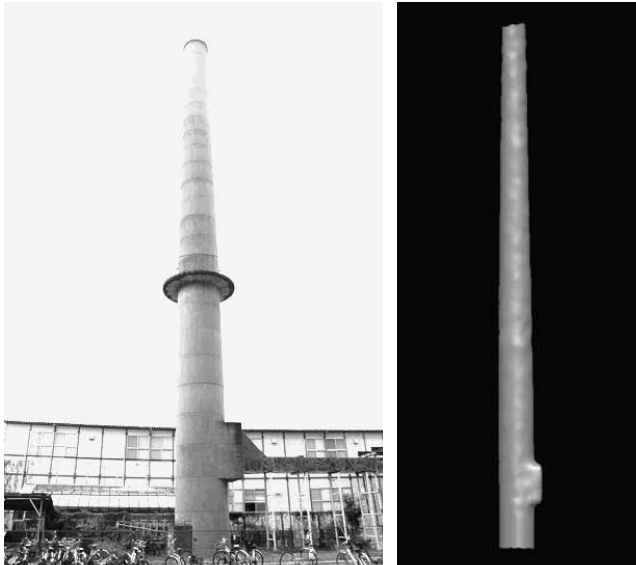
図—10 煙突構造のモデル化
