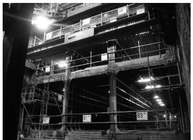
写真—5 掘削完了状況(大阪府内鉄道工事)
