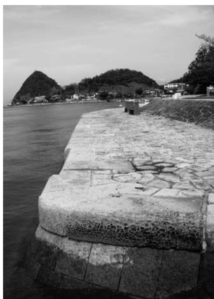
写真—2 修復された石積埠頭
