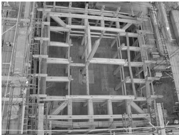
写真—9 天守1層建方状況
