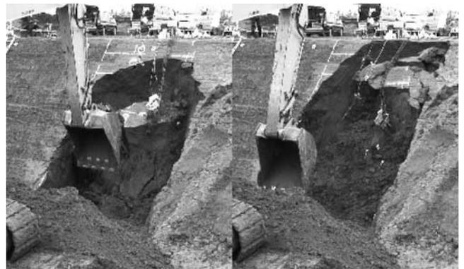
(b) 2回目崩壊 (連続的に法肩まで崩壊)
