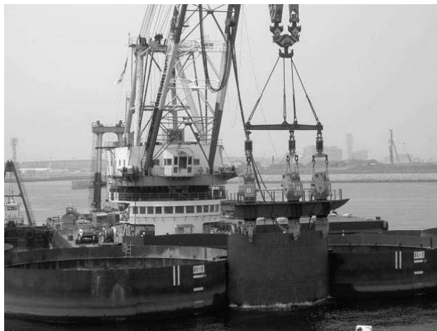
写真—7 アーク打設状況
