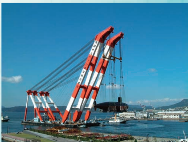
↑てつのくじら館建設 潜水艦吊運搬・起重機船係留
