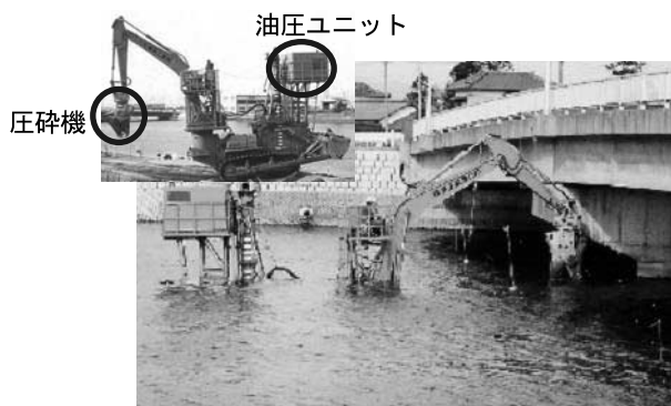
写真一 15 圧砕機による取り壊し状況
