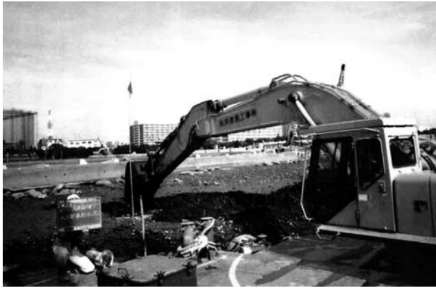
写真—3 既設干潟土砂採取
