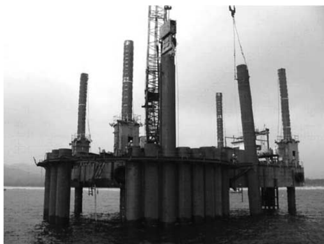
写真ー1 鋼管矢板打設（井筒工法）
