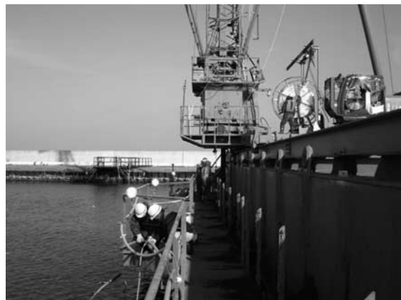
写真一 5 集水管接続状況 (作業足場)
