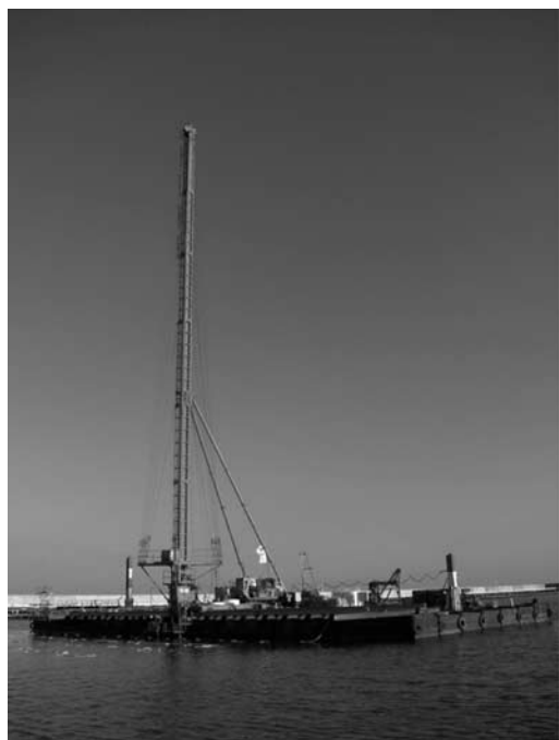
写真-2 連結フロート式ドレーン打設船
