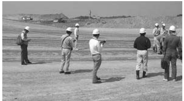
写真—2 造成工事現場
