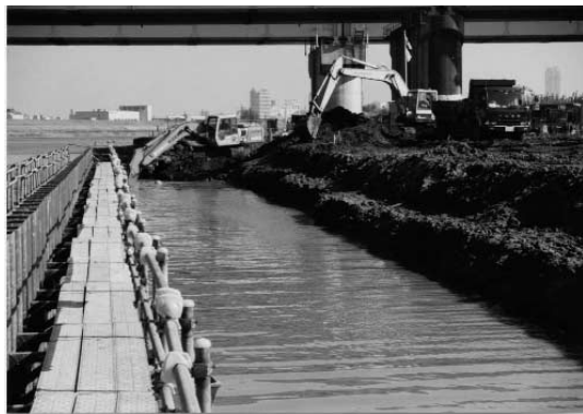
写真—1 先行水中掘削
