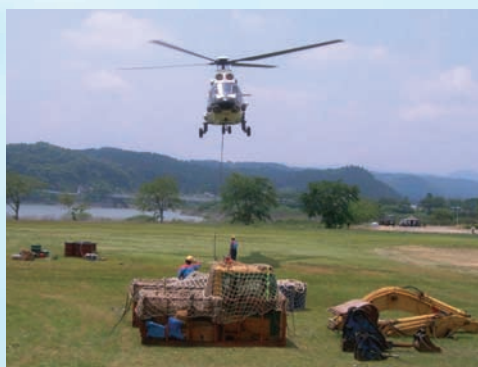
⇧宮城県栗原市花山地区 空輸には、吊り下げ能力約 3 t のヘリを使用（民間機）
