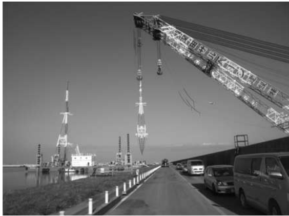
写真—7 起重機船によるリーダー建込状況
