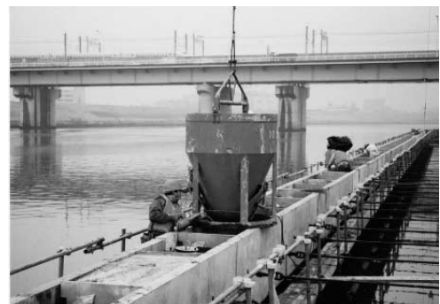
写真—4 中詰めコンクリート打設
