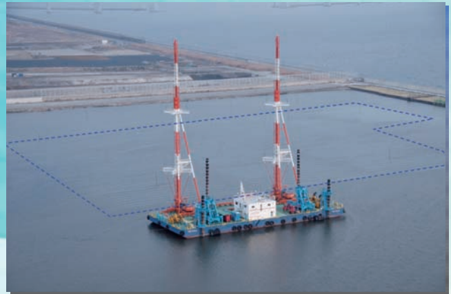
⇧真空圧密ドレーン工法 VCD-Triton 稼働状況
