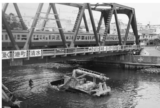
写真—3 橋梁下部の走行状況
