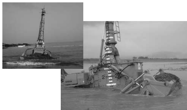
写真—4 掘削押土状況
