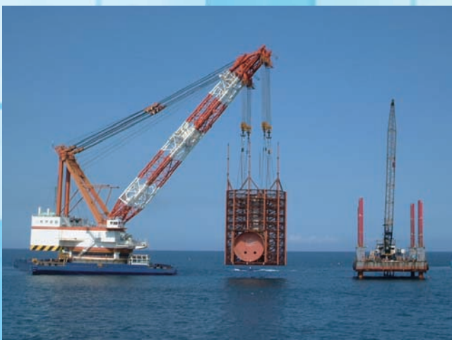
⇧放水路建設工事 J管モジュール沈設
