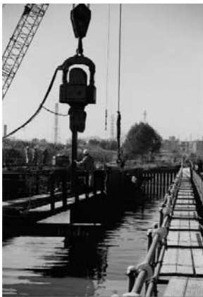
写真—2 鋼矢板一次打設
