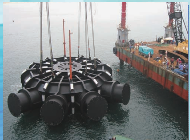
⇧放水路建設工事 マルチノズル放水口設置状況
