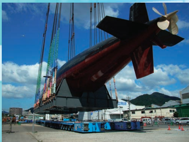
↑てつのくじら館建設 潜水艦ドーリ上搭載
