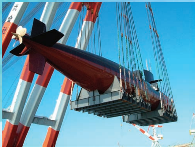
↑てつのくじら館建設 潜水艦海中からの引揚げ
