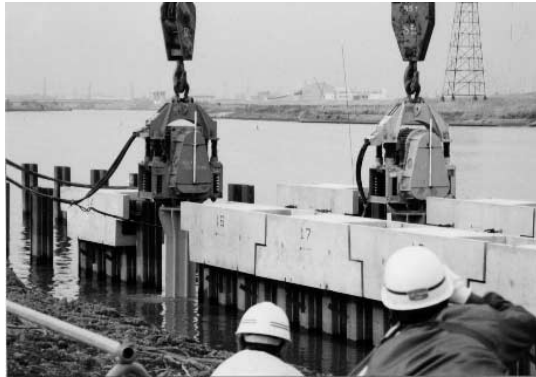
写真9 ユニット打設高さ管理状況
