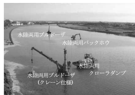
写真—10 水陸両用重機を組合せた作業
