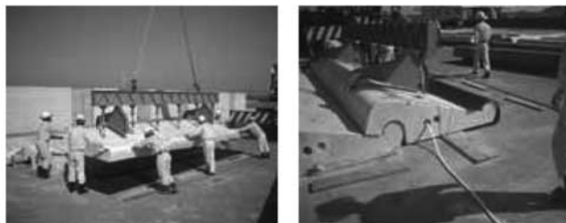
写真—1 ブロック群組み立て状況
