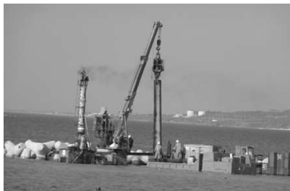
写真一 14 クレーン装置を使った杭打ち状況
