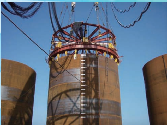
⇧鋼板セル工法 チャッキング作業状況
