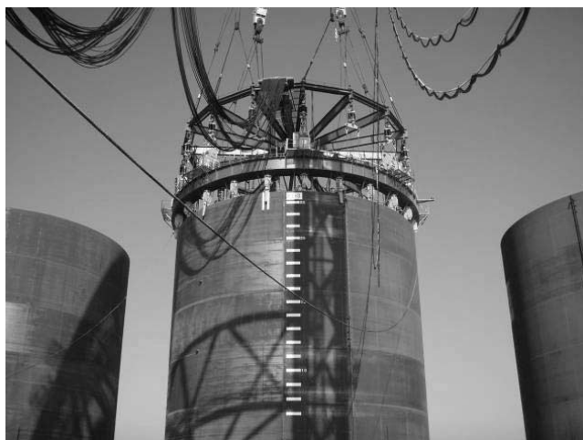
写真-3 チャッキング作業状況
