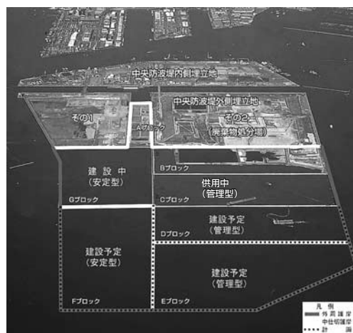
写真—1 新海面処分場全景
