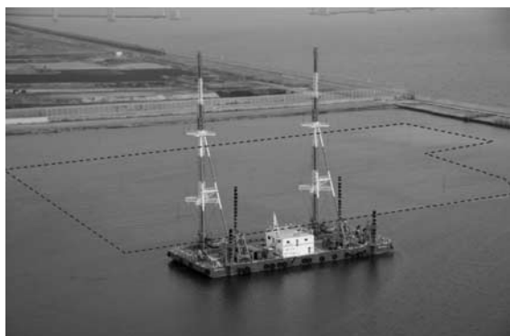
写真—8 VCD-Triton 稼働状況
