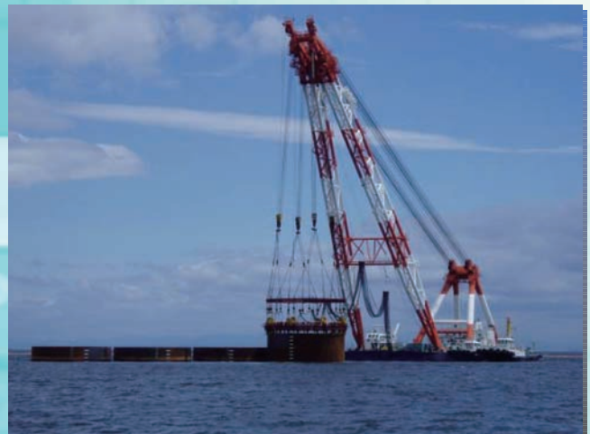
⇧鋼板セル工法 セル打設状況
