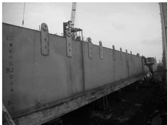
写真一 4 吊環取付状況
