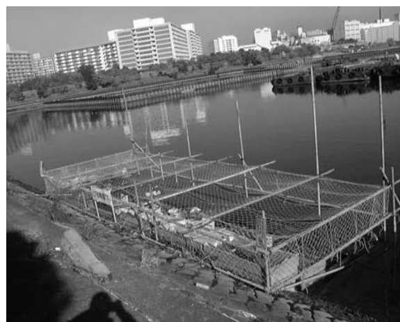
写真一2 覆砂材実験施設配置状況
