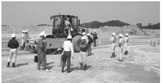
写真—3 造成工事現場
