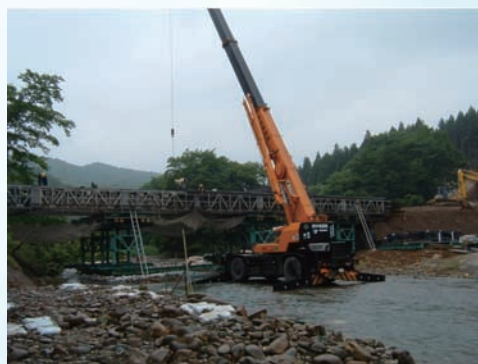
⇧岩手県一関市巖美町市野々原地区 国道 342 号の矢櫃ダム右岸側迂回路に、要請に基づき応急組立橋を貸与。施工は岩手県（東北地整 上路トラス橋 40m）
