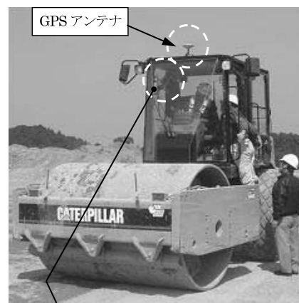
写真-5 振動ローラー
