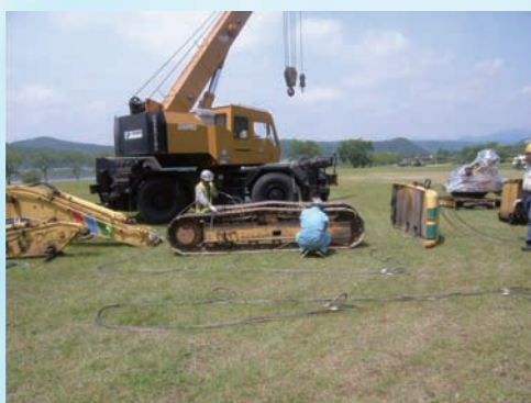
⇧宮城県栗原市花山地区 湯ノ倉地区への空輸のため、分解した遠隔バックホウ（遠隔 BH 0.5m 3 ）
