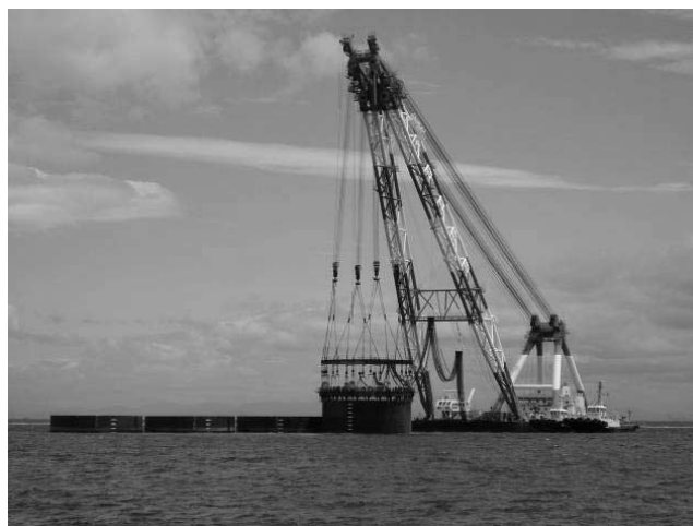
写真-4 セル打設状況
