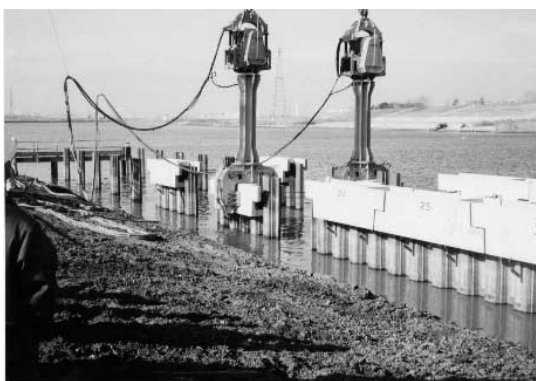
写真—7 後行ユニット打設
