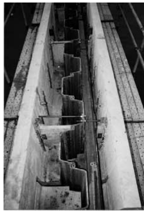
写真—3 PCB 取付
