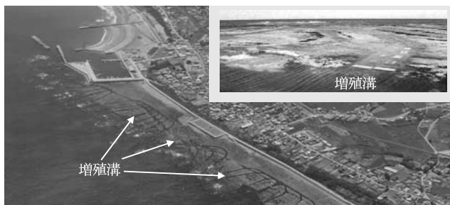
写真—6 ウニの大規模増殖場造成工事
