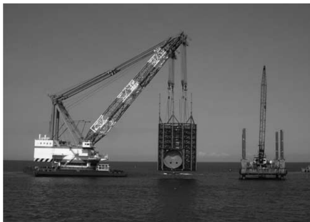
写真ー2 J管モジュール沈設
