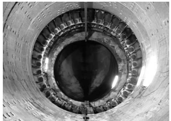
写真-9 シールド機二次解体・接合
