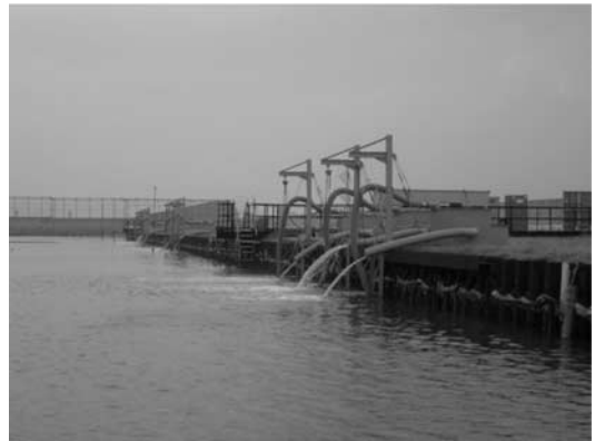
写真—9 負圧載荷状況（真空ポンプ稼働）
