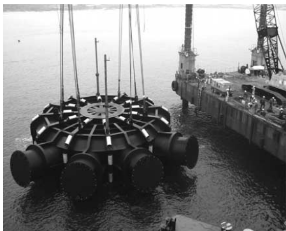
写真—4 マルチノズル放水口設置状況
