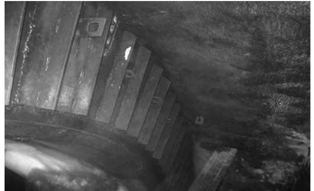
写真-8 止水鉄板取付け状況
