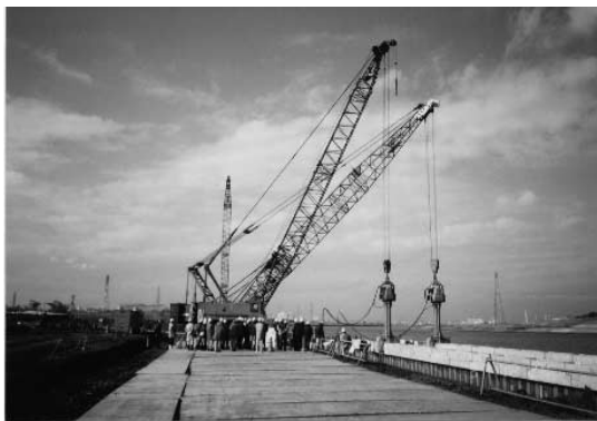
写真—5 ユニット打設（全景）
